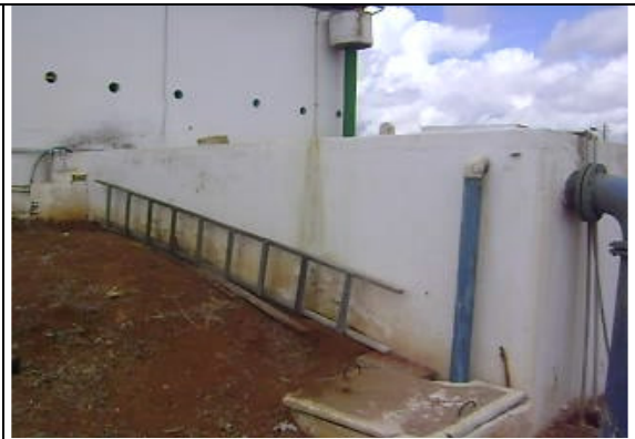
Foto 25 – RSE-01: pintura em bom estado.
