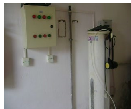
Foto 15 – Sistema de fluoretação paralisado.
