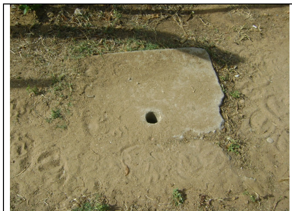
Foto 46 – Registro de descarga localizado na Rua Tomás Catunda, em frente à fábrica de papel.
