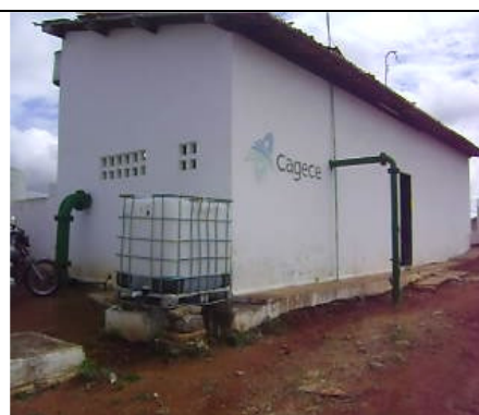
Foto 5 – Vista frontal da Casa de Química da ETA de Caridade.
