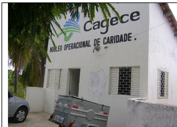
Foto 53 – Vista externa do escritório/loja de atendimento/almoxarifado.
