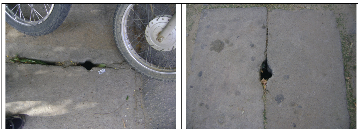
Foto 42 – Registro de manobra localizado na Rua Joana Bittencourt com Rua Cel. Francisco Linhares.
