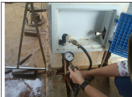
Foto 47 – RDA: medição de pressão no endereço Rua 100, 57 – Conjunto Habitacional.
