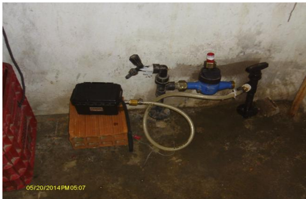
Foto 88 – Medição de pressão com instalação às 17:15h do dia 20/05/14 e retirada às 17:15h do dia 22/05/14, com aparelho datalogger na Rua Rodolfo Pessoa (FNS 12) – Bairro Sabiá.
