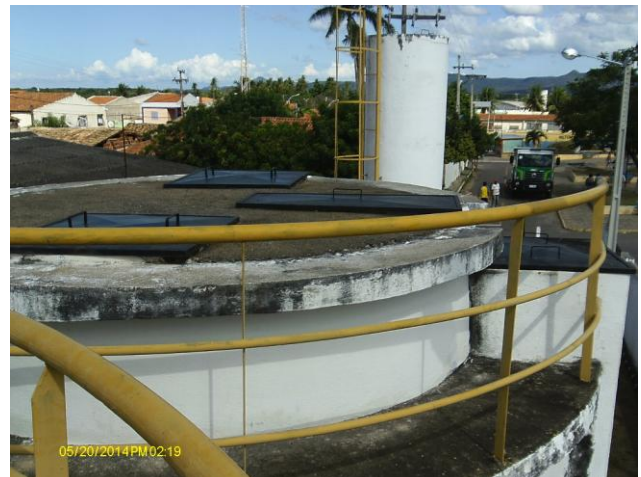
Foto 13 – Guarda-corpos nas instalações do Filtro 01 e tampas adequadas.
