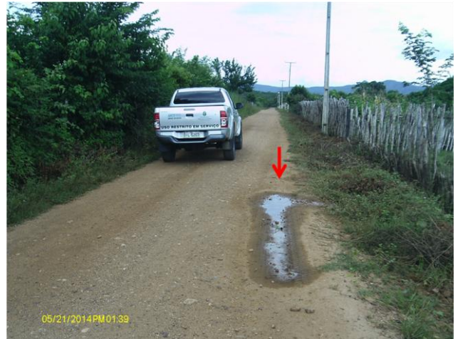
Foto 43 – Vazamento na rede de água tratada próximo a casa (FNS – 25) na localidade Barra do Mel.
