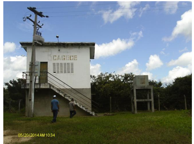
Foto 2 – Vista geral da captação.
