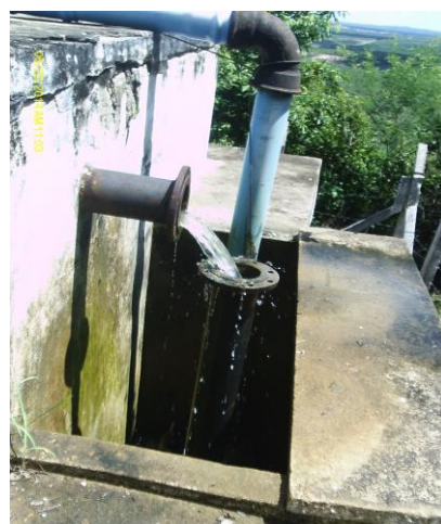
Foto 64 – RAP-01 – tubo extravasor e descarga de fundo.
