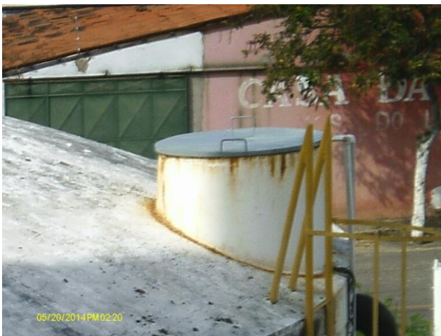
Foto 67 – RAP-02: tampa de inspeção.
