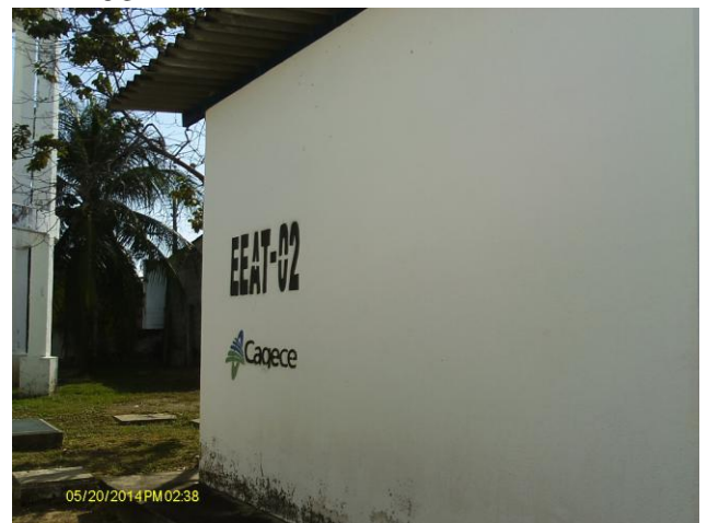
Foto 58 – Prédio de abrigo da elevatória EEAT-02.
