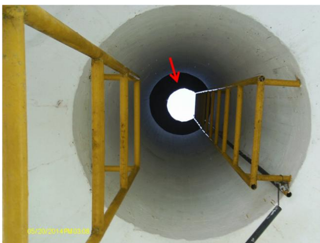
Foto 81 – REL-02: com tampa de inspeção aberta.
