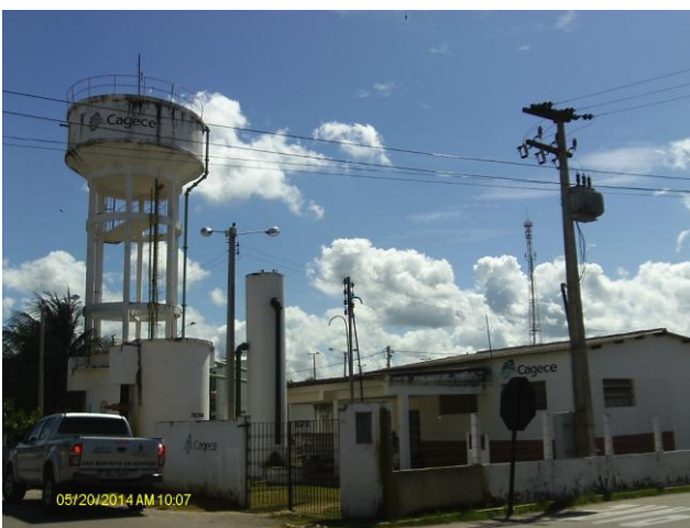
Foto 10 – Vista externa da ETA.
