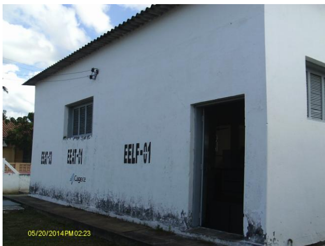
Foto 55 – Prédio de abrigo das elevatórias EELF-01, EEAT-01 e EEAT-03.
