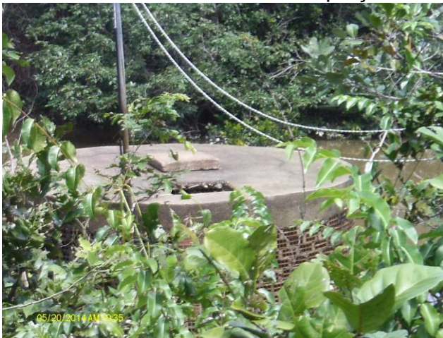
Foto 3 – Poço Amazonas as margem do Rio Coreaú.
