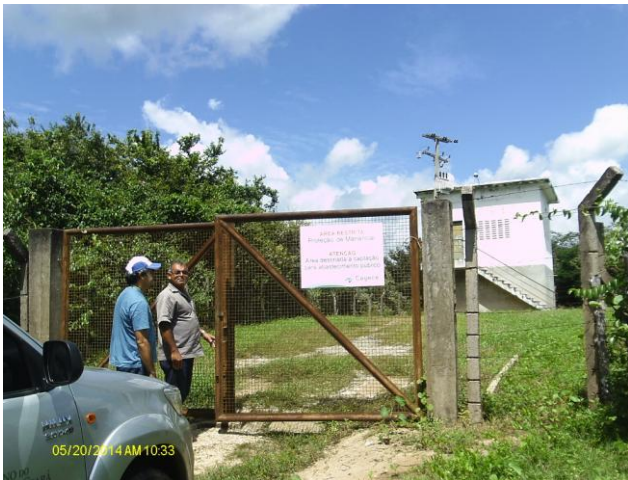
Foto 1 – Entrada de acesso a captação.
