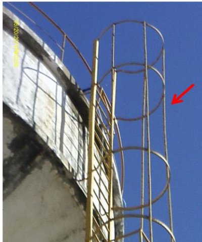
Foto 73 – REL-01: escada de acesso com guarda-corpos.
