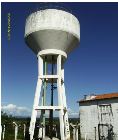
Foto 79 – REL-02: vista geral.
