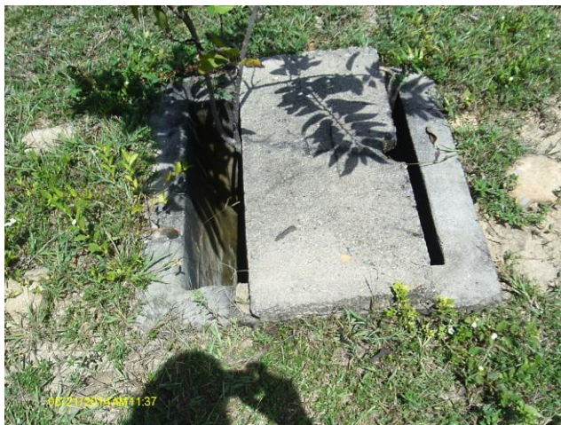
Foto 38 – Caixa de ventosa aberta na rede de água tratada na localidade Barra do Mel.
