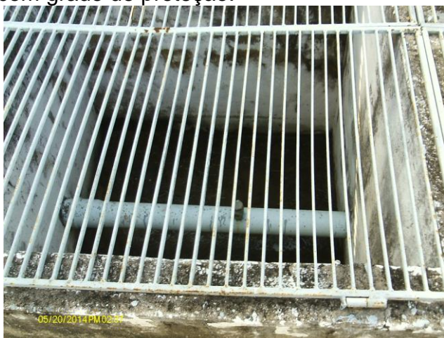
Foto 50 – Caixa de estação pitométrica na adutora de água tratada na área da ETA, com grade de proteção.
