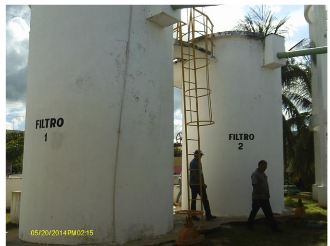
Foto 11 – Vista dos Filtros 01 e 02.
