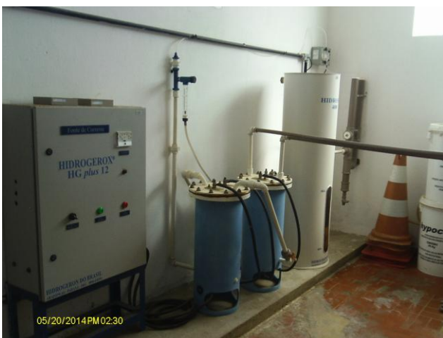
Foto 22 – Casa de química: fábrica de cloro.
