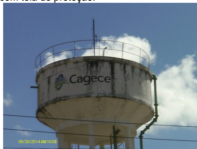
Foto 70 – REL-01: guarda-corpos na laje de cobertura.
