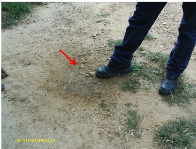
Foto 44 – Vazamento na rede de água tratada em frente a casa (FNS – 25) na localidade Barra do Mel.
