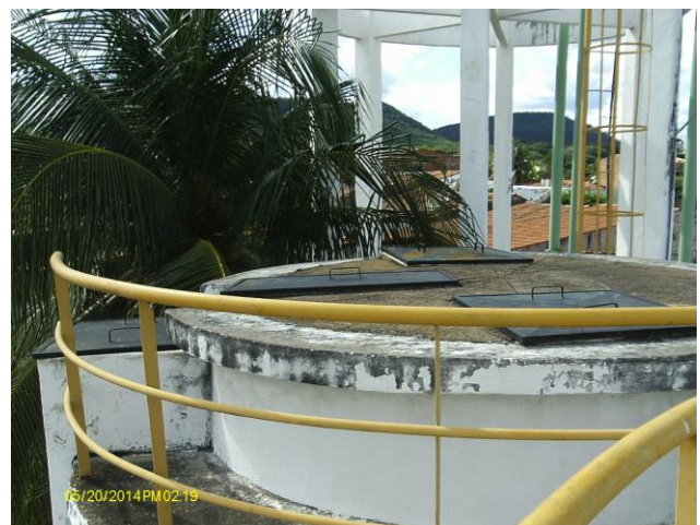
Foto 15 – Guarda-corpos nas instalações do Filtro 02 e tampas adequadas.
