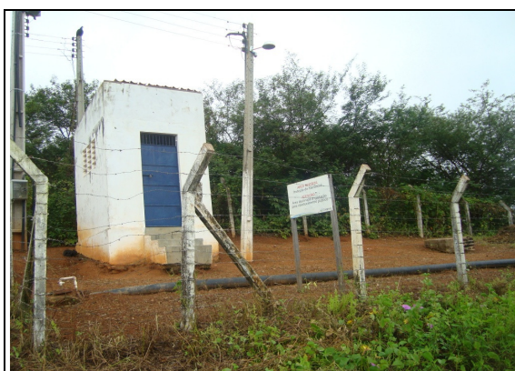
Foto 35 – Casa de comando da EECS-01 sem iluminação elétrica.
