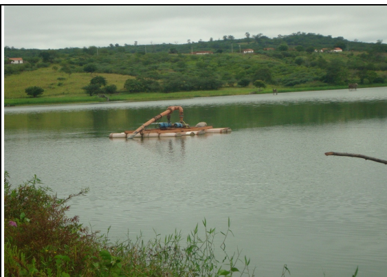
Foto 2 – Flutuante com dois conjuntos motores-bomba do SAA de Quiterianópolis.
