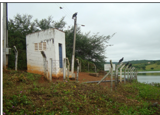
Foto 4 – Área de captação do SAA de Quiterianópolis sem limpeza.
