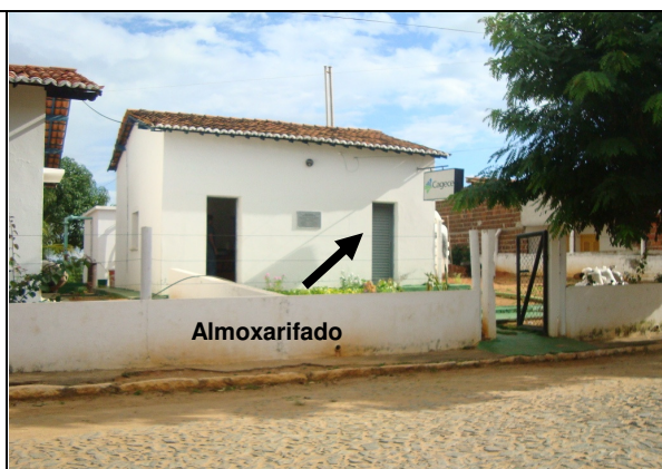
Foto 80 – Vista externa do escritório/loja de atendimento/almoxarifado.
