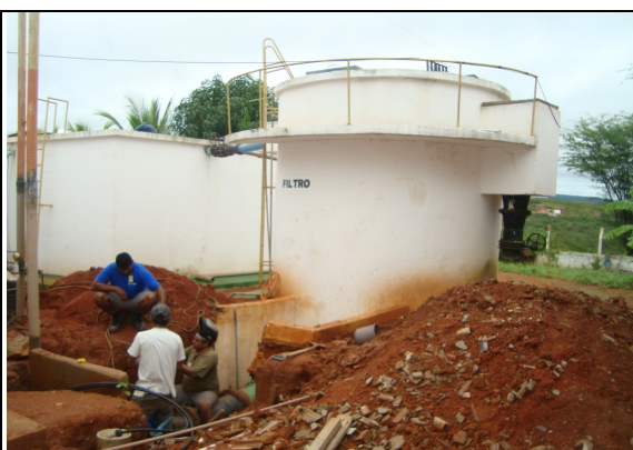
Foto 15 – Execução dos serviços do mecanismo de lavagem do filtro de pressão.
