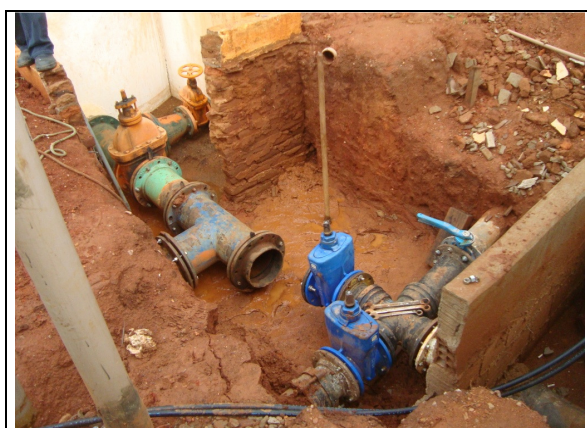
Foto 77 – Serviços de instalação de mecanismo de lavagem do filtro de pressão.
