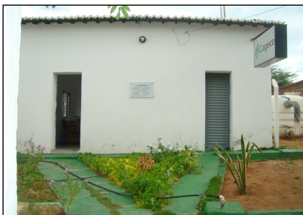
Foto 79 – Vista externa do escritório/loja de atendimento/almoxarifado.
