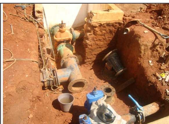
Foto 78 – Serviços de instalação de mecanismo de lavagem do filtro de pressão.
