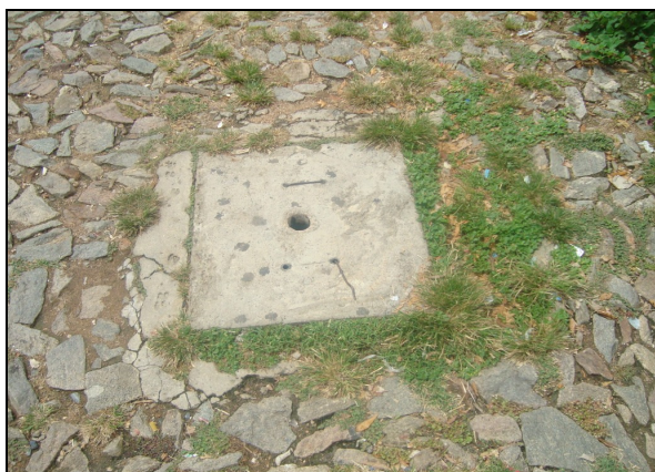
Foto 72 – Registro de manobra localizada na Rua Acadêmico Deusdete Pedrosa esquina com a Rua São José.
