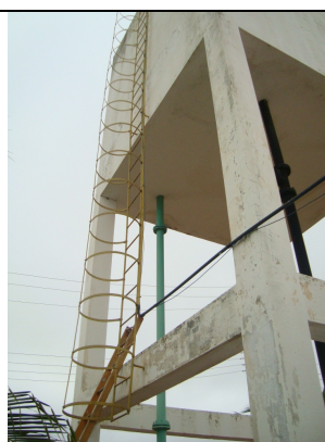
Foto 56 – REL-01: escada de acesso com gaiola protetora.
