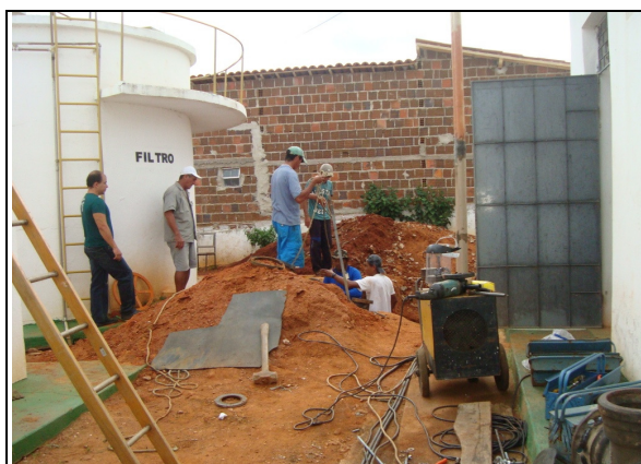
Foto 75 – Serviços de instalação de mecanismo de lavagem do filtro de pressão.
