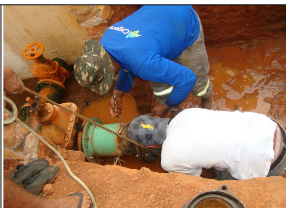
Foto 76 – Serviços de instalação de mecanismo de lavagem do filtro de pressão.
