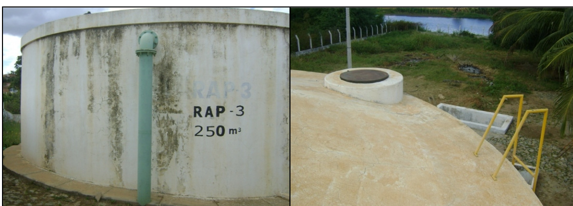
Foto 51 – Identificação do RAP-03.
