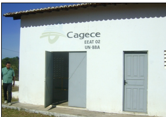
Foto 44 – Prédio de abrigo do Booster .
