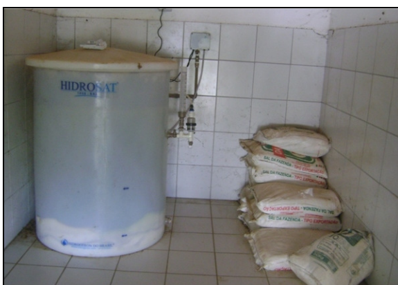
Fotos 19 e 20 – Vistas da fábrica de cloro.
