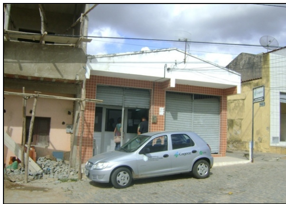
Foto 77 – Vista externa do escritório da CAGECE.
