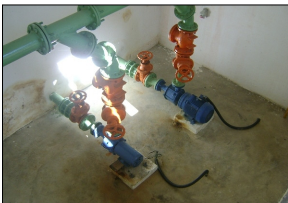
Foto 42 – Elevatória Booster .
