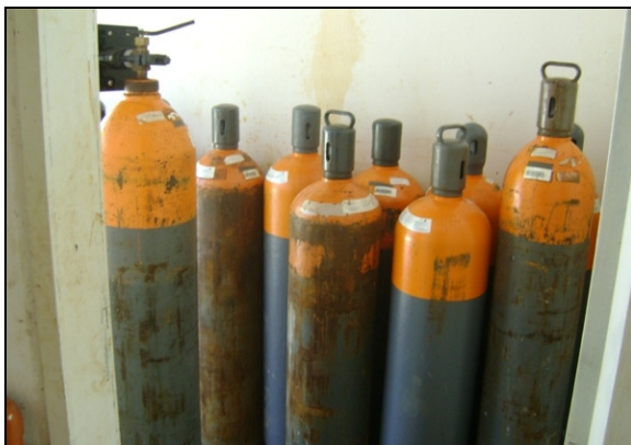
Fotos 17 – Cilindros de cloro gasoso.
