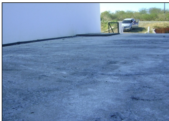
Foto 67 – Inspeção do RSE-01.
