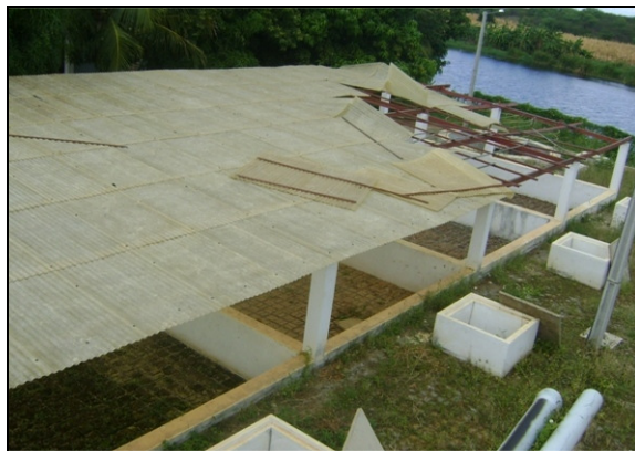
Foto 10 – Vista dos leitos de secagem.
