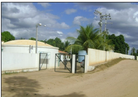
Foto 2 – Entrada da ETA.
