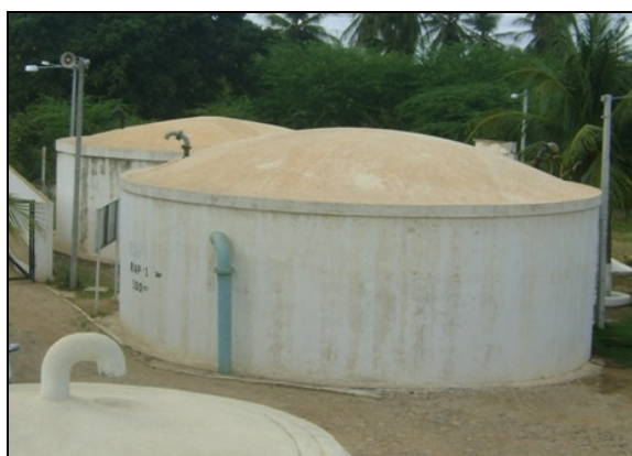
Foto 46 – Vista dos RAP-01 e RAP-03.
