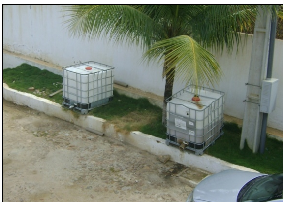
Fotos 21 – Armazenamento inadequado de materiais e produtos químicos.
