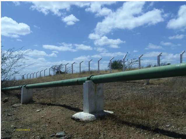
Foto 40 - Adutora de Água Bruta: AAB-01.
