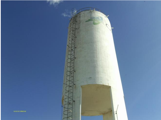
Foto 79 - REL-03: escada de acesso.
