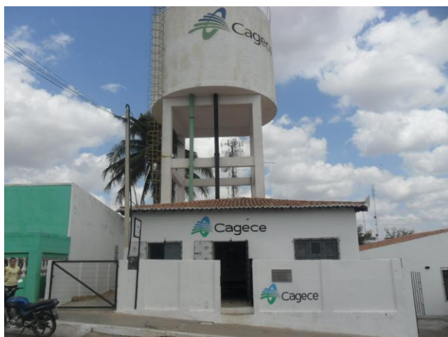
Foto 99 - Escritório: vista externa.
