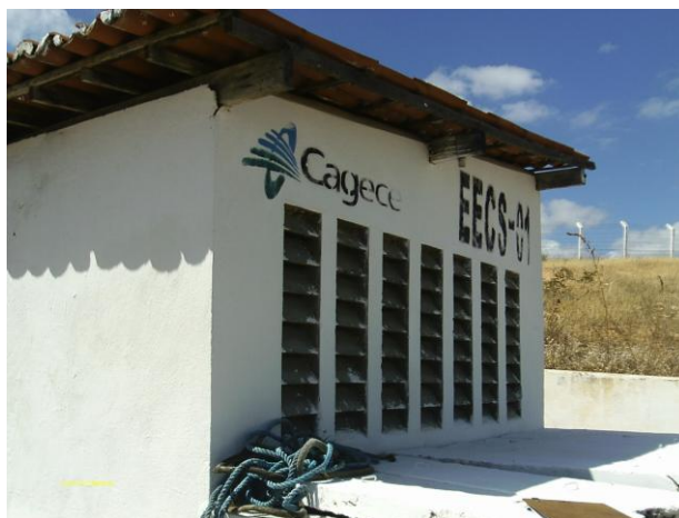
Foto 4 - Casa de abrigo do quadro de comando da EECS-01.
