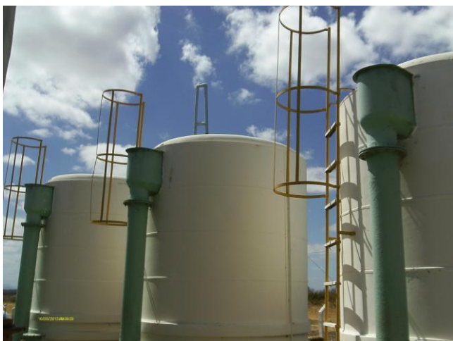
Foto 17 - Escada de acesso dos Filtros F-04, F-05 e F-06.
