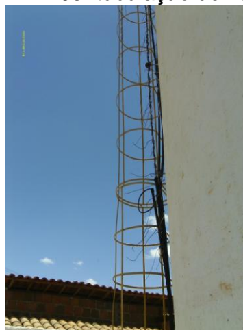
Foto 72 - REL-01: escada de acesso.
