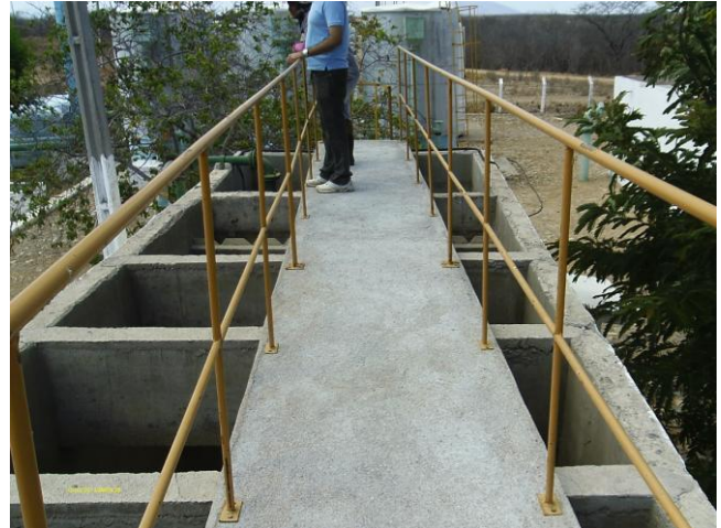
Foto 10 - Passarelas com guarda-corpo.
