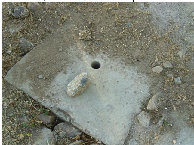
Foto 96 - Registro de Descarga na Rede: Rua Luiza de Oliveira Muniz.
