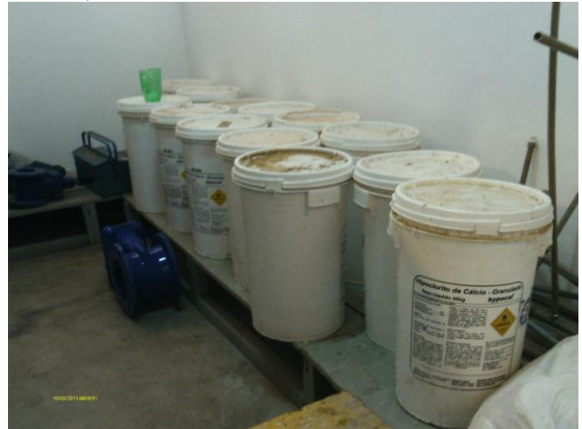
Foto 24 - Casa de química: almoxarifado para produtos químicos.
