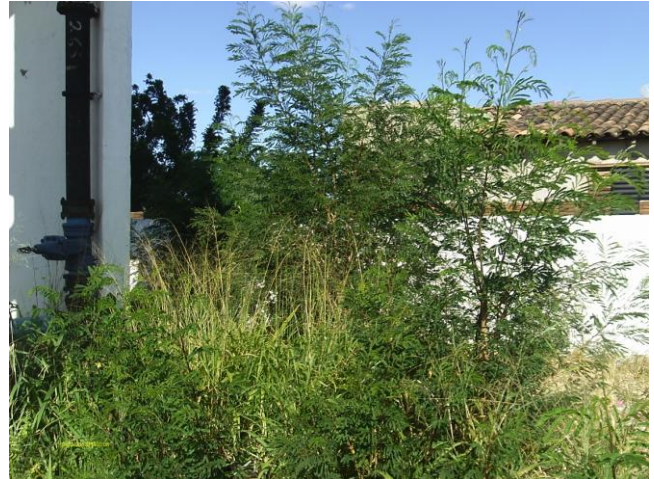
Foto 80 - REL-03: vegetação excessiva na área do reservatório.
