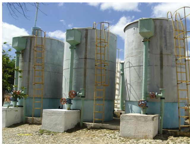
Foto 18 - Escadas de acesso dos Filtros F-01, F-02 e F-03.
