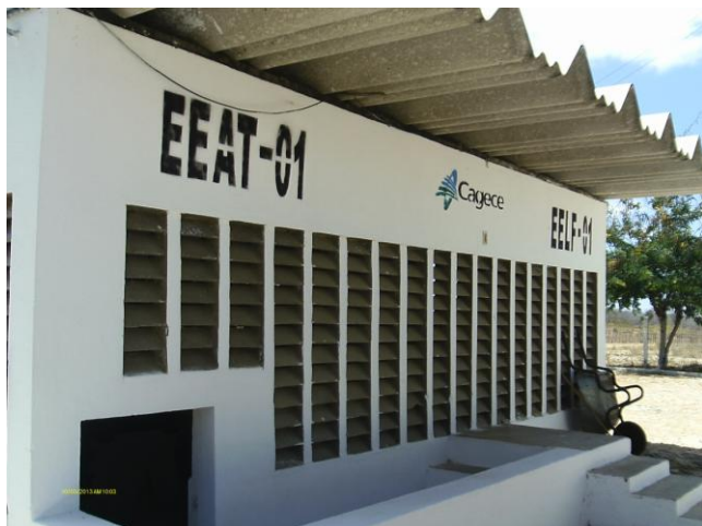
Foto 43 – Identificação EELF-01 e EEAT-01.
