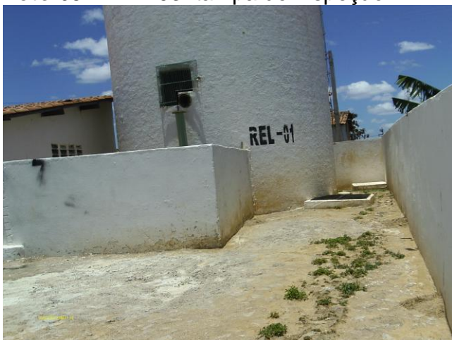
Foto 71 - REL-01: identificação desatualizada no Croqui.
