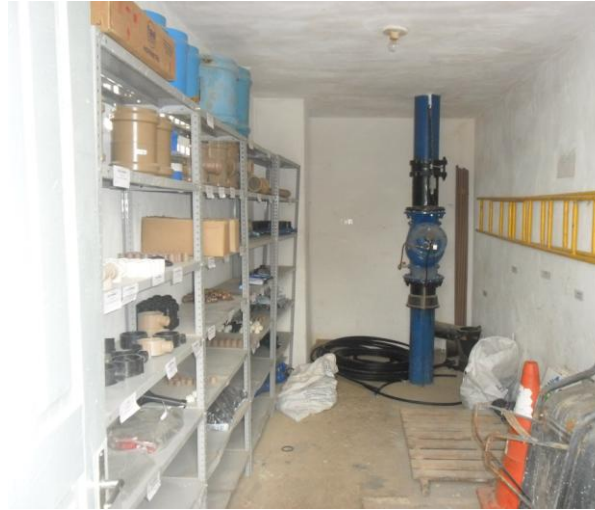
as Foto 108 - Almoxarifado: Limpeza e arrumação.
