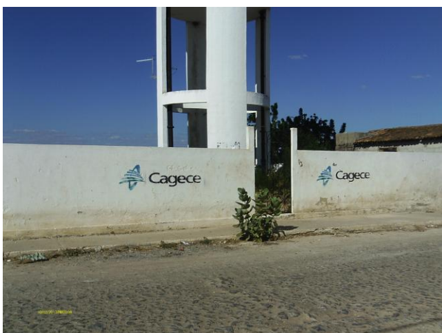
Foto 77 - REL-03: área delimitada e isolada.
