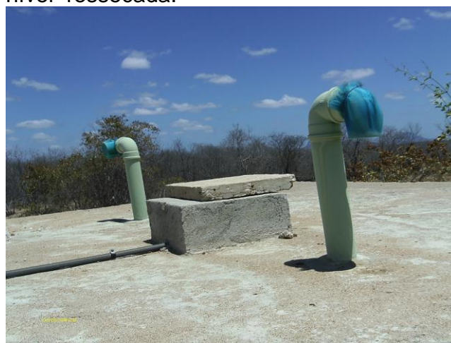
Foto 64 - RAP-02: tubulação de ventilação e tampa de inspeção.
