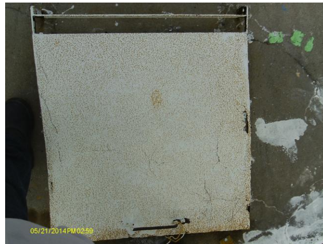
Foto 16 – REL-03: tampa de inspeção.
