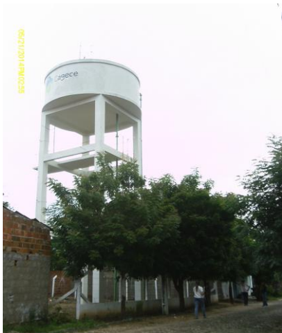
Foto 13 – REL-03: vista geral e acesso principal.
