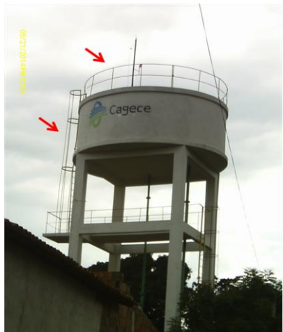
Foto 15 – REL-03: escada de acesso e laje de cobertura com guarda-corpos.
