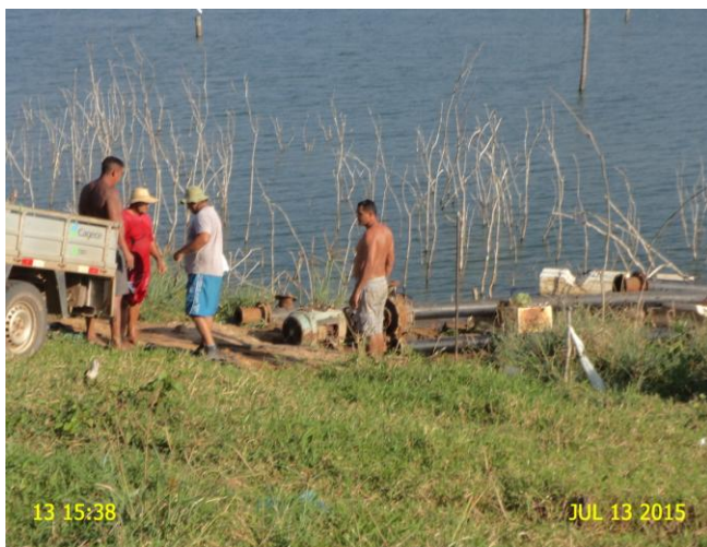
Foto 1 – EECS: manutenção corretiva no conj. Motor-bomba.
