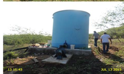
Foto 2 – EECS: manutenção corretiva no conj. Motor-bomba.
