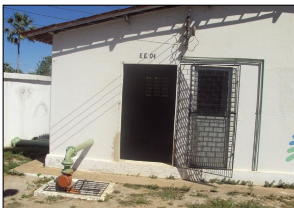
Foto 21 – Casa de comando das elevatórias.
