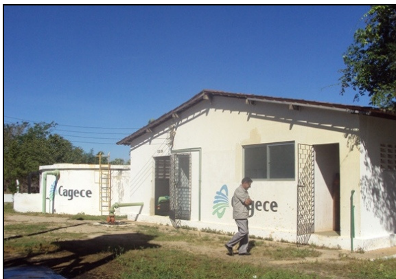
Foto 9 – Casa de química.
