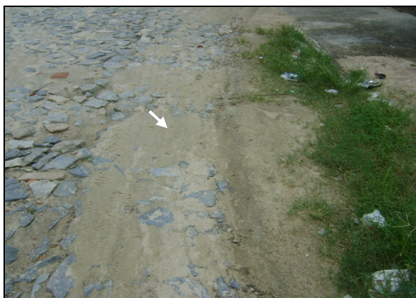
Foto 52 – Registro de descarga soterrado, localizado na Rua Manoel Paz.
