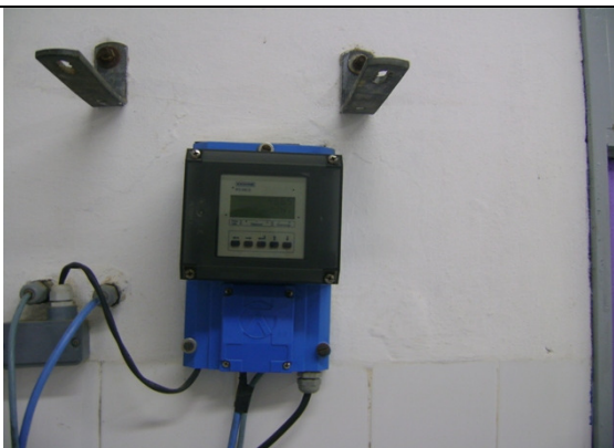
Foto 26 – Macromedidor eletromagnético instalado na entrada da ETA, com monitor de leitura situado no laboratório.
