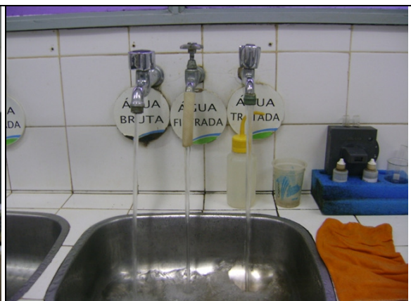
Foto 10 – Vista do laboratório da ETA.
