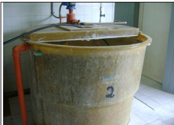
Foto 23 – Tanque de mistura da solução de hipocal.
