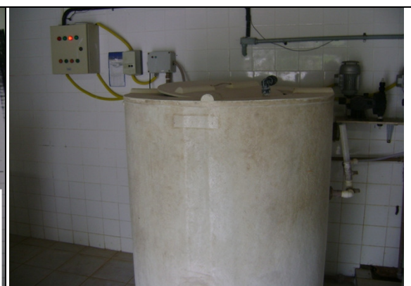
Foto 20 – Sistema de fluoretação.
