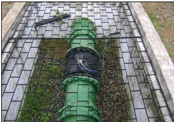
Foto 26 – Macromedidor eletromagnético instalado na entrada da ETA, com monitor de leitura situado no laboratório.
