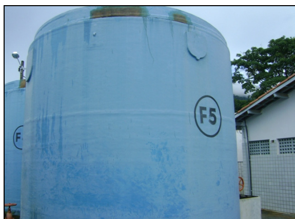
Foto 8 – Vista do Filtro 5.
