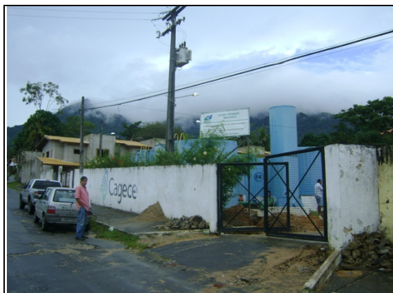
Foto 1 – Vista da ETA.
