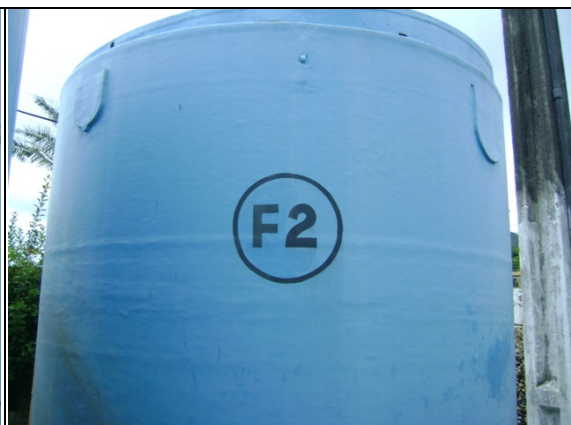
Foto 5 – Vista do Filtro 2.
