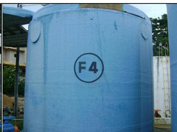
Foto 7 – Vista do Filtro 4.
