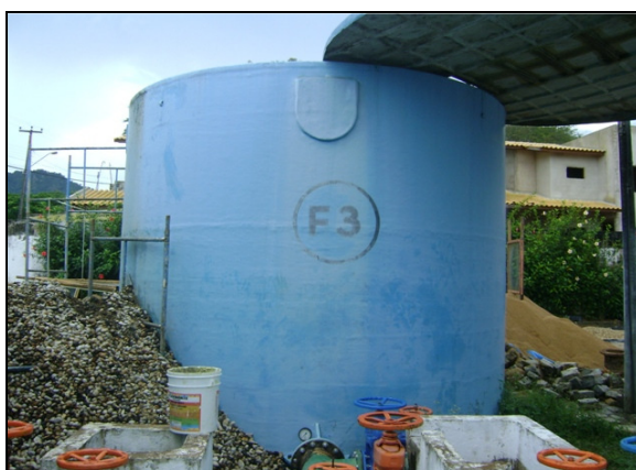
Foto 6 – Filtro 3: Em manutenção.
