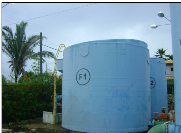
Foto 4 – Vista do Filtro 1.
