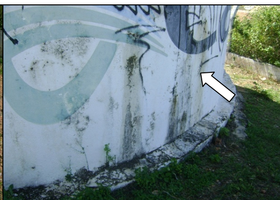
Foto 39 – Tampa de inspeção e ventilação do RAP-02.
