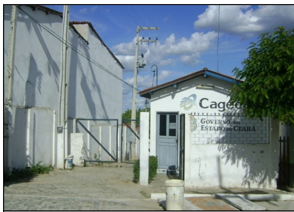
Foto 60 – Vista externa do escritório da CAGECE.
