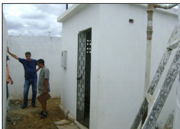
Foto 32 – Prédio de abrigo da EEAT-03.
