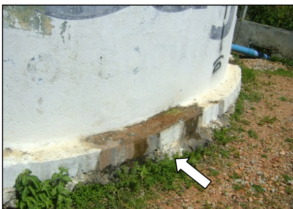
Fotos 40 e 41 – Infiltrações na parede do RAP-02.
