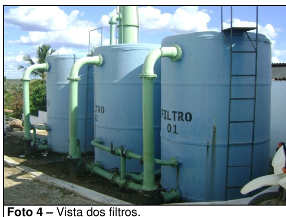
Foto 4 – Vista dos filtros.
