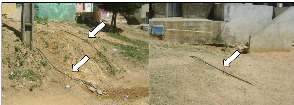
Fotos 58 e 59 – Ligações de água expostas, Alto do Cruzeiro.
