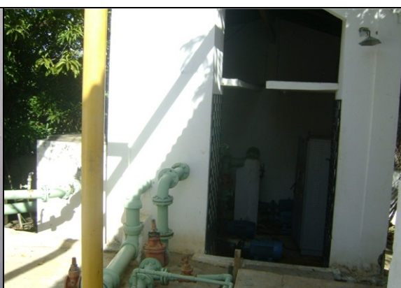
Foto 29 – Prédio de abrigo das EEAT-01 e EEAT-02.
