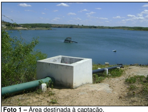
Foto 1 – Área destinada à captação.
