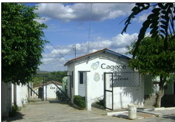
Foto 2 – Entrada da ETA.
