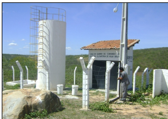
Foto 24 – Prédio de abrigo do quadro da EECS-01.
