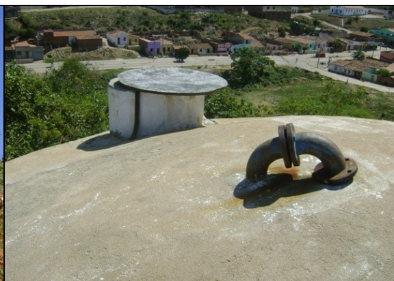
Foto 39 – Tampa de inspeção e ventilação do RAP-02.
