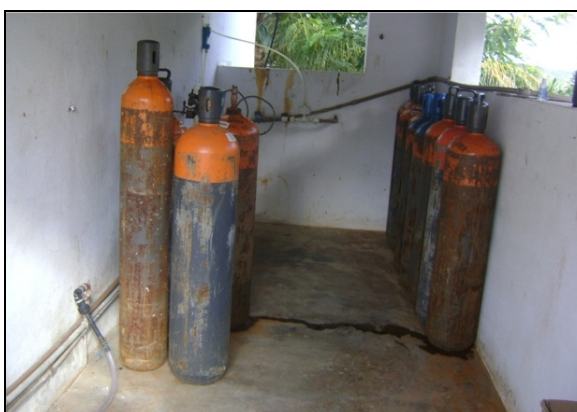
Foto 9 – Cilindros de cloro.
