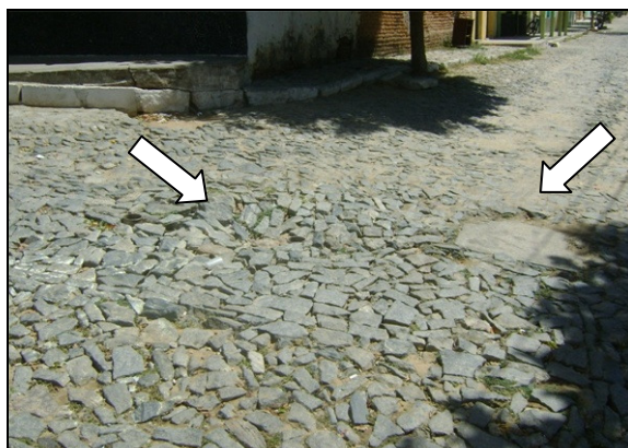
Foto 57 – Registros de descarga localizado na Rua São Francisco (sem caixa de proteção), com Geminiano Vitoriano de Oliveira, Pavãozinho.
