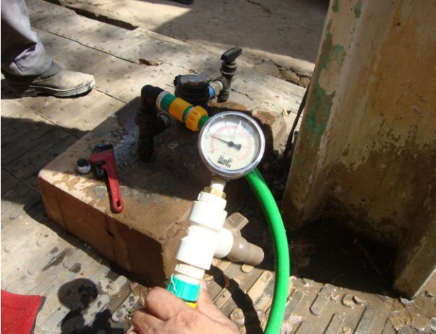
Foto 47 – Medição de pressão instantânea na Rua Monsenhor Sotter, nº 61.
