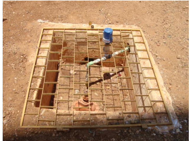
Foto 19 – Clorador de pastilha na saída do REL-01.
