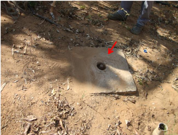
Foto 59 – Registro de descarga na Rua Areia dos Vidal.
