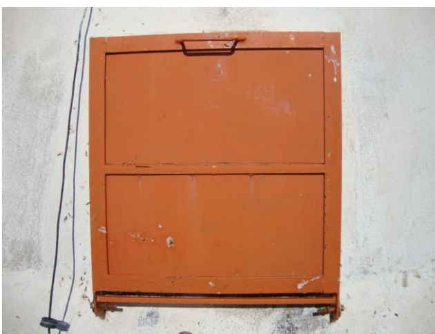
Foto 39 – REL-01: tampa de inspeção em adequada condição de vedação.
