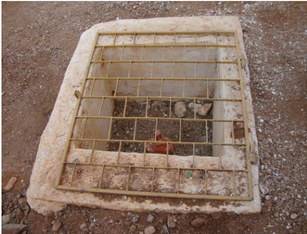
Foto 36 – Caixa de registro do REL-01.
