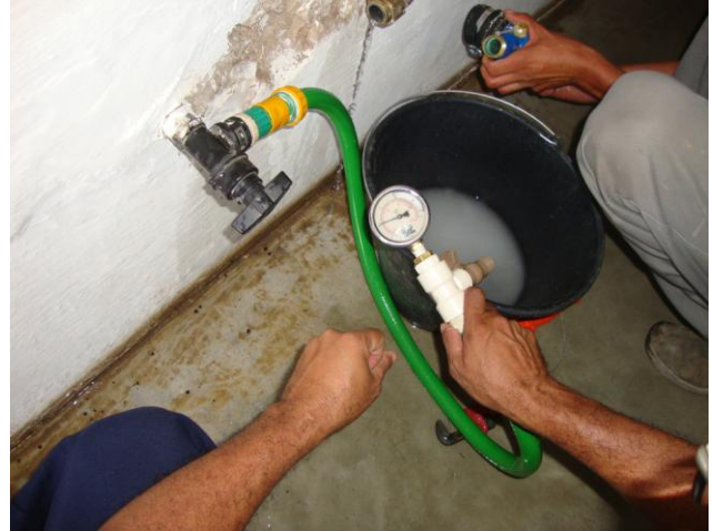
Foto 48 – Medição de pressão instantânea na Rua Sabino Pereira, nº 7.
