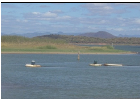
Foto 24 – Elevatórias EECS-01 e EECS-02.
