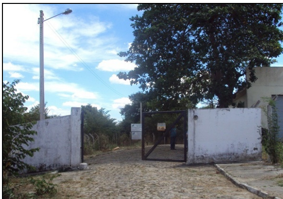
Foto 4 – Entrada da ETA.
