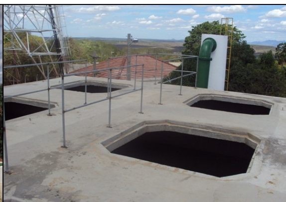
Foto 10 – Laje de cobertura dos filtros de concreto.
