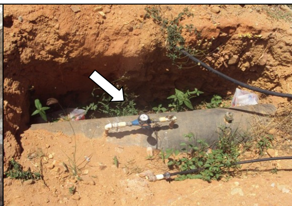
Foto 53 – Medidor proporcional na adutora de água tratada, sem caixa.
