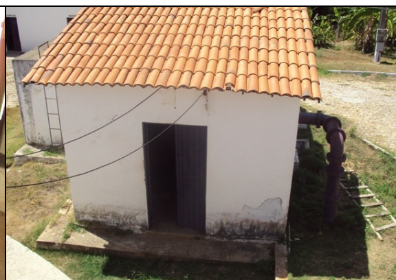
Foto 35 – Casa de comando da EEAT-01.
