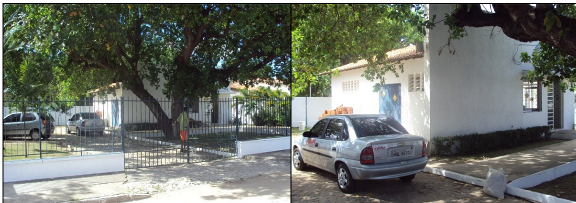
Fotos 57 e 58 – Vistas externas do escritório da CAGECE.
