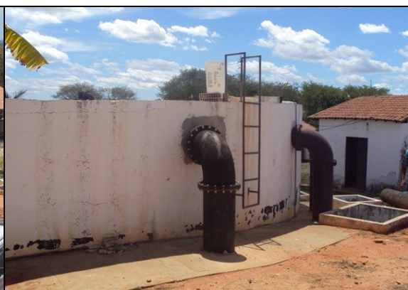
Foto 44 – Escada de acesso do RAP-03.
