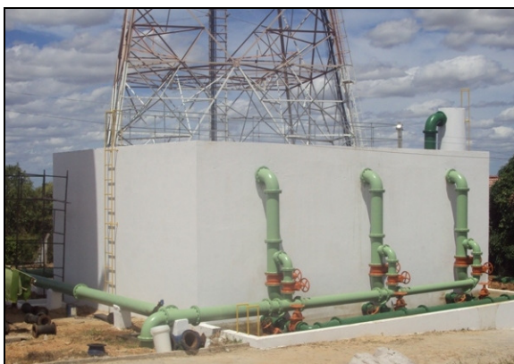
Foto 9 – Filtros de concreto, em testes.
