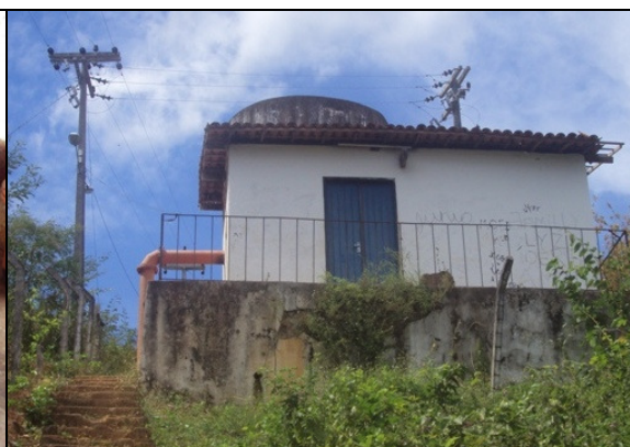
Foto 32 – Casa de comando da EEAB-02.
