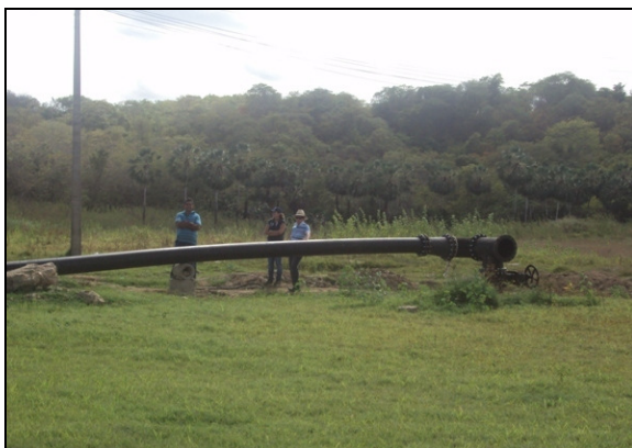
Foto 49 – Adutora de água bruta em execução.
