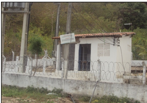
Foto 1 – Sinalização da captação.
