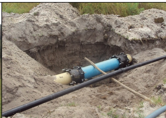
Foto 50 – Macromedidor em instalação na adutora de água bruta.
