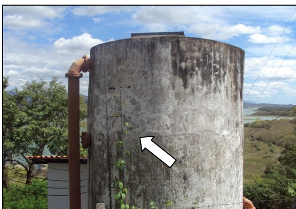
Foto 41 – Escada de acesso do RAP-02.
