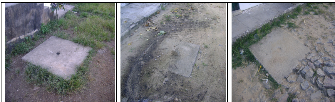
Fotos 35, 36 e 37 – Registros de descarga nas Ruas SDO-41, SDO-26 e Ananias Alencar Sales
