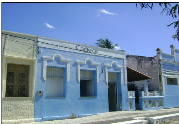
Foto 51 – Vista externa do escritório/loja de atendimento ao usuário.
