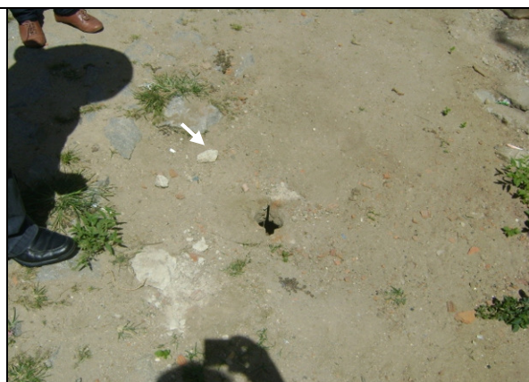
Foto 36 – Registro de descarga localizada na Rua Xavier Pires - Início.
