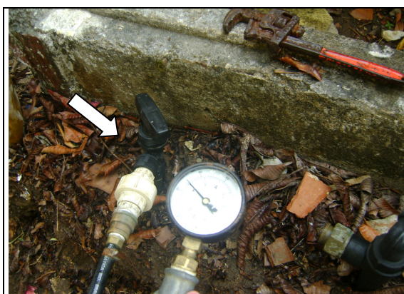
Foto 44 – Medição de pressão na Rua Raimundo Bandeira, Escola CA.
