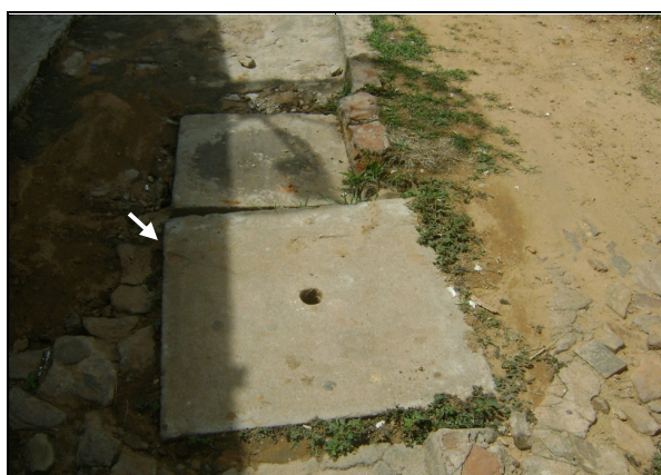
Foto 37 – Registro de descarga localizada na Rua Padre José Sobreira.
