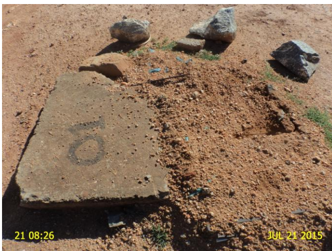
Foto 1 - AAB - Ventosa com caixa danificada.
