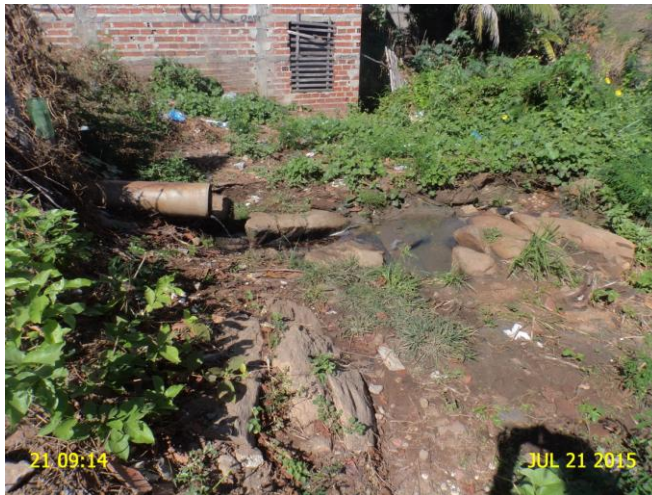
Foto 13 – ETA/Filtração: Local de descarga das águas de lavagem dos filtros.
