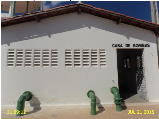
Foto 5 - EEAT-01 e EELF-01: ausência de identificação.
