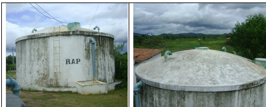
Fotos 28 e 29 – Vistas do RAP-01
