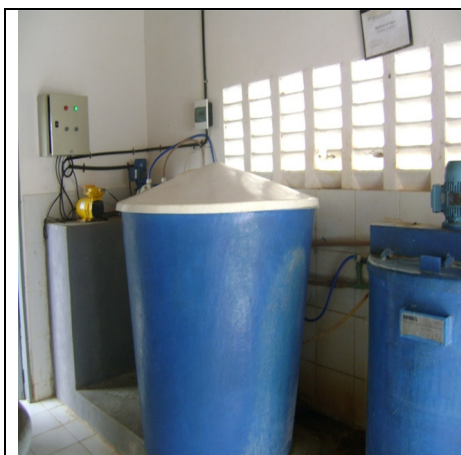
Fotos 15 e 16 – Tanques de dosagem e as bombas dosadoras
