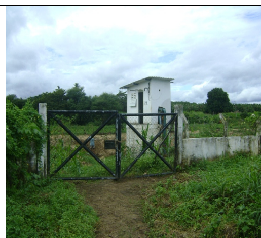
Foto 2 – Área da captação
