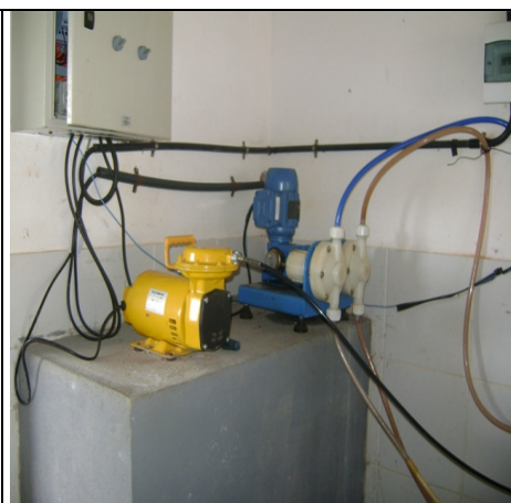
Fotos 15 e 16 – Tanques de dosagem e as bombas dosadoras
