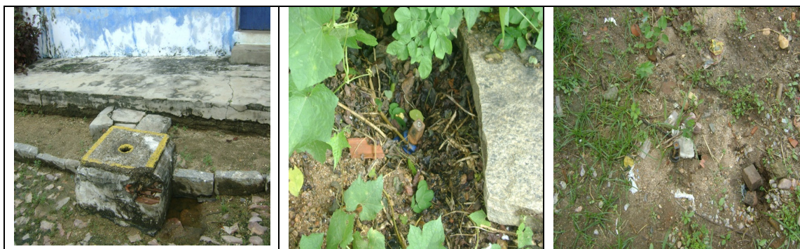
Fotos 36, 37 e 38 – Dois registros de descarga na Rua Jaca Paraiba e um registro na Rua Frederico Pontes
