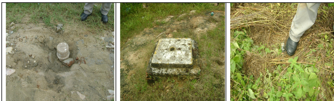
Fotos 39, 40 e 41 – Registros de descarga nas Ruas 25 de Janeiro, Antonio Teixeira Barros e SDO-23
