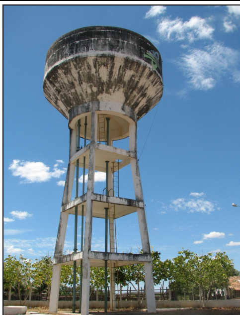
Foto 31 – REL-01: vista geral.
