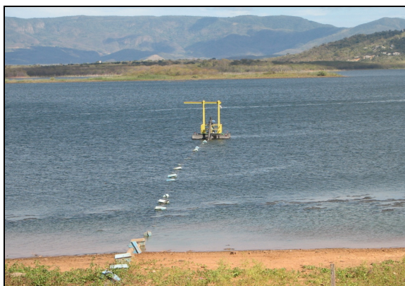
Foto 1 – Captação: flutuante no açude Angicos.
