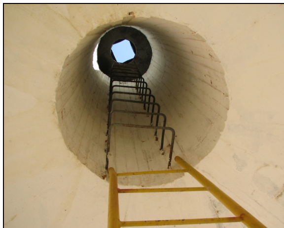
Foto 32 – REL-01: acesso interno à laje superior.
