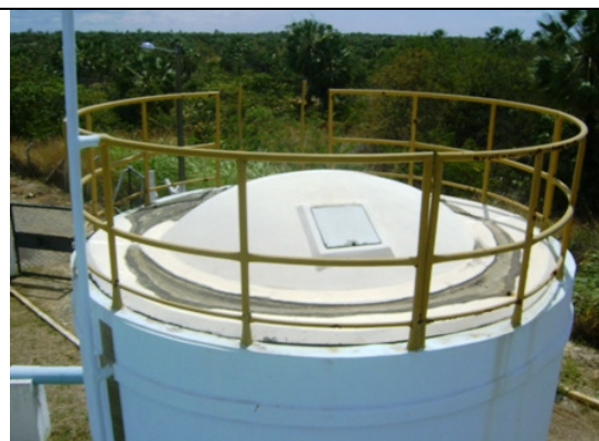
Foto 8 – Vista superior do filtro F-2
