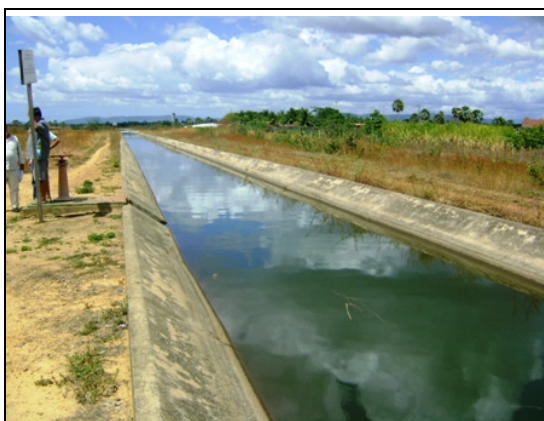
Foto 1 – Captação - canal de derivação – Açude Sítios Novos.
