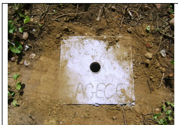
Foto 54 – Registro de descarga na Rua Major João Martins
