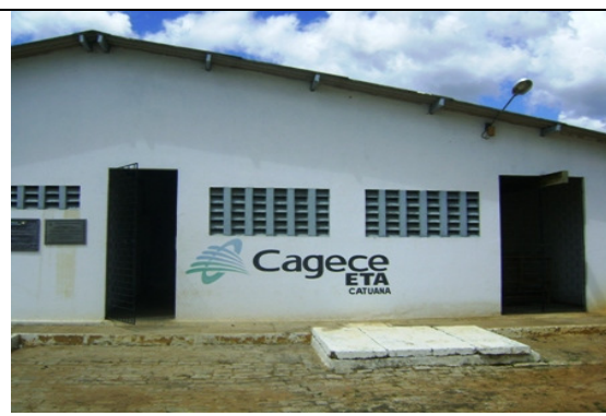
Foto 5 – Vista área interna da ETA de São Gonçalo do Amarante
