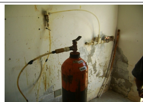
Fotos 11 e 12 – Sistema de dosagem de cloro gasoso
