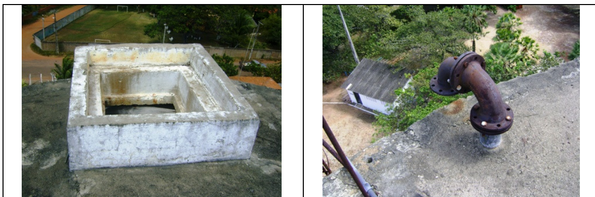
Fotos 41 e 42 – Vistas superiores do REL-02
