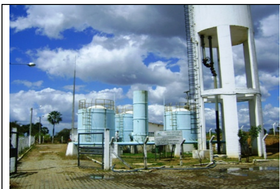
Foto 4 – Vista da entrada da ETA de São Gonçalo do Amarante
