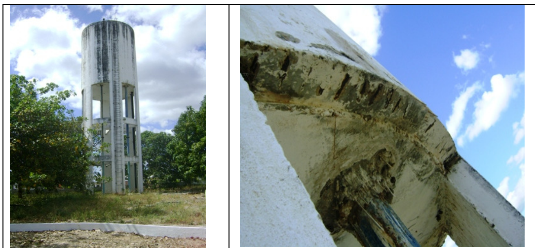
Fotos 39 e 40 – Vistas do REL-02
