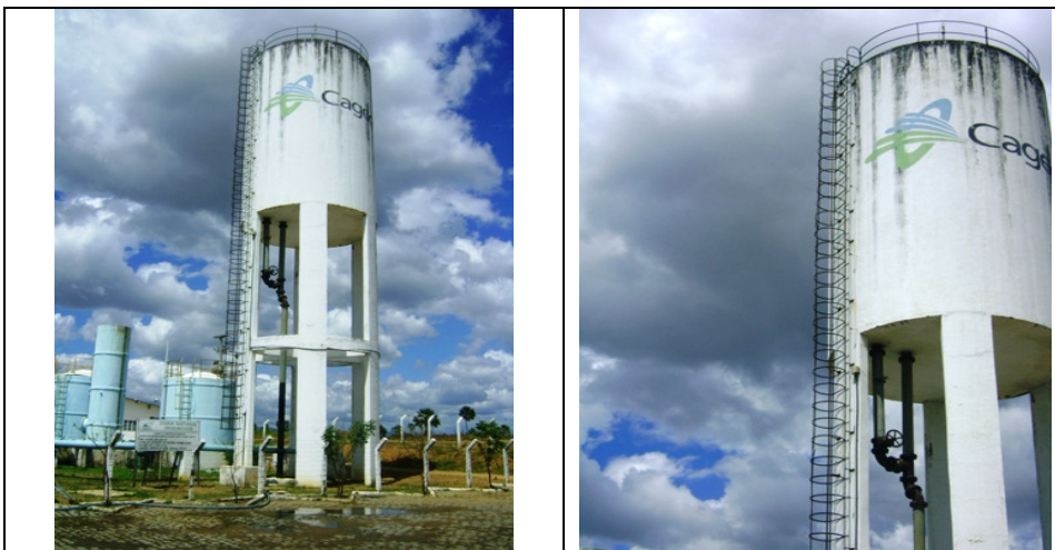
Fotos 37 e 38 – Vistas do REL-01
