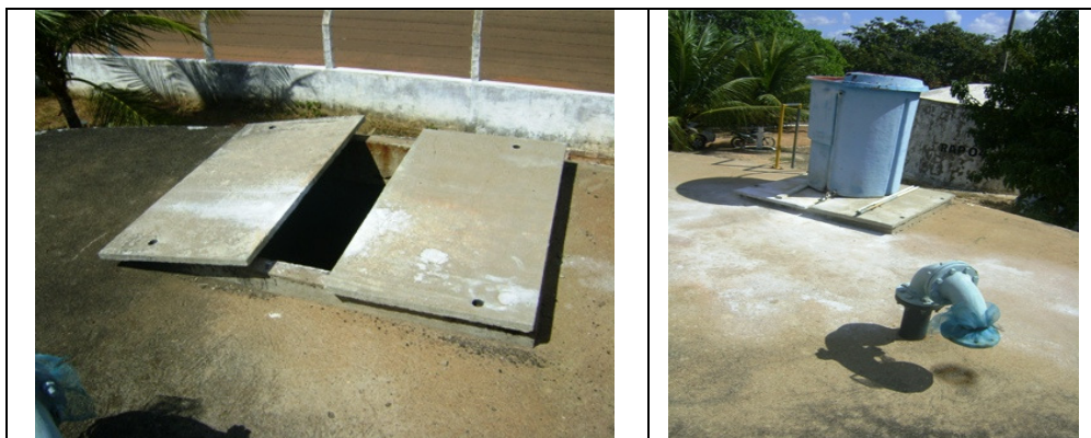
Fotos 35 e 36 – Vistas superiores do RAP-01
