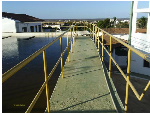
Foto 11 - ETA: passarela dos decantadores.
