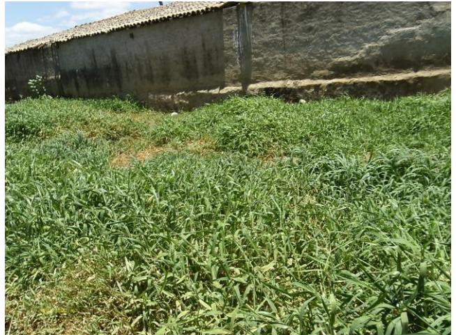
Foto 96 - ETE-09: saída do efluente tratado para o corpo receptor - Rio Poty.
