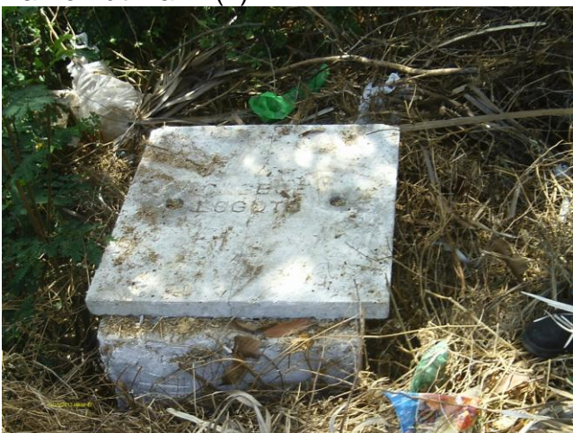
Foto 64 - Registro de descarga na rede de distribuição na Rua Francisco Sá - Centro. (3)
