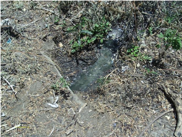
Foto 89 - ETE-02: saída do efluente tratado para o corpo receptor - Rio Poty.
