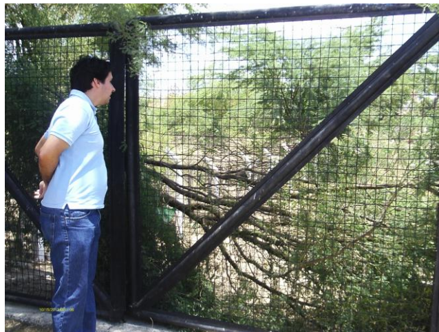
Foto 135 - ETE-09: vegetação excessiva na área interna.
