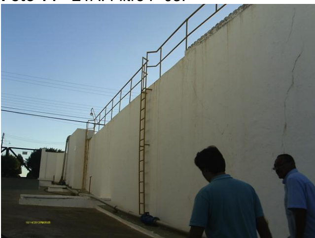
Foto 16 - ETA: escadas de acesso e guarda corpos, condições de limpeza do pátio externo, dos decantadores e filtros. .
