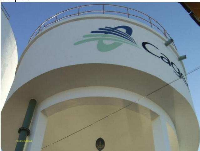
Foto 52 - REL-01: ausência de identificação presença de guarda-corpo.
