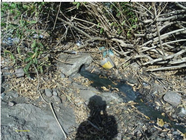
Foto 91 - ETE -04: saída do efluente tratado para o corpo receptor - Rio Poty.
