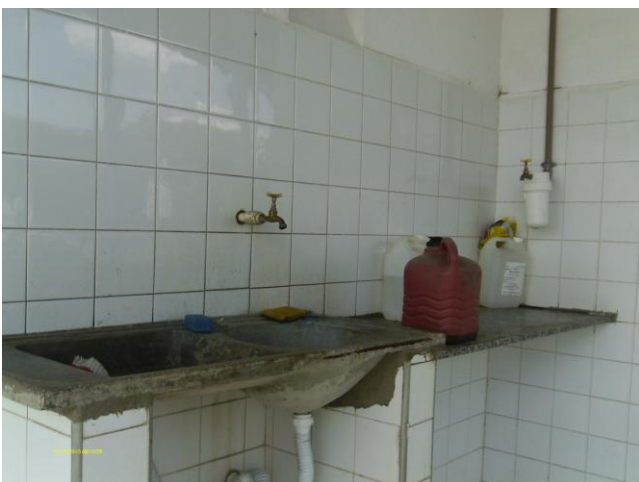
Foto 108 - ETE Maratoan: edificação de apoio para operadores.
