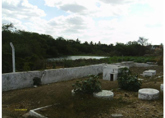
Foto 133 - ETE-08: cerca danificada e desinfecção desativada.
