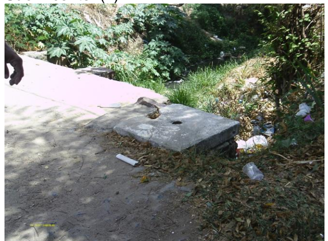
Foto 65 - Registro de descarga na rede de distribuição na Rua Dr. João Tomé com Rua Poty - Centro. (4)
