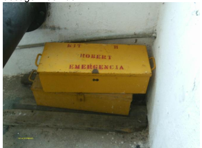
Foto 23 - Casa de química: kit de emergência para cloro gasoso.
