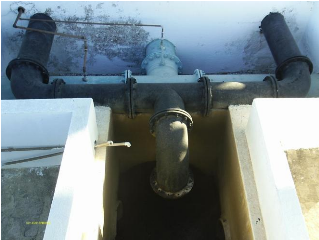
Foto 48 - RSE-01: tubulação de descarga de fundo e tubo extravasor.
