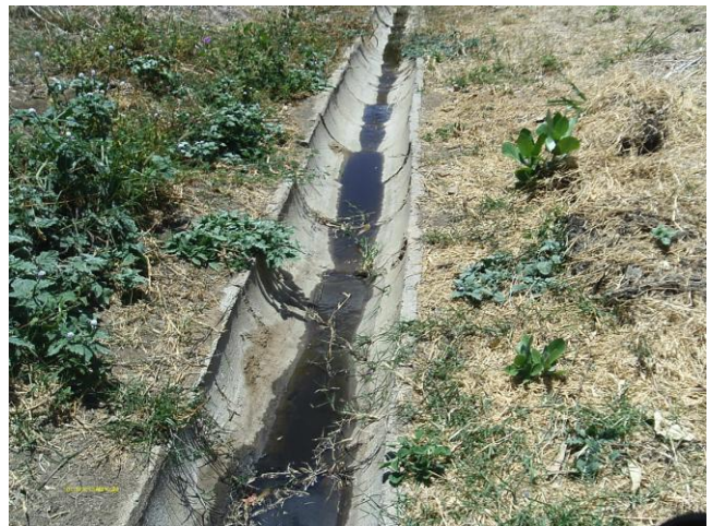
Foto 107 - ETE Maratoan - calha de drenagem.
