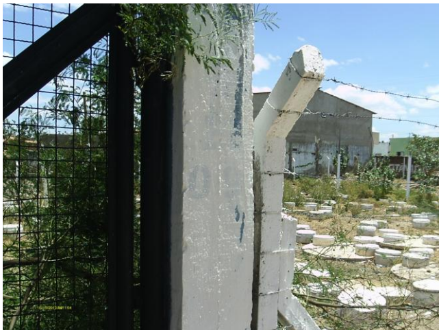
Foto 134 - ETE-09: identificação apagada.
