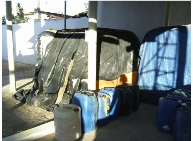
Foto 25 - Almojarifado para produtos químicos: armazenamento de sulfato de alumínio sólido.
