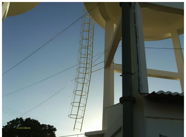
Foto 53 - REL-01: escada de acesso e tubulações.
