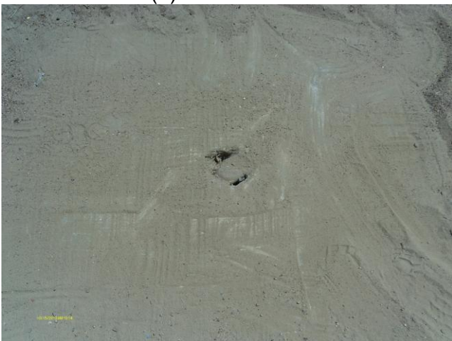
Foto 68 - Registro de descarga na rede de distribuição na Rua Washington Vale - Bairro Venancios. (7)
