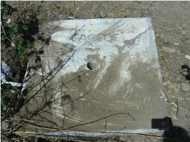
Foto 66 - Registro de descarga na rede de distribuição na Rua Almirante Tamandaré - Bairro Fátima. (5)
