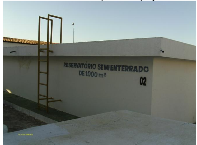
Foto 45 - RSE-02: identificação e escada de acesso.
