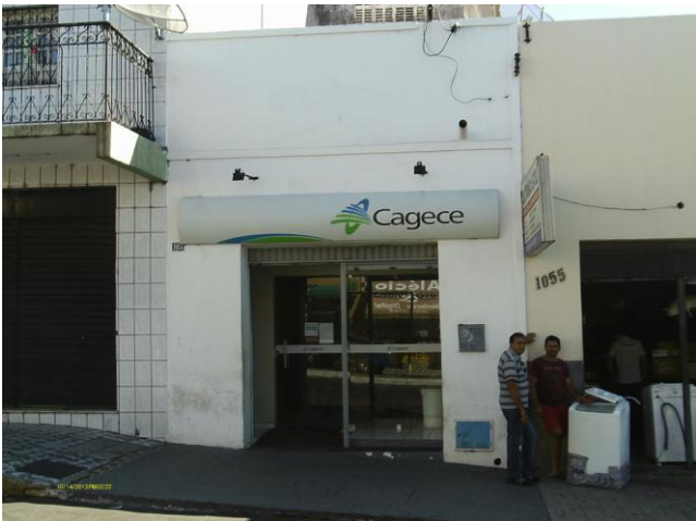
Foto 142 - Comercial: fachada do escritório/loja de atendimento.
