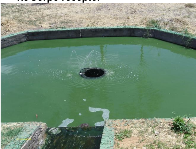
Foto 85 - ETE Maratoan - tubulação de saída do efluente tratado para o corpo receptor - Rio Poty.
