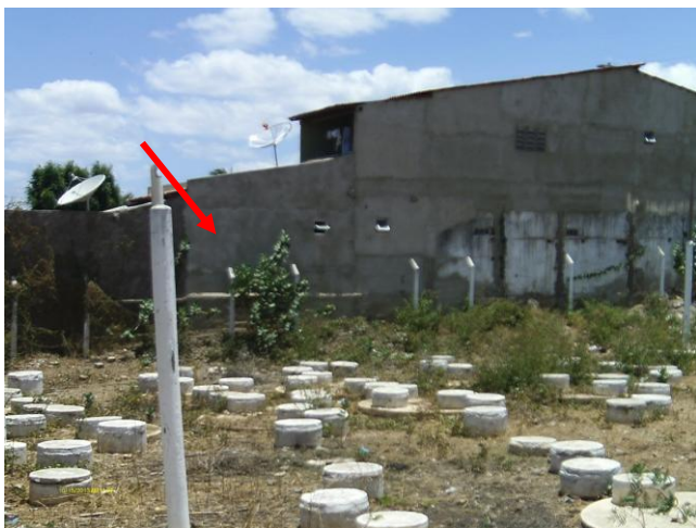
Foto 136 - ETE-09: cerca retirada por moradores da vizinhança nas laterais da ETE.
