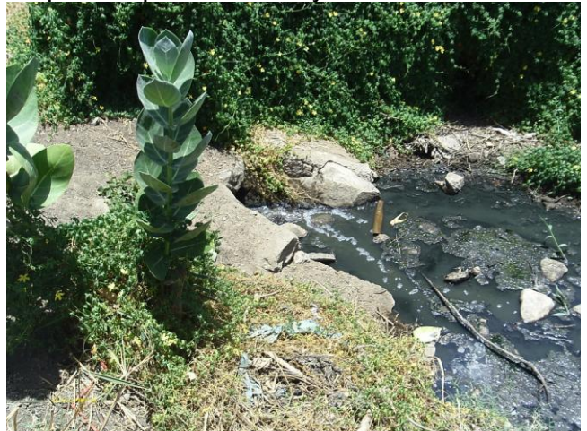
Foto 90 - ETE-03: saída do efluente tratado para o corpo receptor - Rio Poty.
