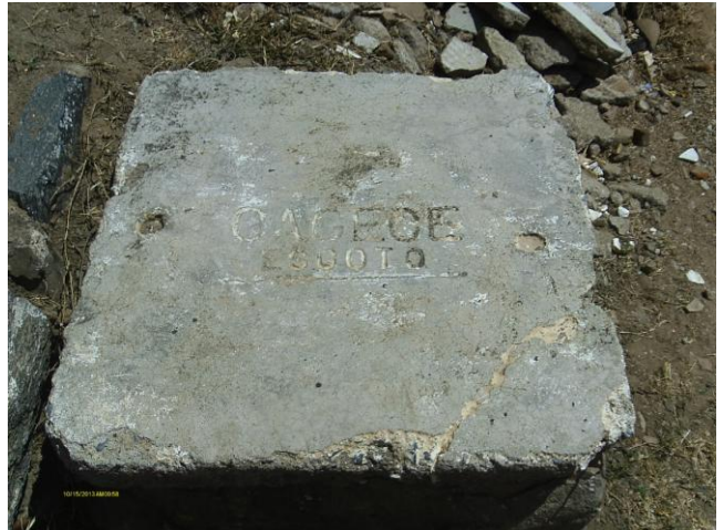
Foto 67 - Registro de descarga na rede de distribuição na Rua Fco Alves Ferreira - Bairro Cajas. (6)
