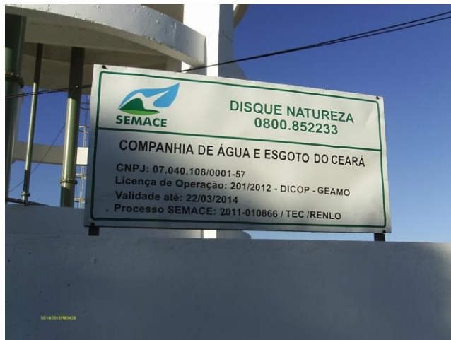
Foto 7 - ETA: placa com informações sobre o licenciamento ambiental.
