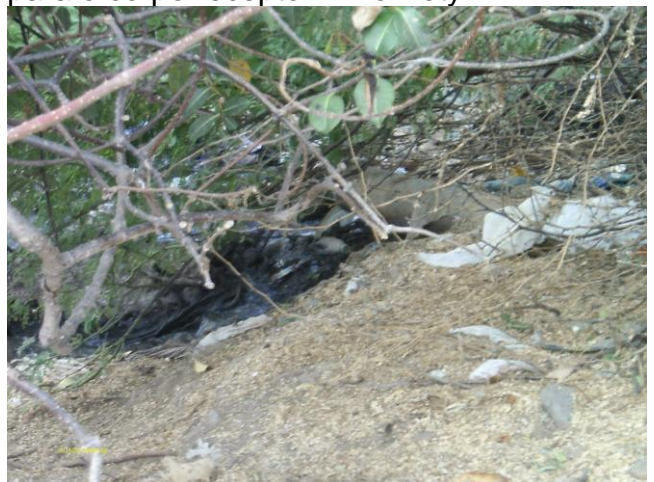
Foto 92 - ETE-05: saída do efluente tratado para o corpo receptor - Rio Poty.
