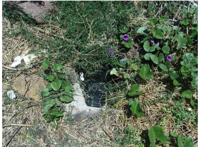
Foto 88 - ETE - 01: saída do efluente para o corpo receptor - Rio Poty.
