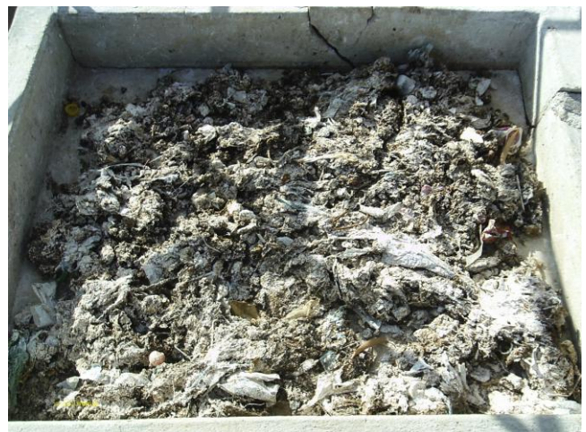
Foto 75 - EEE-H1: material retido no gradeamento.
