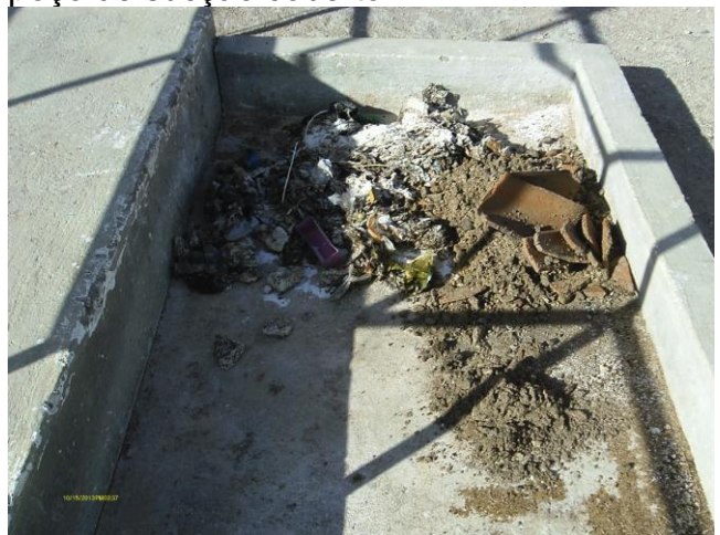
Foto 81 - EEE-G1 FINAL: material retido no gradeamento.
