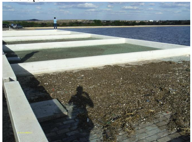
Foto 115 - ETE Revoltosos: leitos de secagem.
