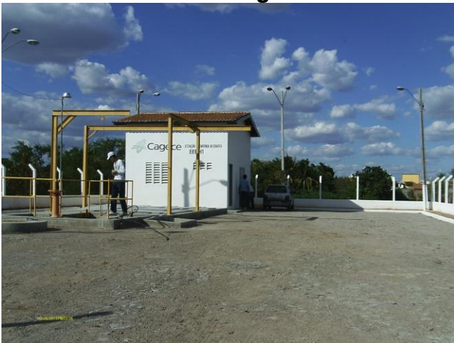
Foto 72 - EEE-H1: identificação e pátio externo.
