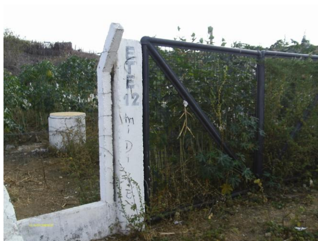
Foto 139 - ETE-12: identificação apagada.
