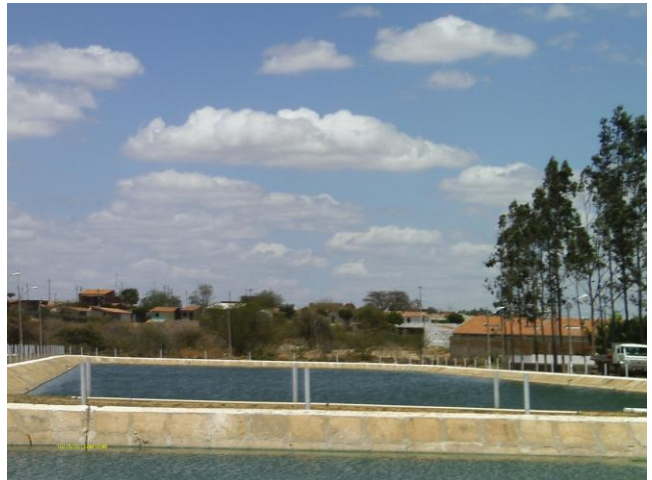
Foto 103 - ETE Maratoan: lagoa de maturação.
