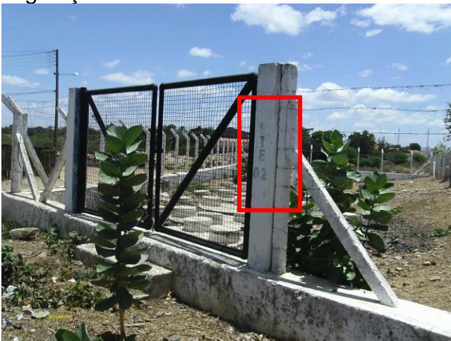
Foto 118 - ETE-02: identificação apagada.
