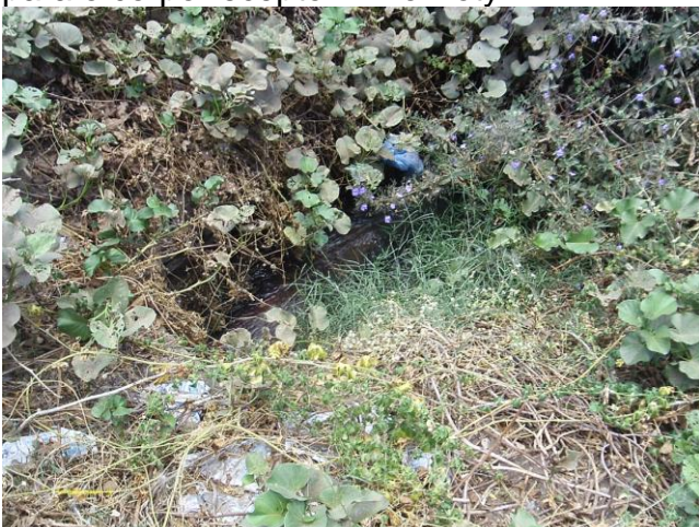
Foto 97 - ETE-10: saída do efluente tratado para o corpo receptor - Rio Poty.
