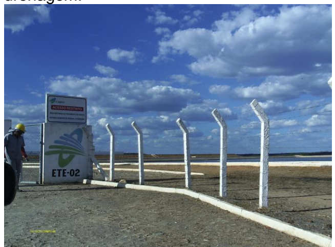
Foto 109 - ETE Revoltosos: identificação e cerca de delimitação da área.
