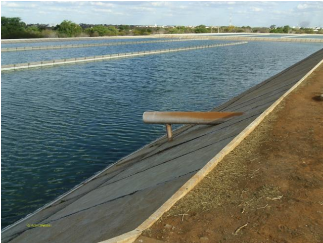
Foto 112 - ETE Revoltosos: tubulação para manobra (desativada).
