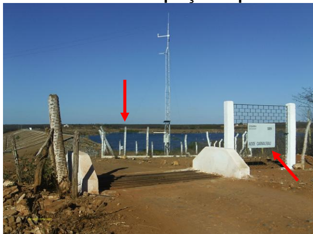
Foto 1 - Sinalização identificando o manancial e cerca de delimitação da área.
