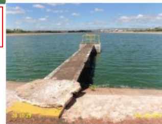
Foto 2 – ETE: passarelas sem guarda-corpos.
