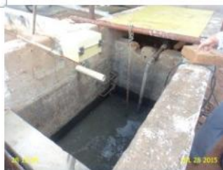
Foto 1 – EEE: ausência de bomba reserva.
