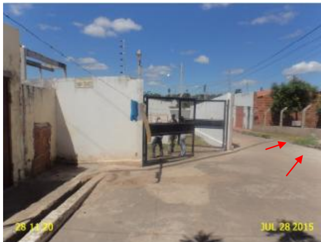
Foto 23 – Lançamento de esgoto à céu aberto.
