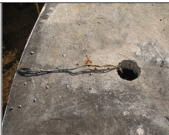
Foto 29 – RAP-01: abertura na laje – entrada de eletrodutos.
