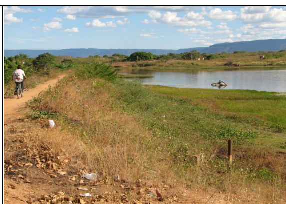
Foto 2 – Captação: área sem cerca de proteção – Açude Municipal.
