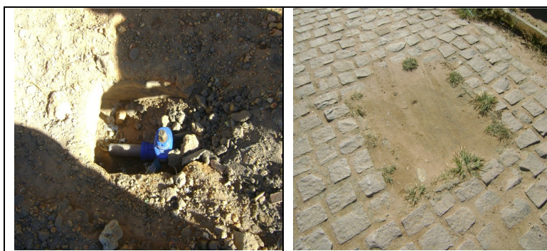
Fotos 14 e 15 – Registros de descarga nas Ruas São Francisco e Santo Antonio
