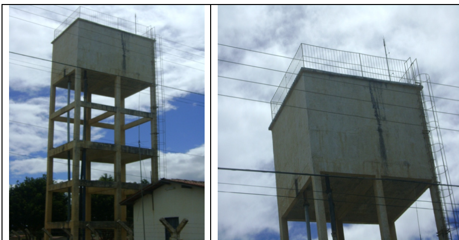
Fotos 9 e 10 – Vistas do REL-01
