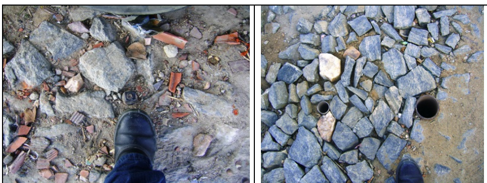
Fotos 58 e 59 – Registros de descarga na Rua Amanco Campelo
