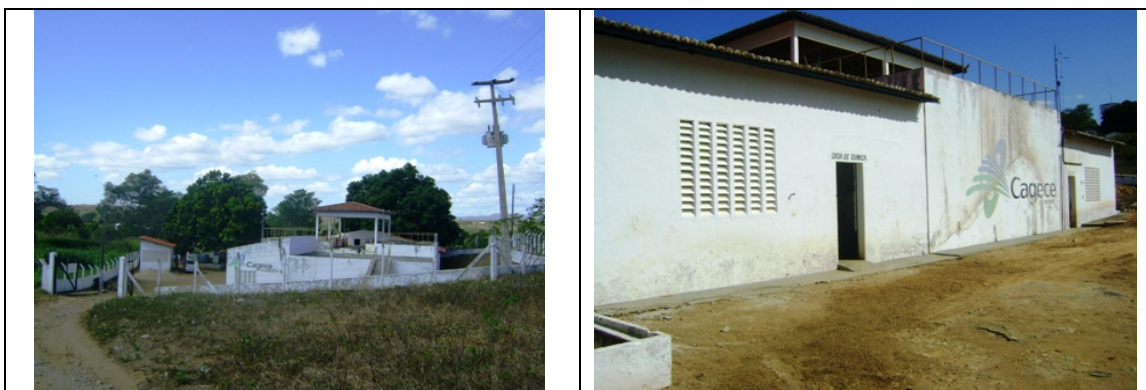
Fotos 3 e 4 – Vistas externa e interna da ETA
