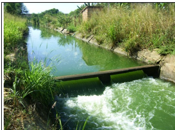
Foto 1 – Canal de Irrigação onde é feita a captação
