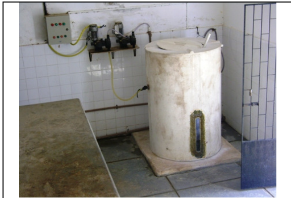
Foto 12 – Sistema de fluoretação inoperante.
