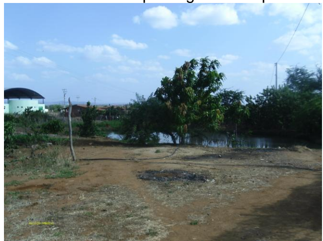
Foto 16 - ETA: terreno que recebe as águas de lavagem e de descarga de fundo dos filtros.
