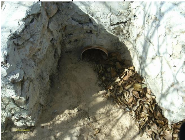
Foto 89 - Corpo receptor: local de saída do efluente tratado na ETE Cupim.
