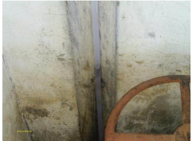
Foto 48 - RAP-02: medidor de nível.
