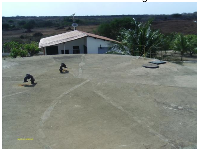
Foto 46 - RAP-02: cobertura, tampa de inspeção e tubulação de ventilação.
