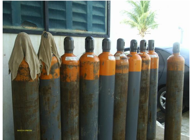
Foto 20 - Casa de química: armazenamento dos cilindros de cloro gasoso.
