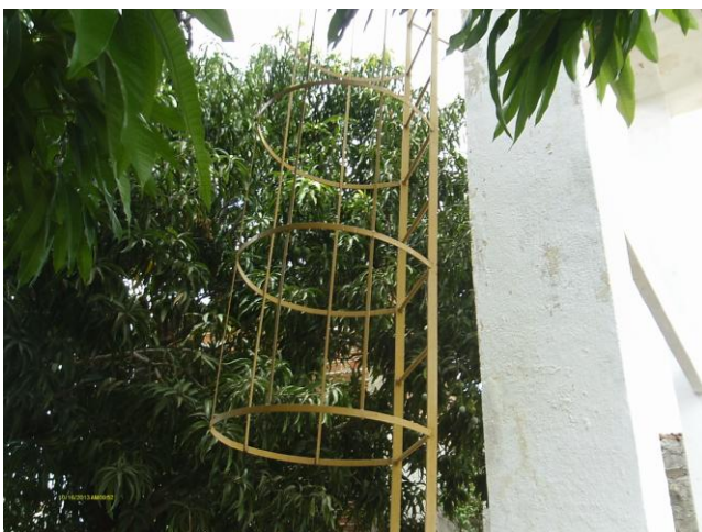
Foto 51 - REL-01: escada de acesso.
