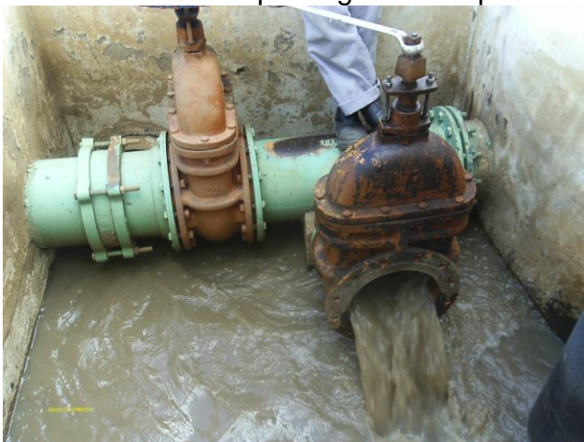
Foto 15 - F-03: descarga de fundo.
