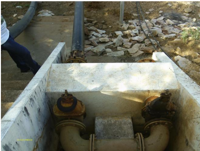
Foto 30 - AAB-01: registros próximo à captação.
