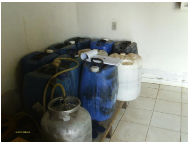
Foto 17 - Casa de química: armazenamento de produtos químicos.
