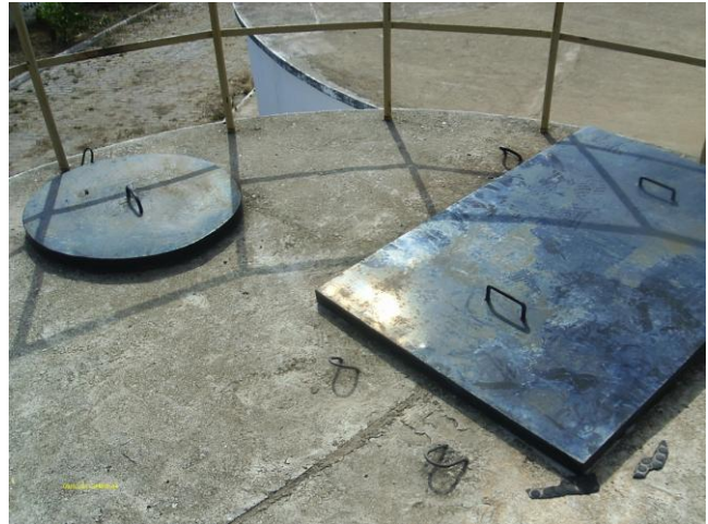
Foto 14 - F-04: tampas e guarda corpo.
