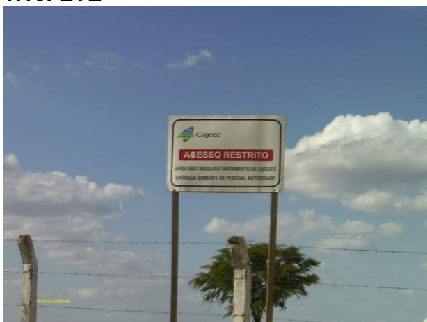
Foto 91 - ETE: placa de identificação.
