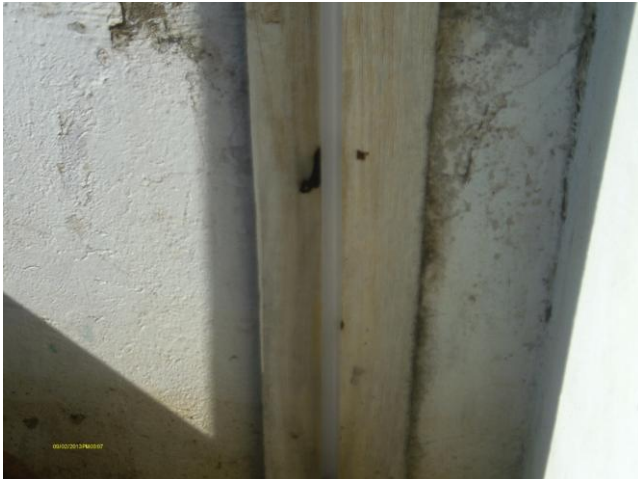
Foto 47 - RAP-01: medidor de nível.
