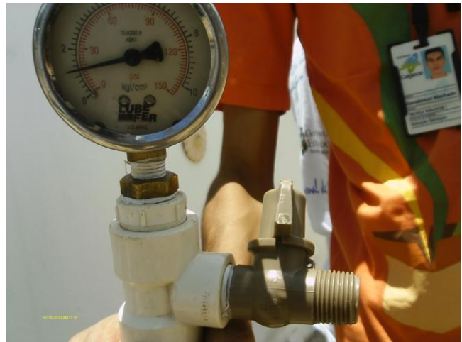
Foto 60 - Medião instantânea de pressão na rede de distribuição a Rua Liberdade, VISA 698.
