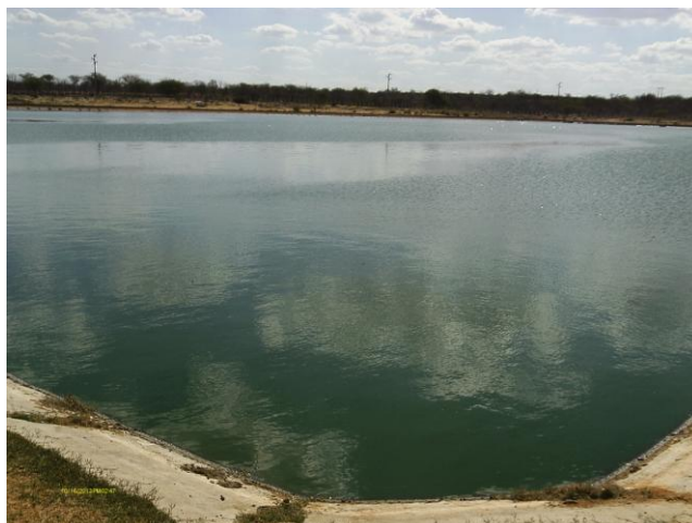
Foto 94 - ETE: lagoa facultativa.
