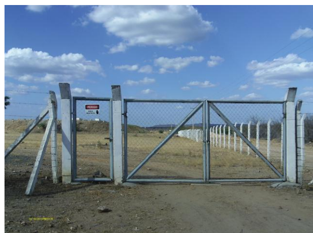
Foto 92 - ETE: cerca de delimitação.
