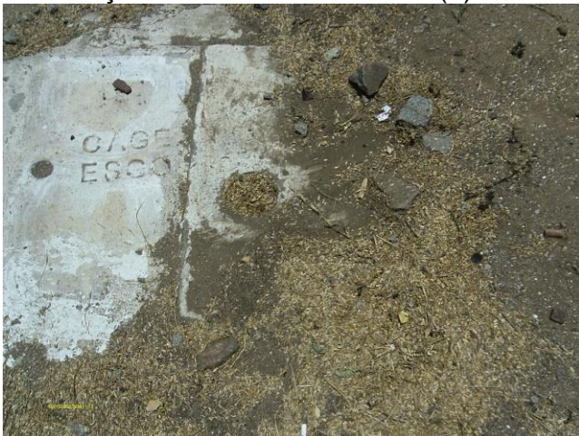
Foto 67 - Registro de descarga na rede de distribuição na Rua F co Silva Carvalho (6).
