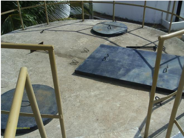
Foto 13 - F-03: tampas e guarda-corpo.
