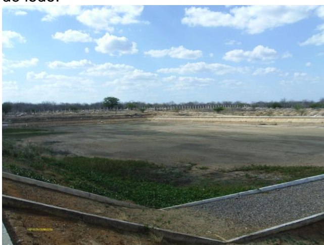
Foto 97 - ETE: lagoa de maturação (2).
