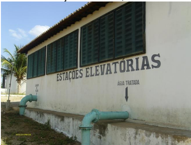
Foto 36 - Estações elevatórias EEAT-01 e EELF-01.
