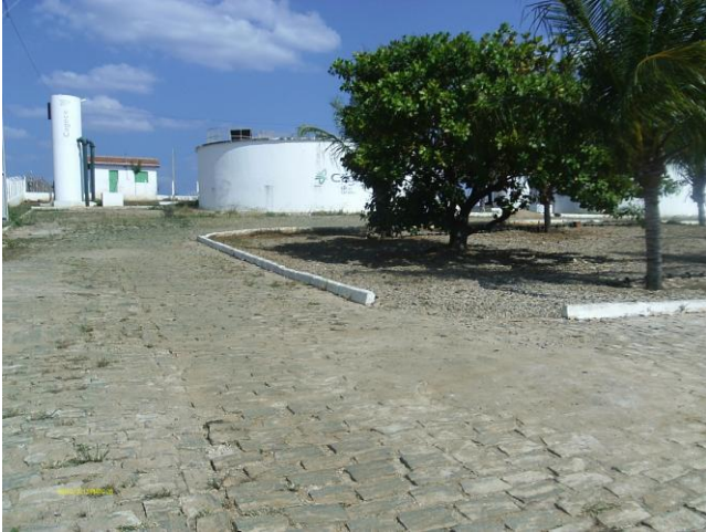
Foto 7 - ETA: Área externa.
