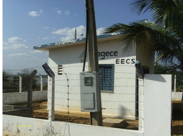
Foto 2 - Casa de abrigo do quadro de comando da EECS-01.
