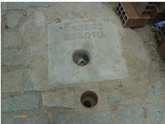
Foto 63 - Registro de descarga na rede de distribuição na Rua Cícero Justino (2).
