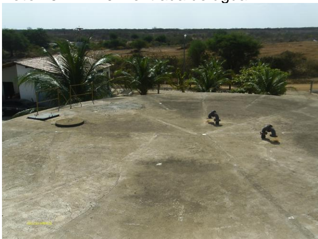
Foto 45 - RAP-01: cobertura, tampa de inspeção e tubulação de ventilação.
