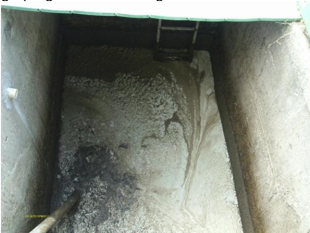
Foto 83 - EEE-02: gradeamento submerso.
