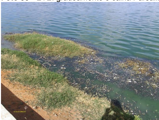
Foto 95 - ETE: lagoa facultativa, formação de lodo.
