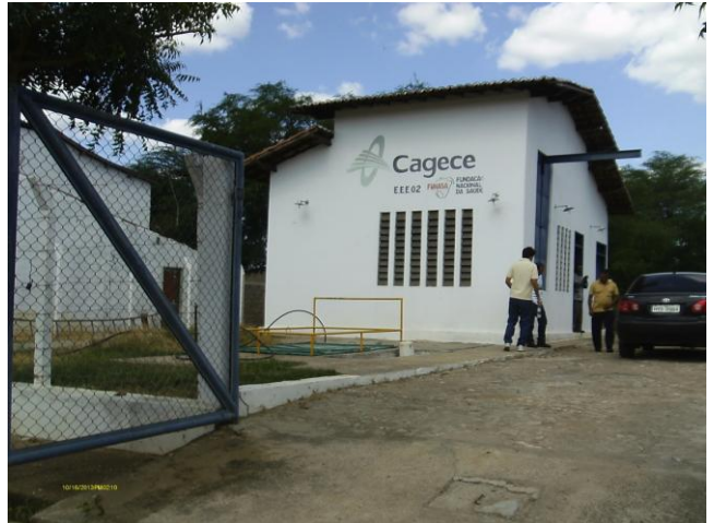
Foto 82 - EEE-02: identificação e área externa.
