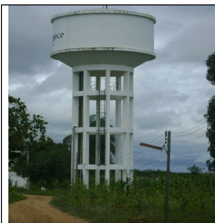
Foto 35 – Vista do REL-01
