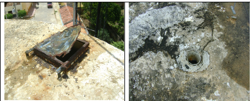
Fotos 44 e 45 – Detalhes da laje do REL-02
