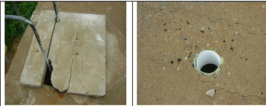
Fotos 39 e 40 – Detalhes da laje superior do RAP-01
