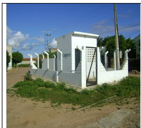
Foto 34 – Vista do booster - 02
