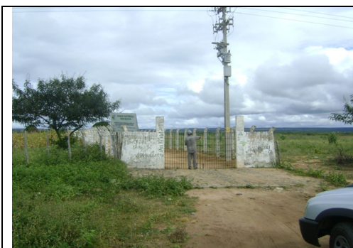
Foto 7 – Vista da entrada da ETA do SAA de Campos Sales
