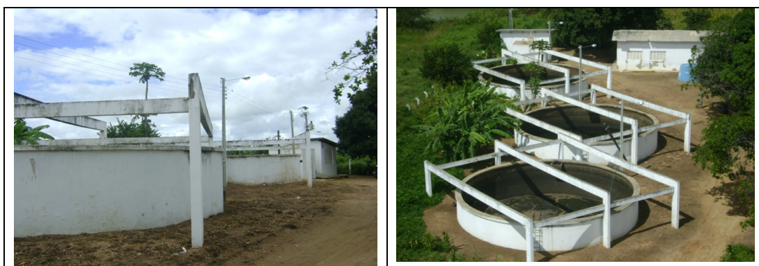
Fotos 14 e 15 – Vistas frontal e superior dos filtros lentos
