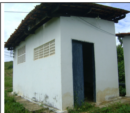
Foto 32 – Casa de proteção da EECS-01
