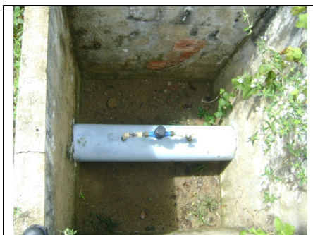
Foto 49 – Macromedidor na entrada do REL-01
