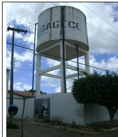
Foto 43 – Vista do REL-02
