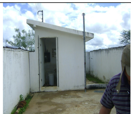
Foto 33 – Casa de proteção da EEAT-02
