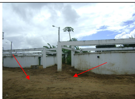
Fotos 10 e 11 – Deposição de material filtrante ao lado dos filtros lentos
