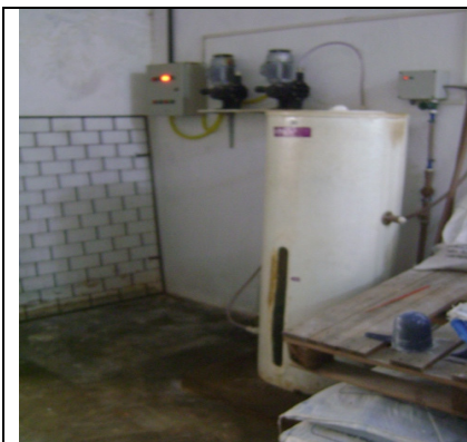
Foto 18 – Sistema de fluoretação Foto 19 – Cilindros de cloro
