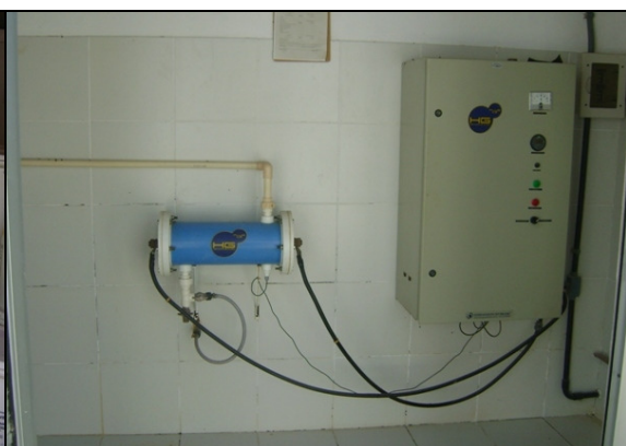
Foto 9 – Dosadores de PAC e flúor e produtos químicos armazenados inadequadamente.
