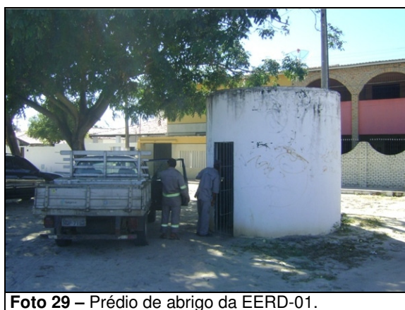
Foto 29 – Prédio de abrigo da EERD-01.
