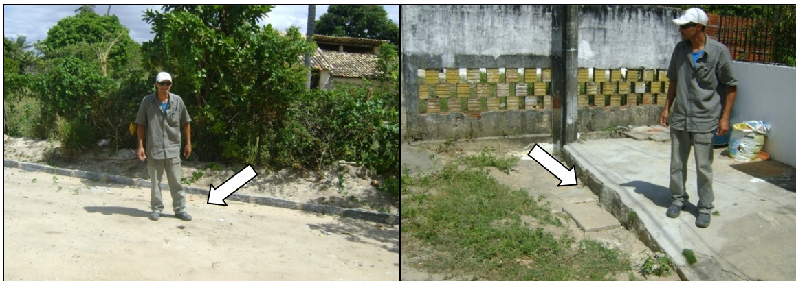
Foto 47 – Registro de descarga localizado na Rua Francisca Olinda Pereira, Centro.
