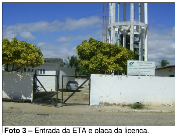
Foto 3 – Entrada da ETA e placa da licença.
