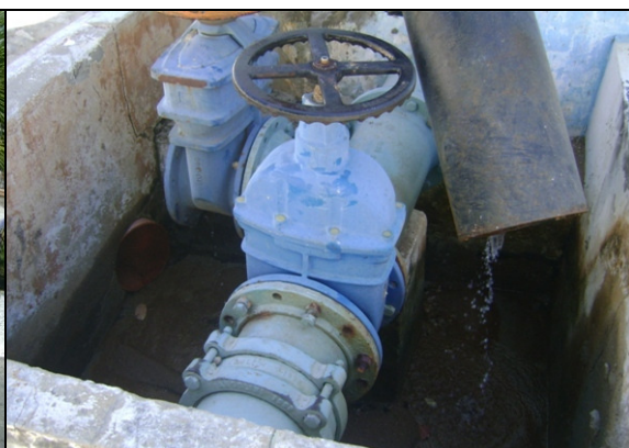
Foto 5 – Registro de descarga do filtro 01 com problema de vazamento.
