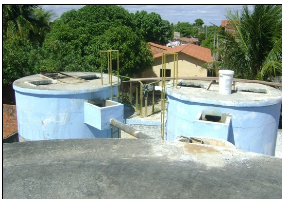
Foto 4 – Vista dos filtros.
