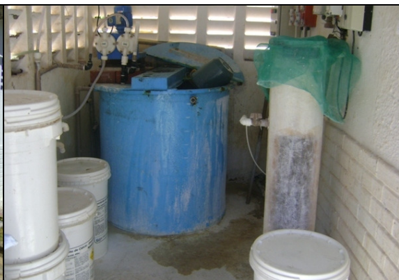
Foto 9 – Dosadores de PAC e flúor e produtos químicos armazenados inadequadamente.
