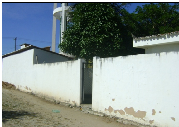
Foto 56 – Vista externa do escritório da CAGECE.
