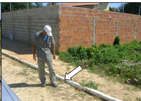
Foto 46 – Registro de descarga soterrado, localizado na Rua Joaquim Facó, Centro.
