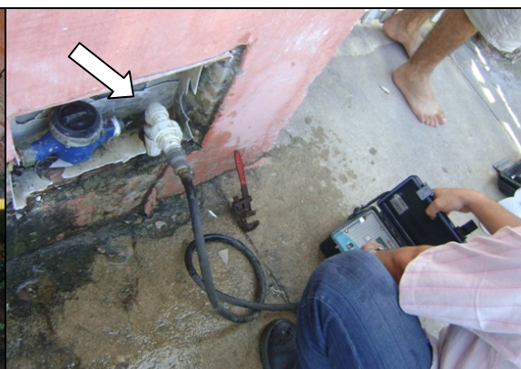
Foto 52 – Medição de pressão sem hidrômetro, na Rua B, 97 – COHAB.
