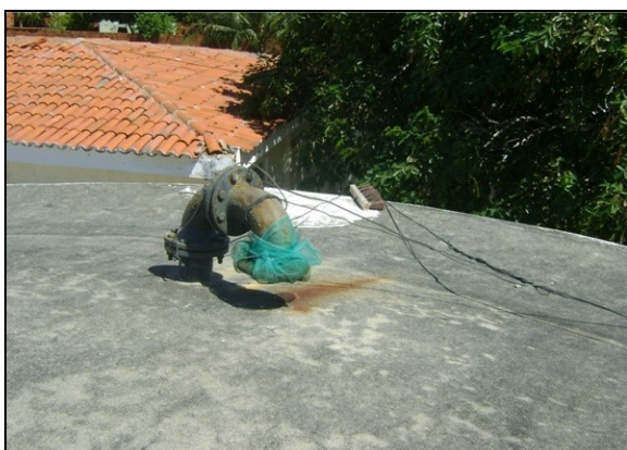
Fotos 33 e 34 – Tubulações de ventilação do RAP-01, com tela.
