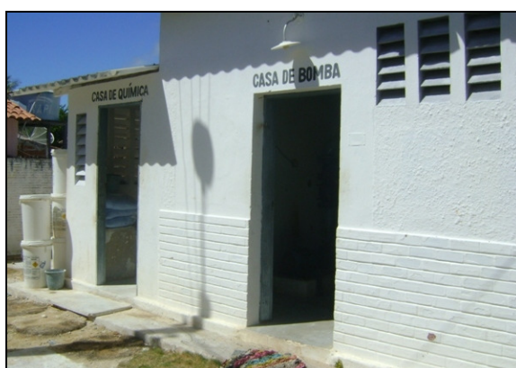
Foto 26 – Prédio de abrigo das das EEAT-01 e EEAT-02.
