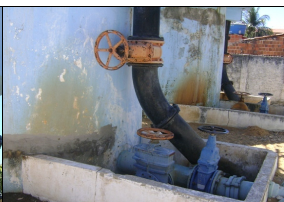
Foto 5 – Registro de descarga do filtro 01 com problema de vazamento.
