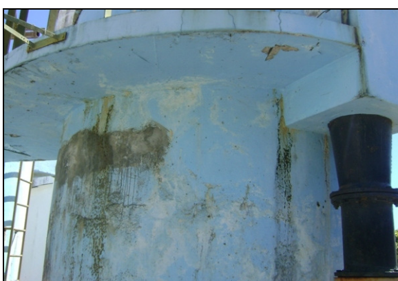
Fotos 6 e 7 – Vazamentos nas paredes dos Filtros 01 e 02.
