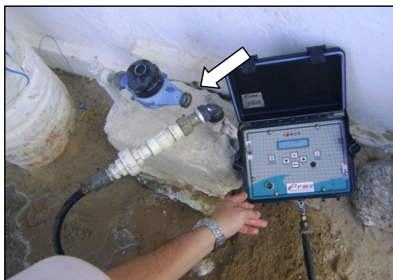
Foto 55 – Medição de pressão sem hidrômetro, na Rua 1, N° 9 - Choró.
