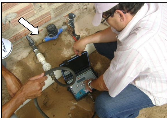
Foto 49 – Medição de pressão sem hidrômetro, na Rua Chico Xavier, 7 - Novo Planalto.
