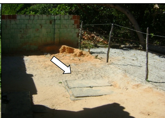
Foto 44 – Registro de descarga localizado na Rua SDO-01, Novo Planalto.
