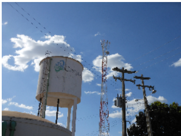
Foto 54 - REL-02: vista parcial.
