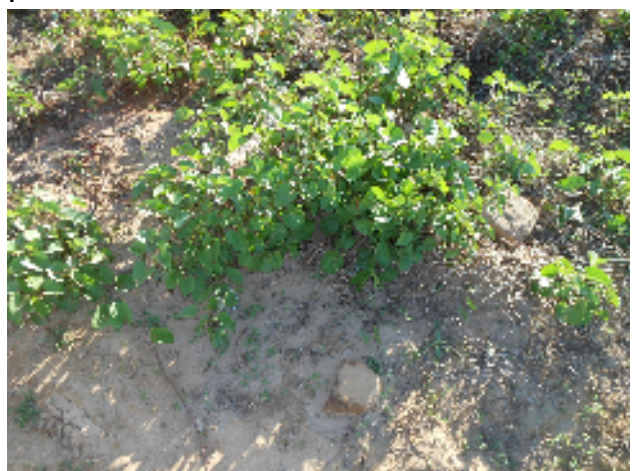
Foto 71 - Registro de descarga na rede de distribuição: Estrada para Ipaguassu (soterrado).
