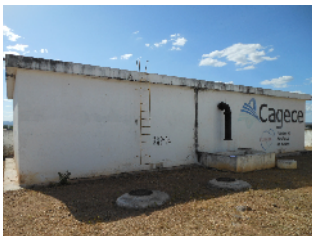
Foto 59 - RAP-04: vista geral.
