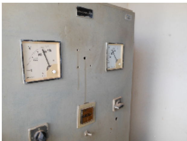
Foto 4 - Manancial/Captação superficial: QC da EECS-01.
