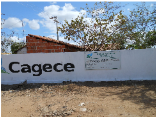
Foto 5 - ETA: delimitação e placa da SEMACE
