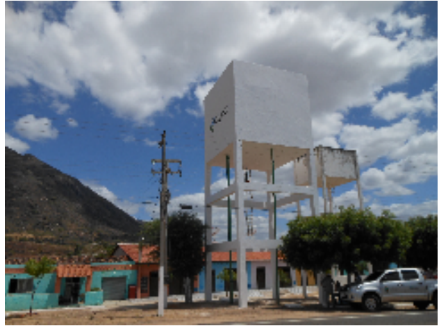
Foto 61 - REL-03: vista geral.
