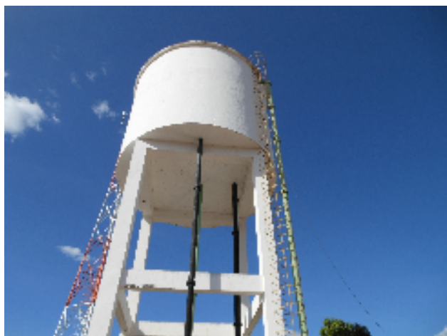
Foto 56 - REL-02: vista geral.
