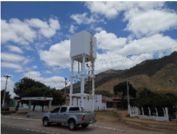
Foto 62 - REL-04: vista geral.
