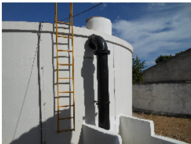
Foto 51 - RAP-02: escada de acesso.
