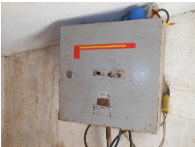
Foto 39 - REL-03: QC, ausência de horímetro e medidor de nível.
