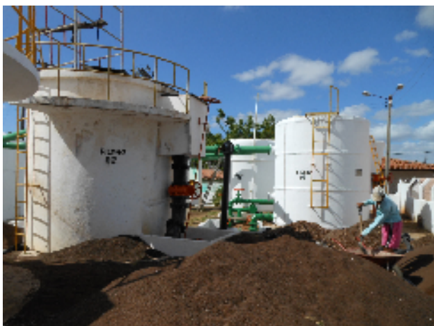
Foto 7 - ETA/Filtração: filtros F-02, F-03 e F-04.
