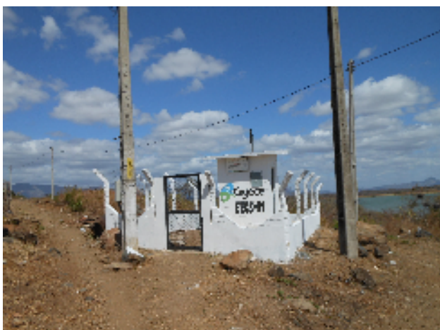
Foto 3 - Manancial/Captação superficial: casa de abrigo do QC da EECS-01.
