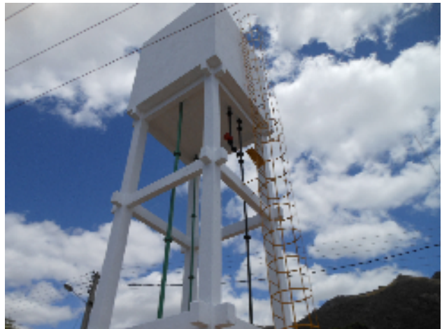
Foto 63 - REL-04: escada de acesso.
