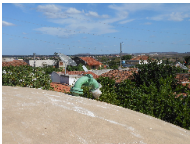
Foto 53 - RAP-02: tela de proteção.
