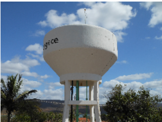
Foto 46 - REL-01: vista geral.
