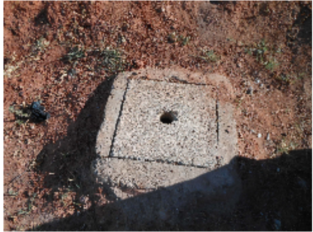
Foto 67 - Registro de descarga na rede de distribuição: Rua Maj. Joventos.
