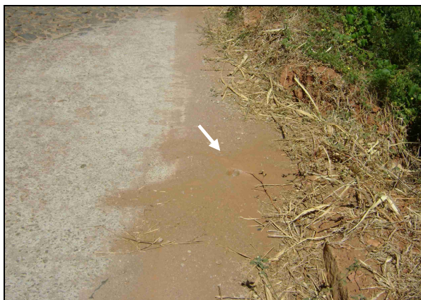
Foto 26 – Registro de descarga localizado na Estrada para Caririaçu.
