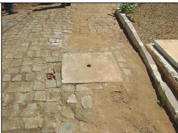
Foto 25 – Registro de descarga da adutora de água tratada.
