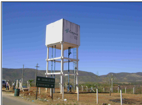
Foto 19 – Vista do REL-01.
