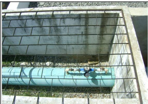
**Foto 21** – Medidor proporcional localizado na linha de lavagem dos filtros.
