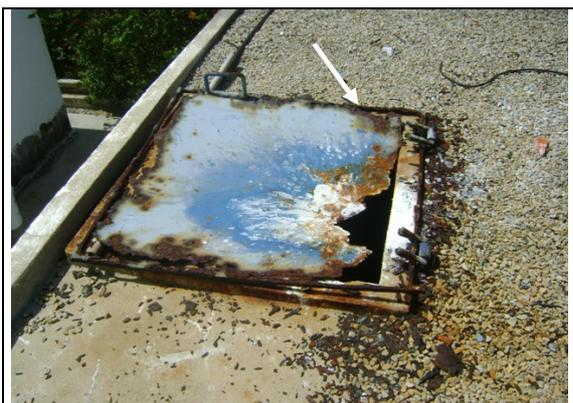
**Foto 34** – RAP-02: Tampa de inspeção comprometida pela corrosão.
