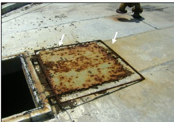
**Foto 37** – REL-03: Tampa de inspeção comprometida pela corrosão.
