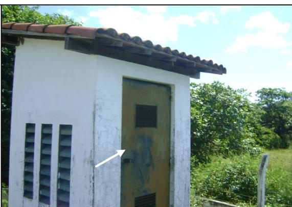
**Foto 25** – EECS-01: Porta necessitando de pintura anticorrosiva.
