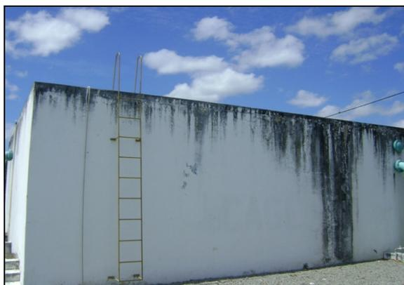
**Foto 32** – RAP-02: Sem identificação e necessitando pintura.
