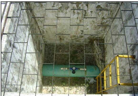
**Foto 20** – Medidor proporcional localizado na entrada do REL-03.
