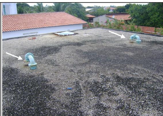
**Foto 33** – RAP-02: Tubulação de ventilação sem tela de proteção.
