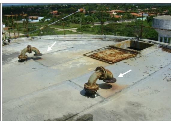
**Foto 36** – REL-03: Tubulação de ventilação sem tela de proteção.
