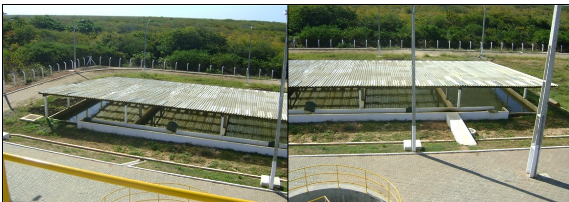
Fotos 9 e 10 – Vistas dos leitos de secagem.
