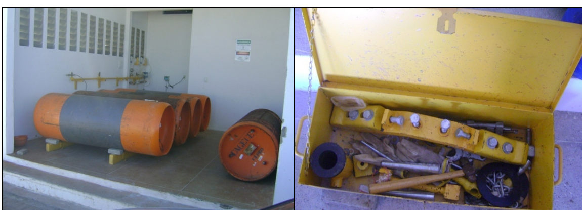
Fotos 15 – Cilindros de cloro gasoso.
