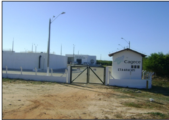
Foto 3 – Entrada da ETA.
