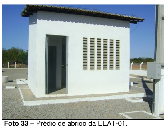
Foto 33 – Prédio de abrigo da EEAT-01.
