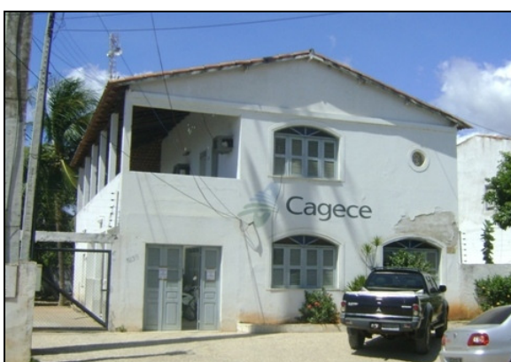
Foto 73 – Vista externa do núcleo operacional da CAGECE.
