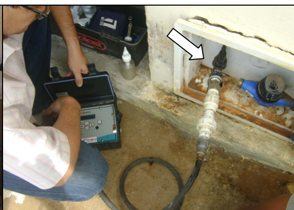
Foto 69 – Medição de pressão sem hidrômetro, na Rua 2 de Novembro, 762 - Tabajara.
