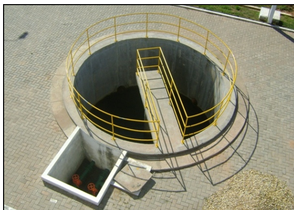
Foto 8 – Vista do tanque de equalização.
