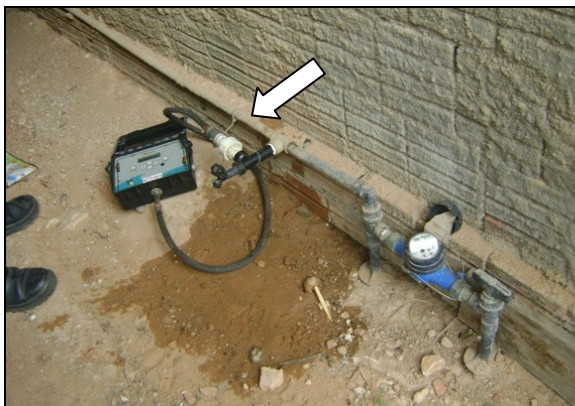
Foto 62 – Medição de pressão sem hidrômetro, na Travessa Vila Buiú, 1.684 (Datalogger).
