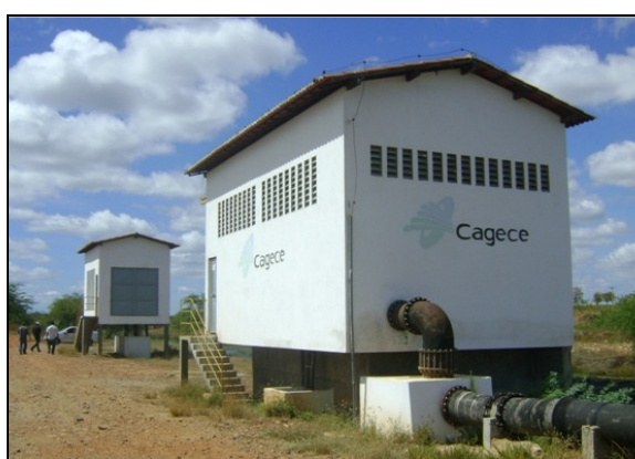
Foto 27 – Prédio de abrigo do quadro de comando da EEAB-01.
