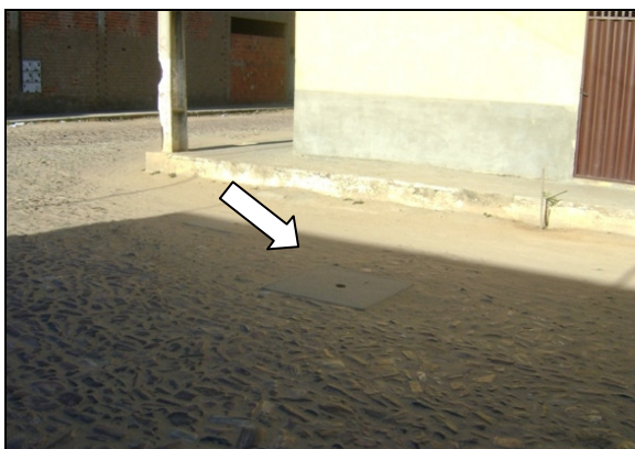
Foto 58 – Registro de descarga localizado na Rua Dom Manuel, Nossa Senhora de Lourdes.
