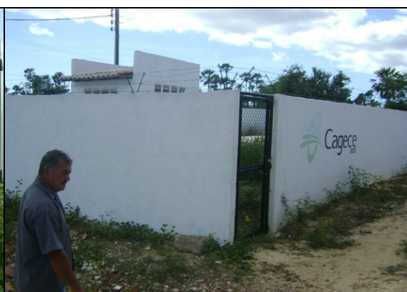
Foto 37 – Muro de proteção da EERD-01.
