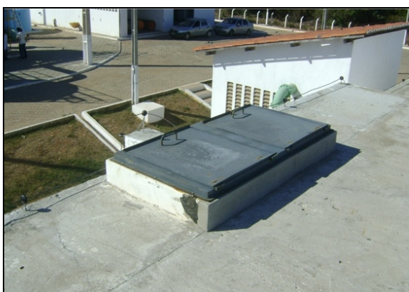
Fotos 40 e 41 – Tampa de inspeção do RAP-01.
