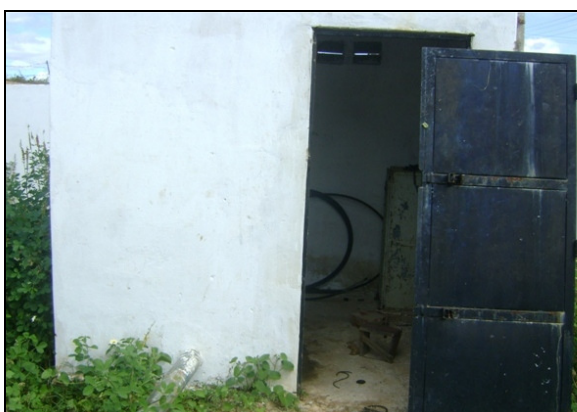
Foto 36 – Prédio de abrigo da EERD-01.
