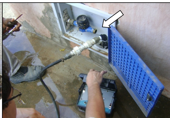
Foto 65 – Medição de pressão sem hidrômetro, na Travessa Coronel Valente, 110 - Centro.
