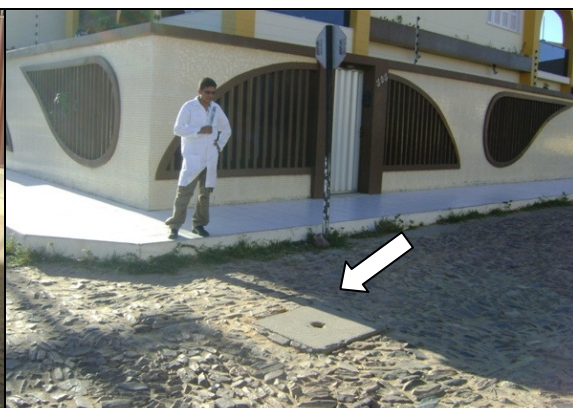
Foto 59 – Registro de descarga localizado na Rua Dom Manuel, Centro.
