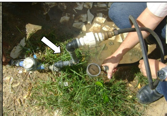
Foto 63 – Medição de pressão sem hidrômetro, na Praça Francisco Rosalino da Silva, Vila São Rafael.
