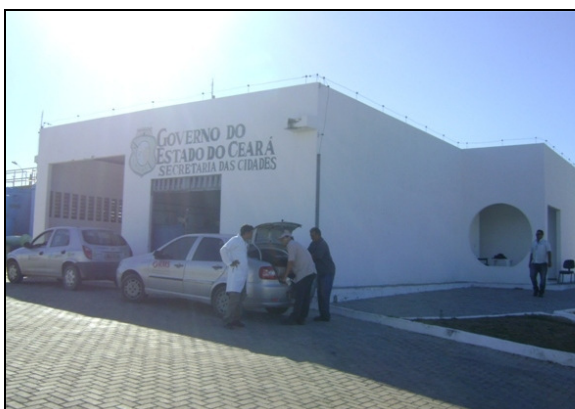
Foto 11 – Vista da casa de química.
