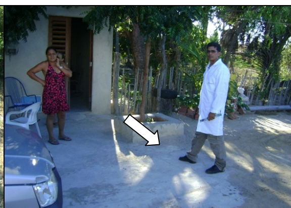
Foto 55 – Registro de descarga localizada na Rua Cel. Pompeu, Nossa Senhora de Lourdes.
