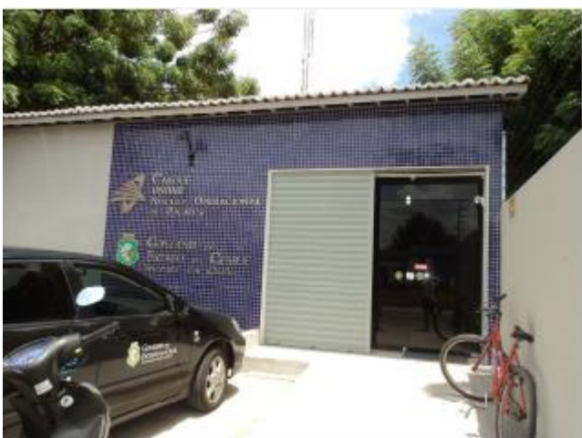
Foto 32 – Loja de atendimento: vista externa.
