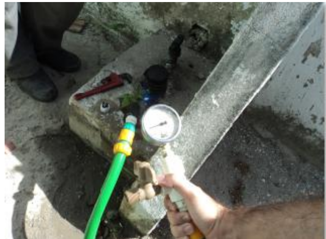
Foto 20 – Medição instantânea de pressão na R. Naide Costa Menezes, nº 405 (Hospital Dr. Paulo Afonso).
