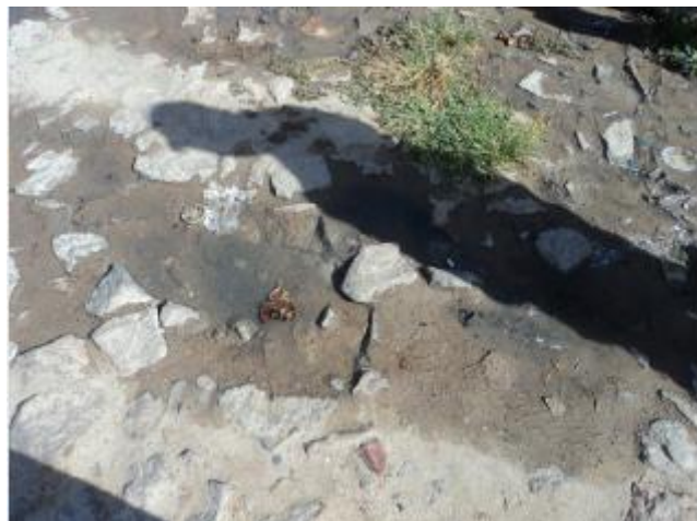
Foto 30 – Registro de descarga na R. Mauro Rodrigues.
