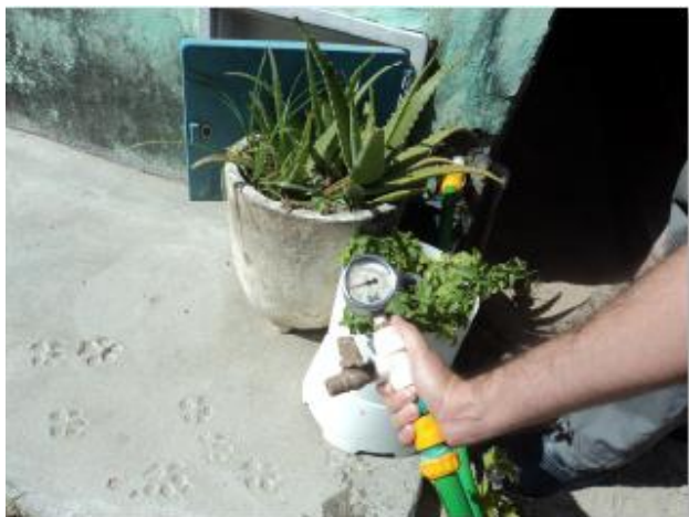
Foto 19 – Medição instantânea de pressão na R. Projetada, SMS-16 – Bairro Cipó.
