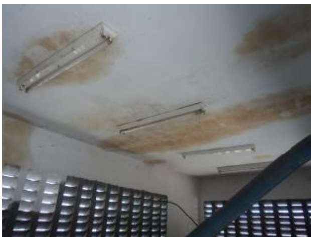
Foto 8 – EEAT-02: ausência de iluminação.
