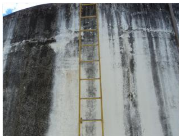
Foto 10 – RAP-06: escada de acesso.
