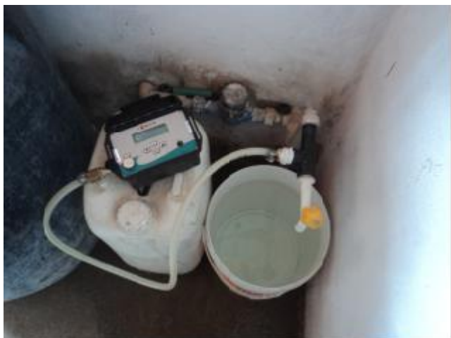
Foto 23 – Medição contínua de pressão na R. Manoel Conrado Filho, nº 10 – Bairro Lagoa Seca.
