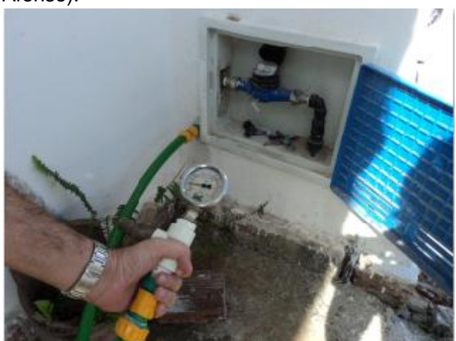
Foto 22 – Medição instantânea de pressão na R. Luiz Braga Jerônimo, nº 163 – Bairro Banguê.
