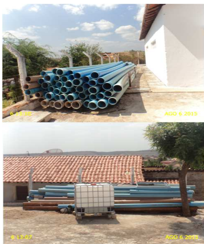
Foto 5 – ETA: tubulação e produto químico armazenados ao ar livre, na área da ETA.
