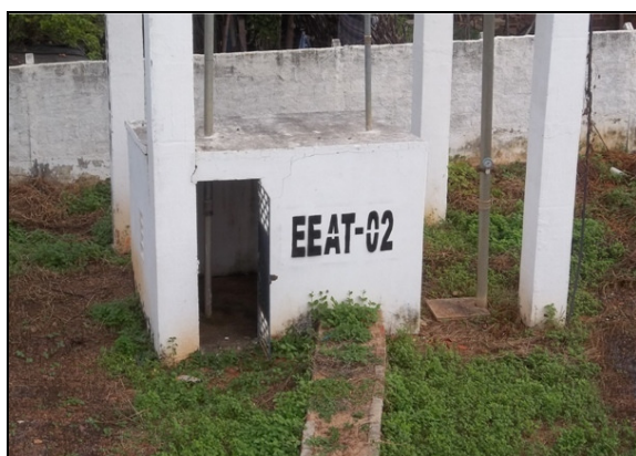
Foto 27 – Prédio de abrigo da elevatória EEAT-02.
