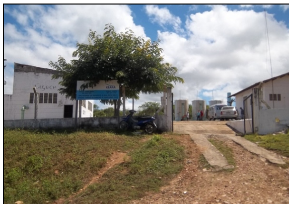
Foto 3 – Entrada da ETA.
