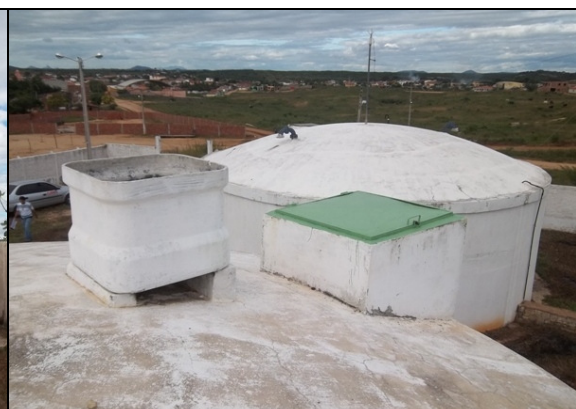
Foto 40 – Inspeção do RAP-04.
