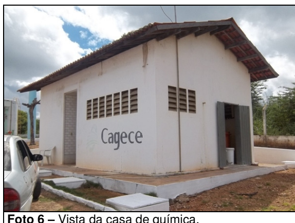
Foto 6 – Vista da casa de química.
