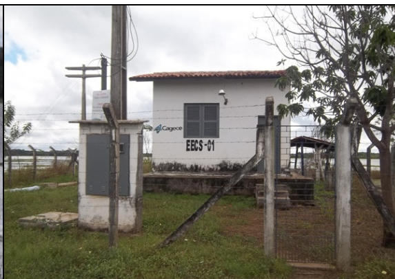
Foto 19 – Prédio de abrigo do quadro de comando da EECS-01.
