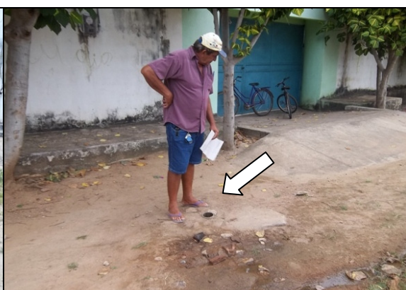
Foto 54 – Registro de descarga, localizado na Rua Luiz Gonzaga Vieira, Nova Hidrolândia.
