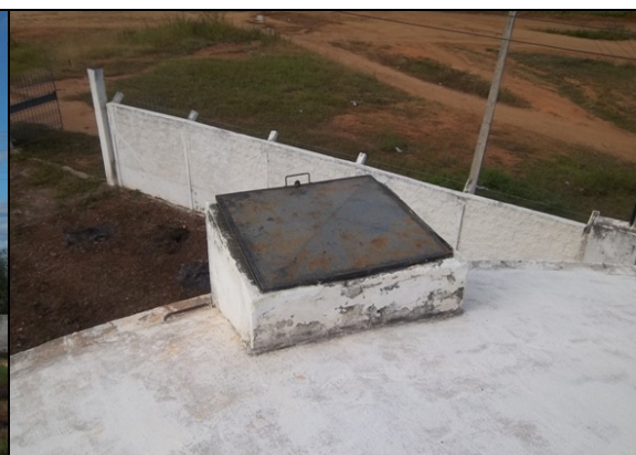
Foto 36 – Inspeção do RAP-03.
