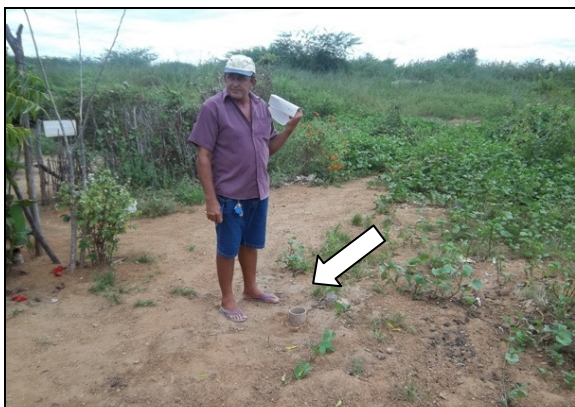
Foto 49 – Registro de descarga sem caixa de proteção, localizado na Av. Antônio Rego Filho, Caixa d'Água.
