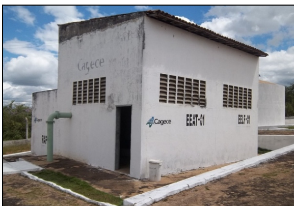
Foto 23 – Prédio de abrigo das elevatórias EELF-01 e EEAT-01.
