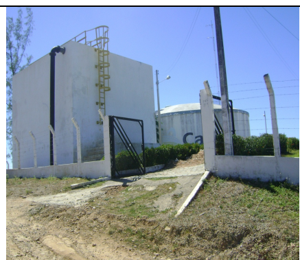
Foto 15 – Floccodecantador: sem identificação.
