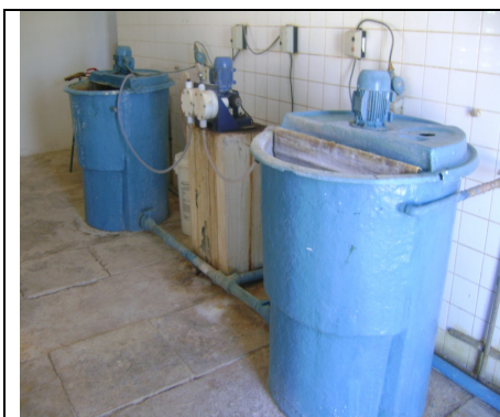
Foto 11 – ETA: área interna da Casa de Química.
