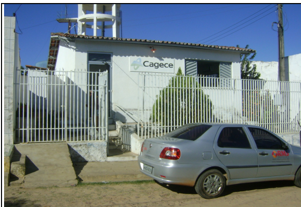
Foto 78 – Vista externa do escritório/loja de atendimento/almoxarifado.
