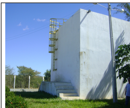
Foto 9 – ETA: vista geral do floccodecantador.
