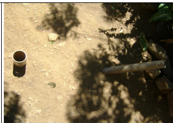
Foto 67 – Registro de descarga localizada na Rua Miguel Rodrigues, 164 – São Benedito, sem caixa de proteção.
