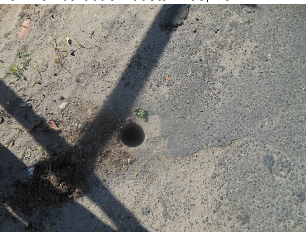
Foto 44 - Registro de descarga sem caixa de proteção localizado na Rua Senador Virgílio Távora, 723.
