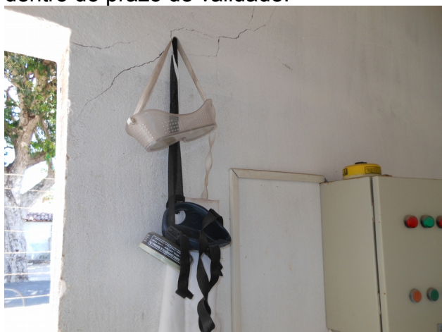
Foto 21 - Casa de Química: EPIs do operador.
