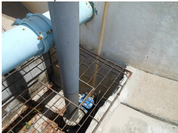
Foto 32 - Reservatório: medidor de nível do RAP-01 com grade de proteção.
