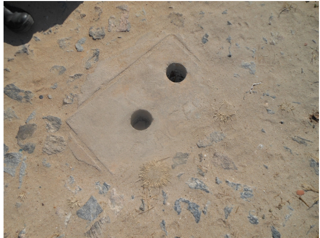
Foto 43 - Registro de descarga localizado na Travessa Mundico Ribeiro, 04.
