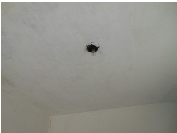
Foto 28 - Elevatória: iluminação no prédio de abrigo da EEAT-01.
