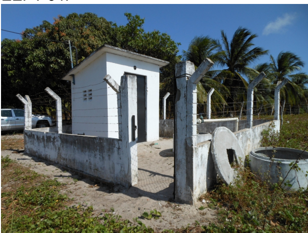
Foto 11 - Captação: ausência de identificação do PT-06 e da EEPT-06.
