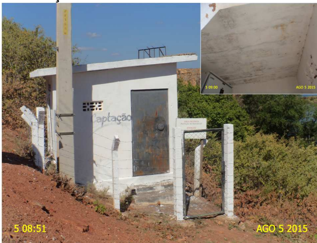
Foto 7 – EECS-01: casa de abrigo sem iluminação
