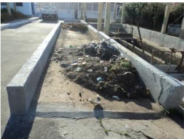
Foto 11 – EEE-Malvas: retirada do material do gradeamento.
