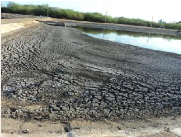
Foto 15 – ETE-Malvas: lagoa anaeróbia desativada com acúmulo de material sedimentado.
