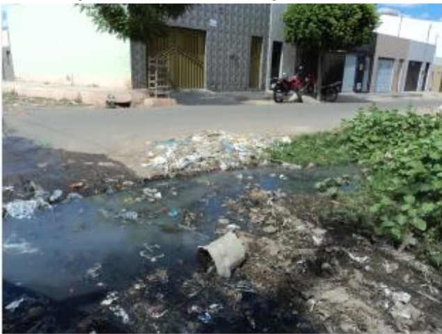
Foto 21 – Esgoto a céu aberto na Rua Enerstina Sobreira com Rua Epitácio Pessoa.
