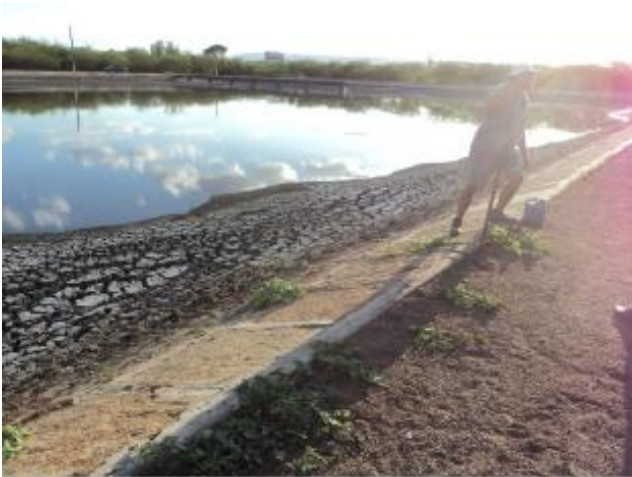
Foto 19 – ETE-Malvas: operador realizando manutenção dos taludes da lagoa.
