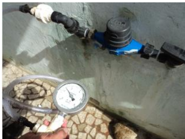
Foto 3 – Medição instantânea de pressão na Rua São Vicente, 94 – Socorro.
