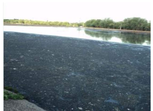
Foto 16 – ETE-Malvas: lagoa anaeróbia desativada com acúmulo de material sedimentado.
