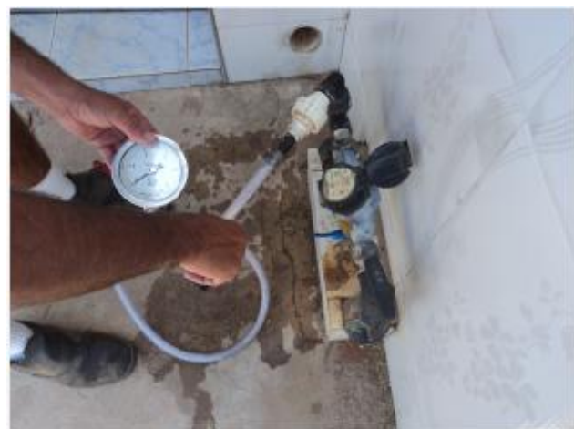
Foto 5 – Medição instantânea de pressão na Rua dos Pombos, 240 Horto.
