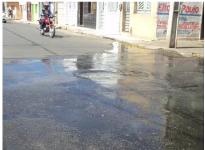
Foto 22 – Foto 23 – Estravasamento do PV na Rua Rui Barbosa com Rua Limoeiro.
