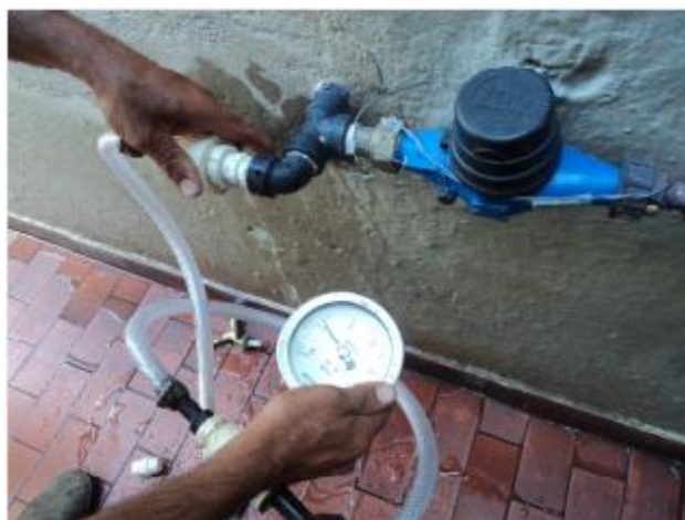
Foto 2 – Medição instantânea de pressão na Rua Santa Clara, 567 (prox. Igreja Salesianos).
