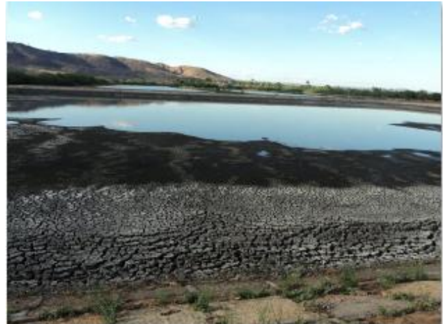
Foto 14 – ETE-Malvas: lagoa anaeróbia desativada com acúmulo de material sedimentado.
