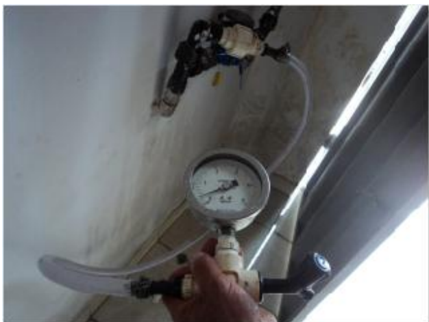
Foto 1 – Medição instantânea de pressão na Rua Ernestina Sobreira, 144ª – Franciscanos.
