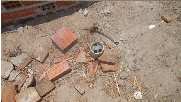
Foto 17 - Registro de descarga na rede de distribuição, localizado na Rua Maria Glória da Conceição, em frente ao nº 488 – Centro (Soterrado).
