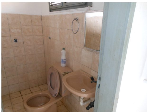
Foto 21 - Comercial/Escritório: instalações sanitárias.
