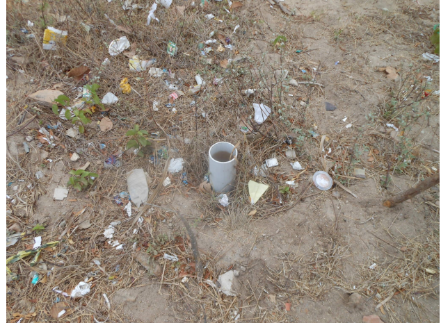
Foto 9 - Registro de descarga na rede de distribuição, localizado ao lado do Centro Educacional Patricia Mota de Freitas – estrada para Mulungu – Novo Horizonte.
