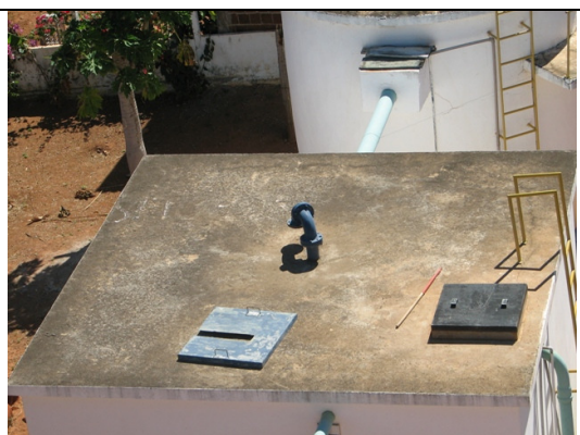
Foto 24 – Vista superior do RAP-01
