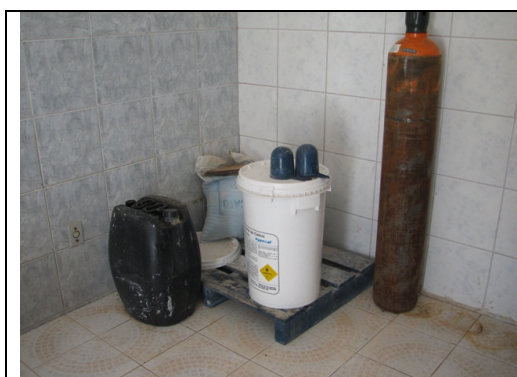
Foto 09 – Armazenamento inadequado de produtos químicos
