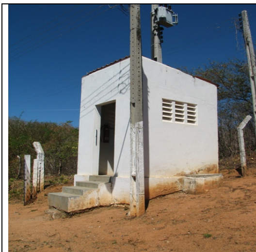
Foto 19 – Casa do quadro elétrico da EECS-01
