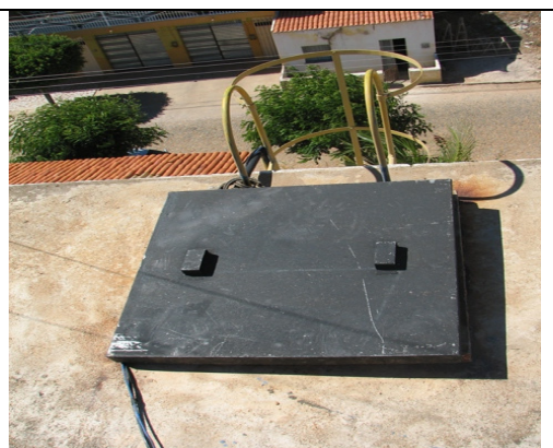
Foto 26 – Vista da laje superior e tampa do REL-01
