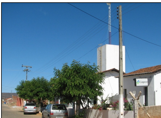
Foto 25 – Vista parcial do REL-01
