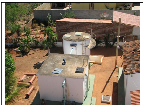
Foto 06 – Vista da ETA do SAA de Quiterianópolis
