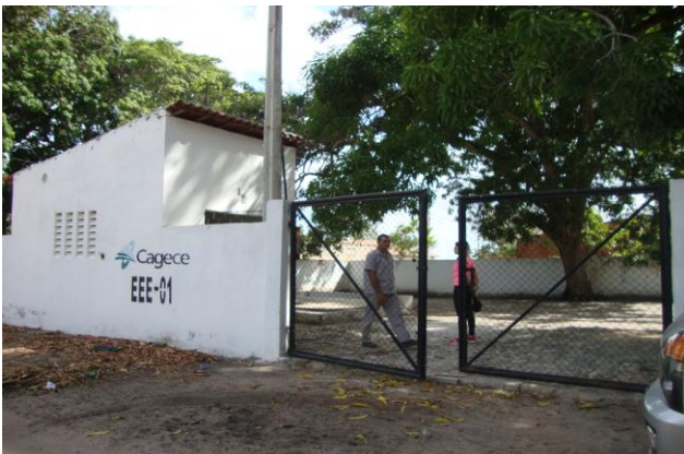
Foto 46 – EEE-01: vista externa.
