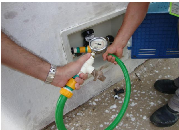
Foto 40 – Medição de pressão na Rua Cesário Pereira, s/n- Centro.
