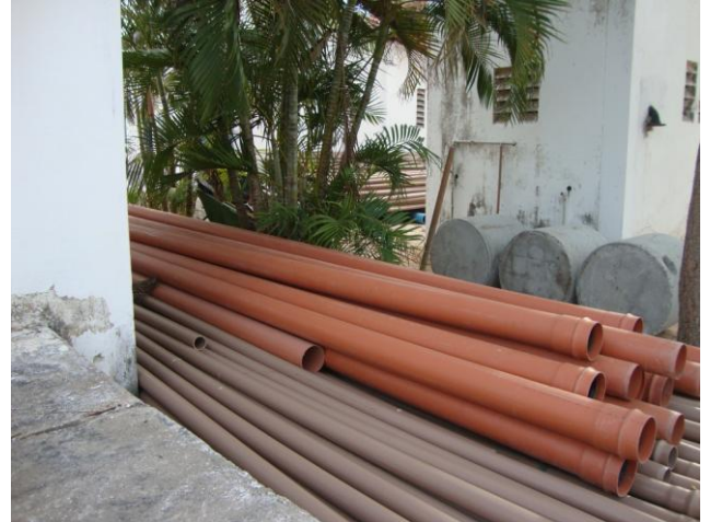
Foto 84 – Armazenamento de materiais de forma inadequada na área do tratamento.
