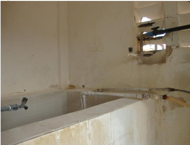
Foto 14 – Tanque para solução de hipocal.
