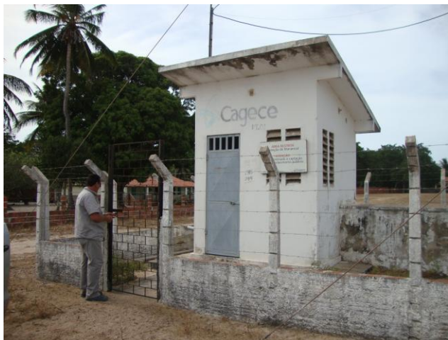
Foto 1 – PT-01: vista geral.
