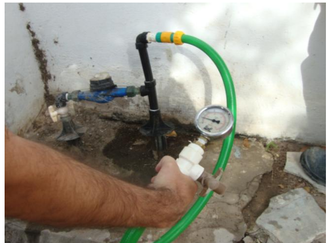
Foto 39 – Medição de pressão na Rua Marçal de Sousa, nº 757 – Centro.
