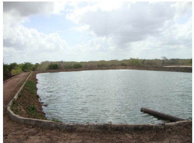
Foto 72 – ETE: lagoa de maturação I.
