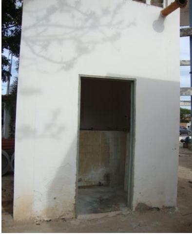
Foto 12 – Vista externa da casa de química.
