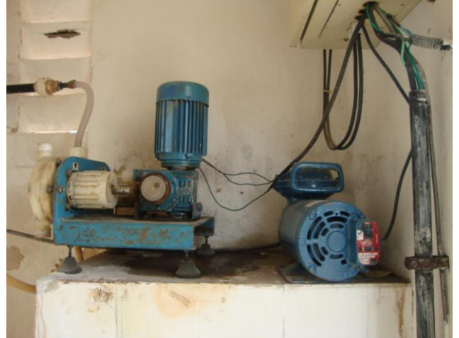
Foto 13 – Bomba dosadora da solução de hipocal.
