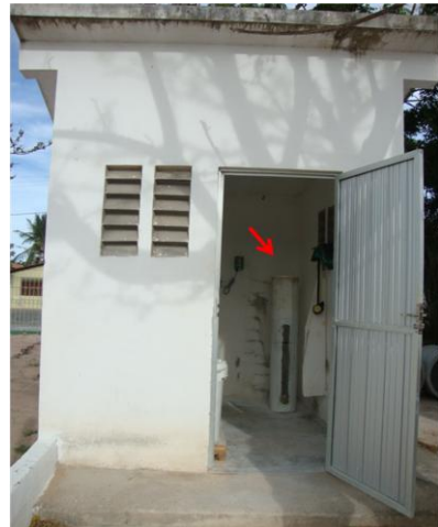
Foto 15 – Vista externa da casa do dosador de flúor.
