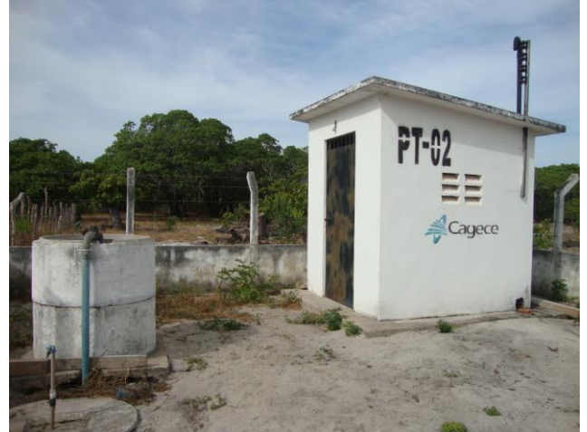
Foto 8 – PT-02: vista interna da área.
