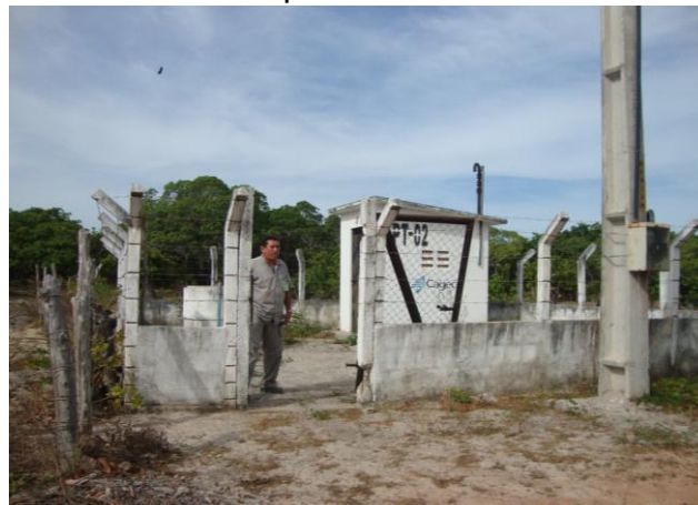
Foto 6 – PT-02: ausência de placa indicativa da área como pertencente à CAGECE.
