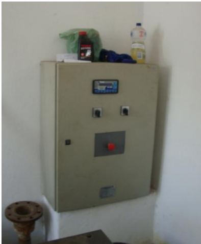
Foto 62 – EEE-02: caixa de registro.
