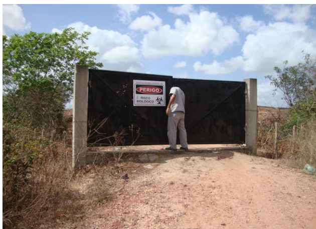
Foto 67 – ETE: portão de entrada sem identificação.
