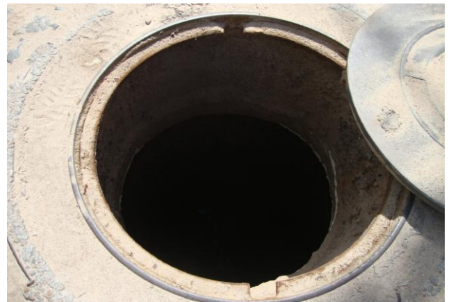
Foto 45 – PV na Rua Minas Gerais.
