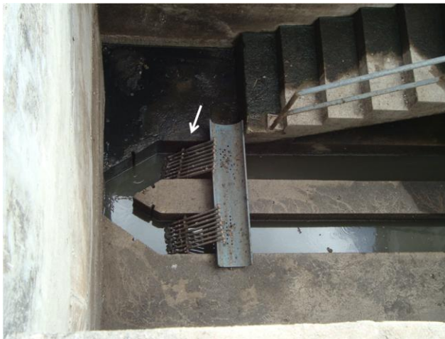
Foto 56 – EEE-02: gradeamento improvisado.
