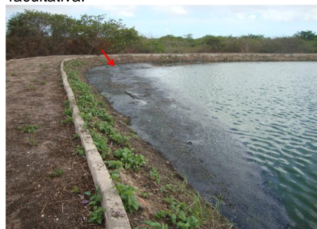
Foto 70 – ETE: lagoa facultativa com sobrenadante.
