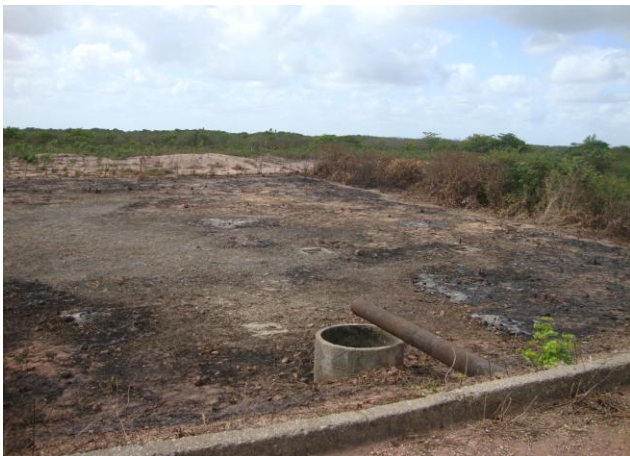
Foto 66 – Ponto de lançamento do efluente da ETE de Jijoca.
