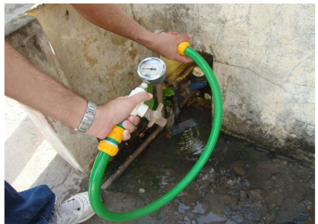
Foto 41 – Medição de pressão na Rua Minas Gerais (Forum) – Centro.
