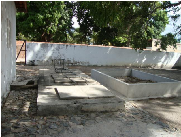
Foto 48 – EEE-01: vista dos poços do tratamento preliminar e sucção e do leito de secagem.
