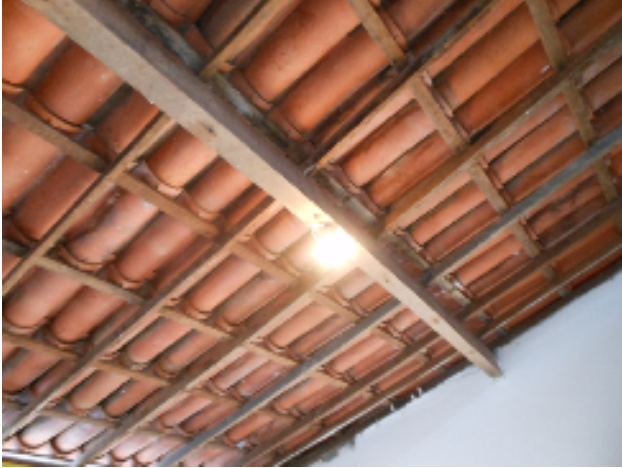
Foto 19 - Depósito: Iluminação no depósito.
