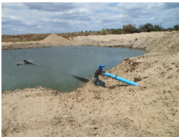
Foto 2 - Vista da captação no Rio Curu.
