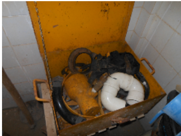
Foto 14 - Kit de emergência do cloro gasoso.
