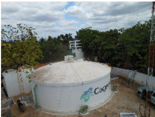
Foto 47 - Vista do reservatório RAP-01.
