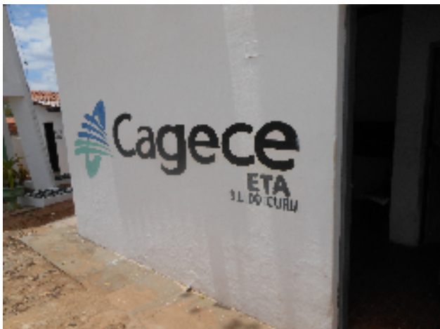
Foto 25 - Prédio de abrigo da EEAT-01.
