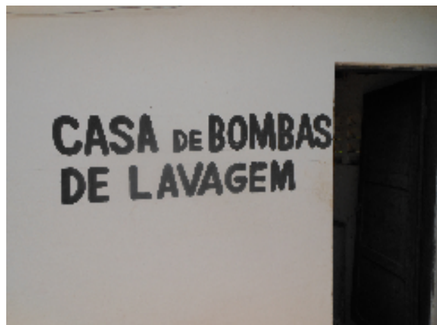
Foto 36 - Identificação da casa de bombas para Lavagem de filtros.
