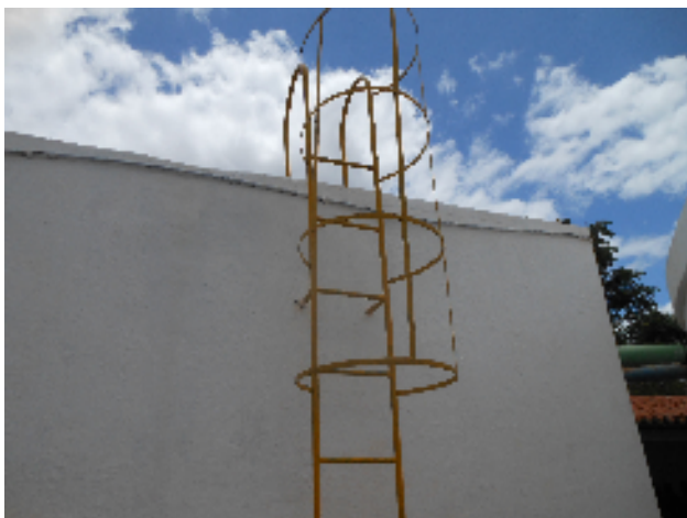
Foto 45 - Guarda-corpo do RAP-01.
