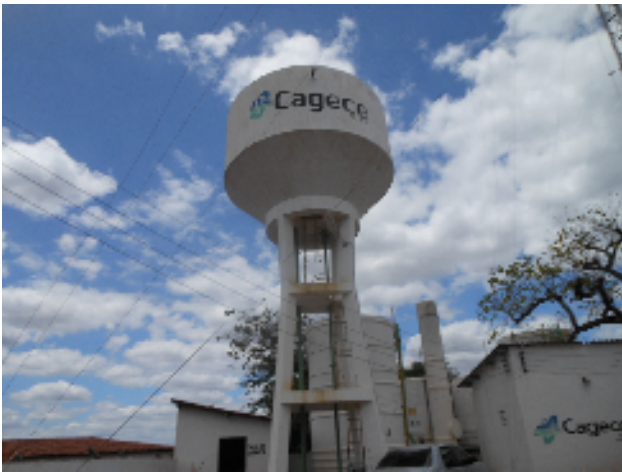
Foto 53 - Reservatório: Identificação do REL-01.
