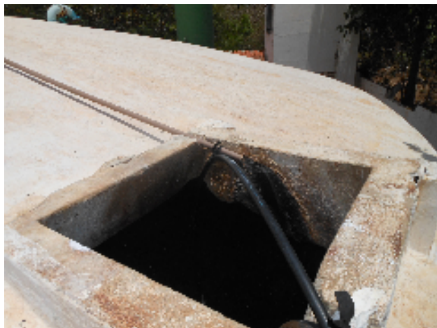
Foto 48 - Reservatório apoiado sem tampa.
