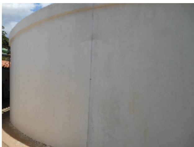
Foto 50 - Reservatório: medidor de nível do RAP-01.
