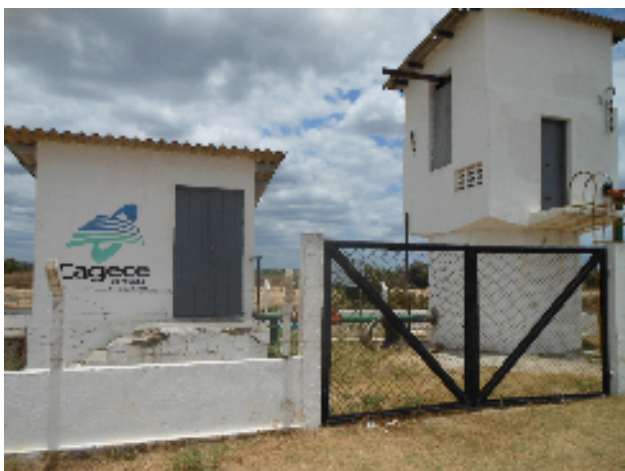
Foto 1 - Entrada da captação identificada.
