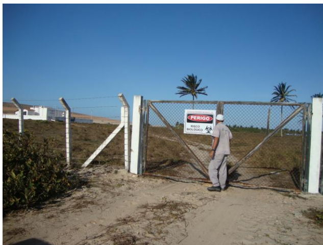
Foto 63 – ETE: portão de entrada.
