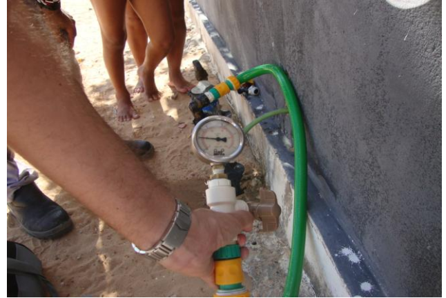
Foto 36 – Medição de pressão na Rua das Dunas, s/n.
