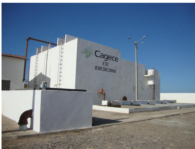
Foto 65 – ETE: vista interna.
