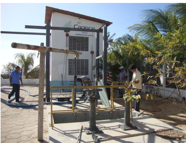
Foto 43 – EEE-01: em manutenção (vista interna).
