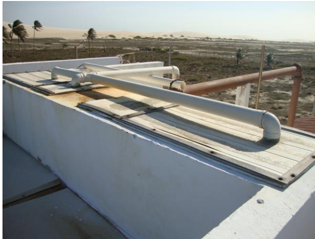
Foto 69 – ETE: coleta do biogás liberado do DAFA.
