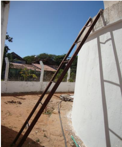
Foto 23 – RAP-01: escada de acesso.
