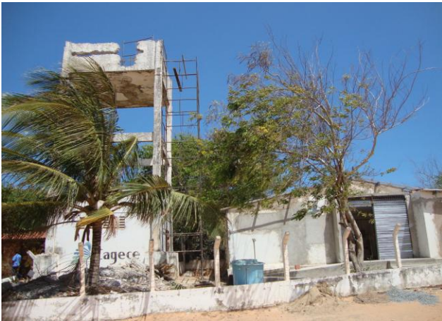
Foto 82 – Vista do escritório/loja de atendimento ao usuário em reforma.
