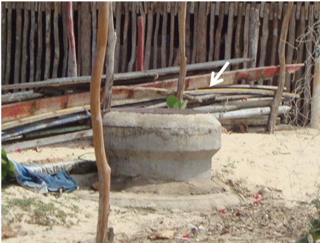
Foto 40 – PV próximo à praia.
