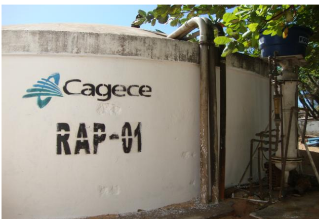
Foto 21 – RAP-01: vista geral.
