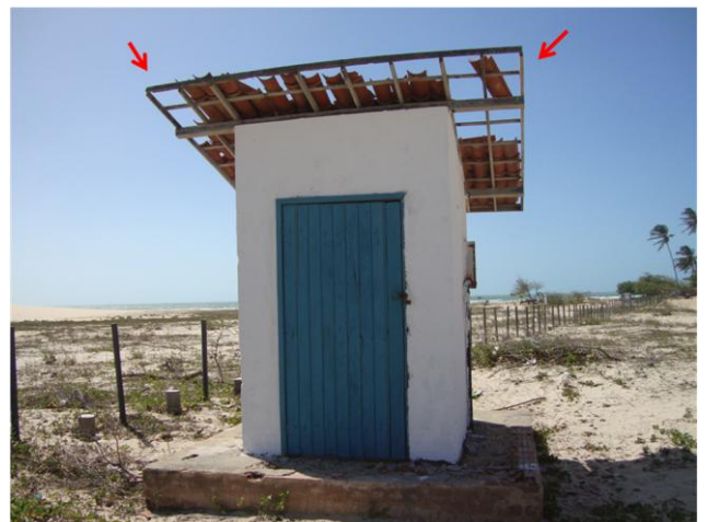
Foto 4 – PT-03 e PT-04: casa de abrigo do quadro de comando.
