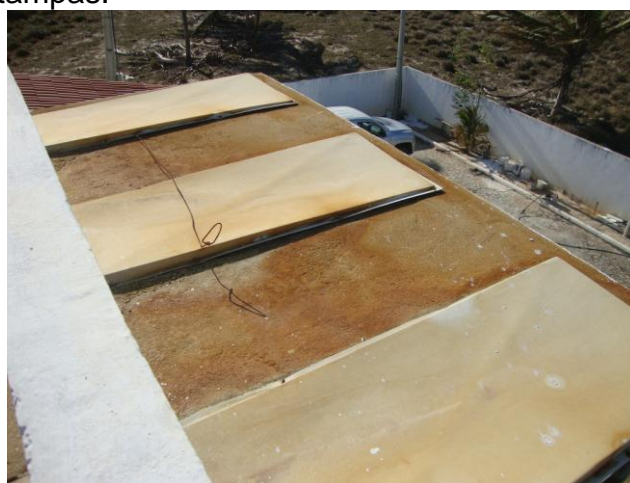
Foto 68 – ETE: calhas coletoras do DAFA com tampas.
