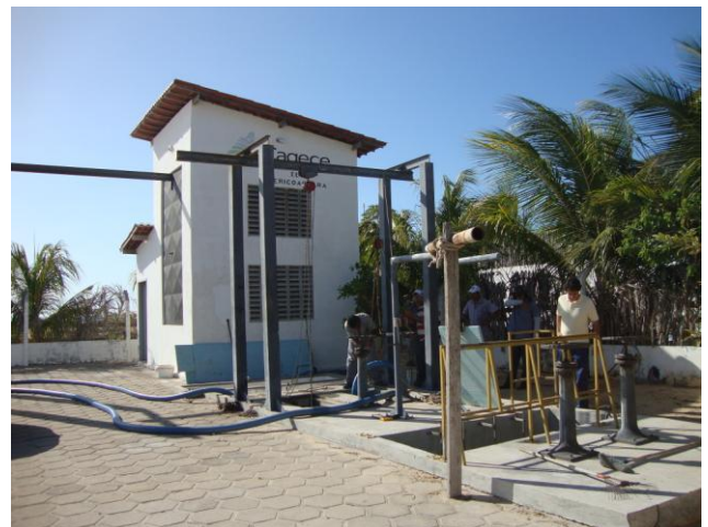
Foto 42 – EEE-01: em manutenção (vista interna).
