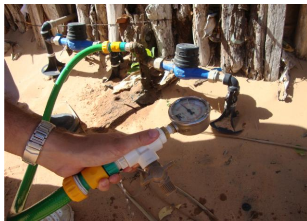
Foto 32 – Medição de pressão na Rua da Matriz, s/n.
