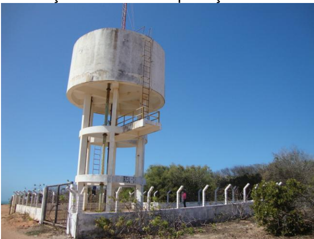
Foto 27 – REL-01: vista geral.
