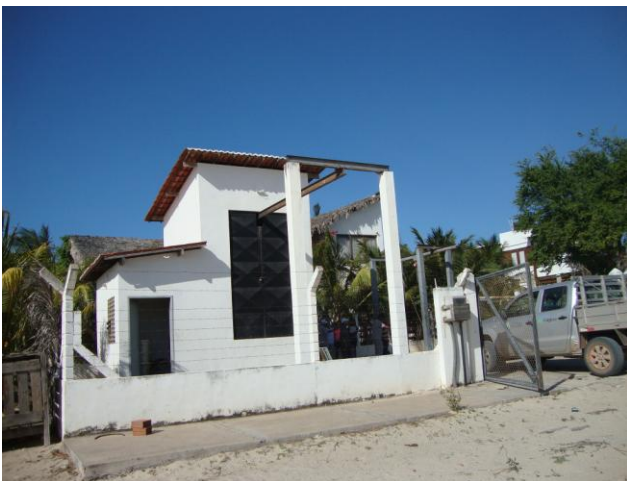
Foto 41 – EEE-01: Vista externa.
