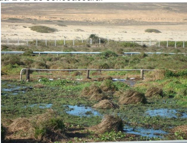
Foto 61 – Tubulação de distribuição de esgoto.
