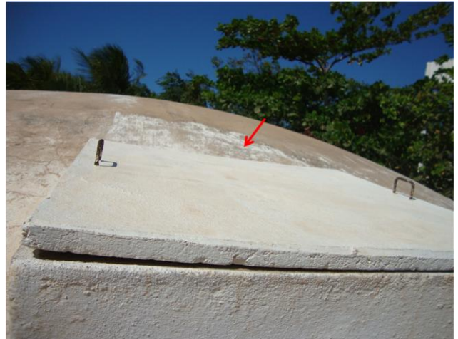
Foto 24 – RAP-01: com tampa de inspeção.
