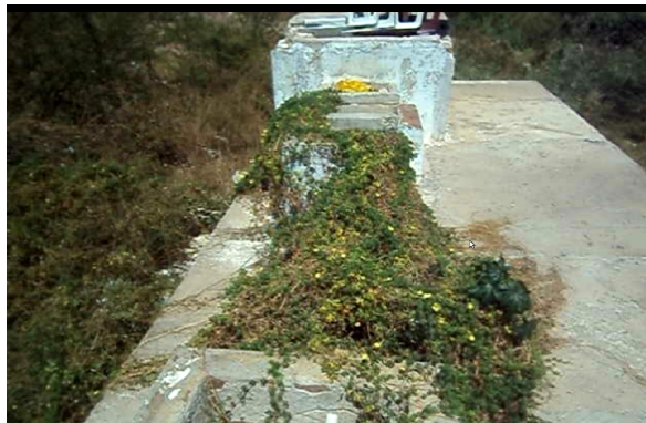
(c) Caixa de cloração.
