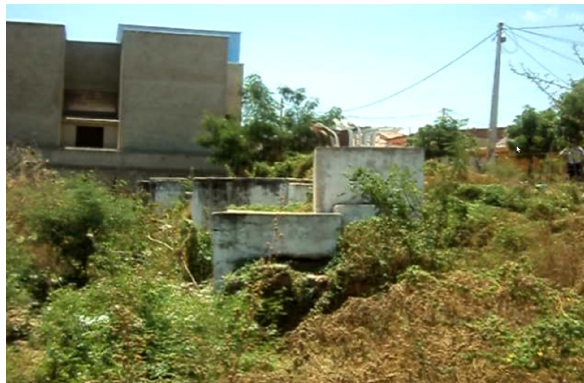
(a) Área e instalações da ETE tomada pela vegetação.
