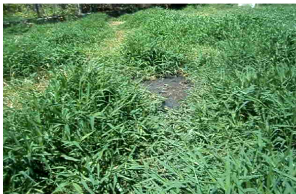
(c) Esgoto bruto extravasando.
