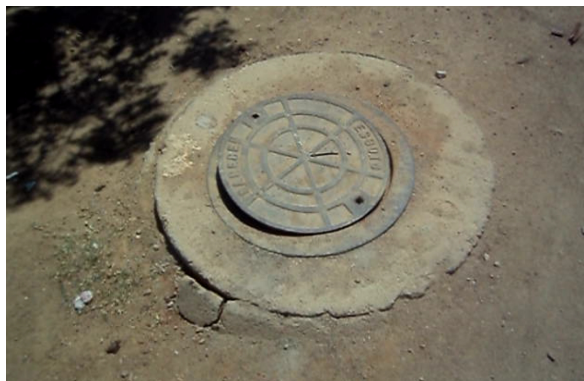
(a) Poço de Inspeção na rede, na chegada da ETE, com a grafia CAGECE na tampa.
