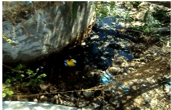
(d) Esgoto bruto extravasando.
