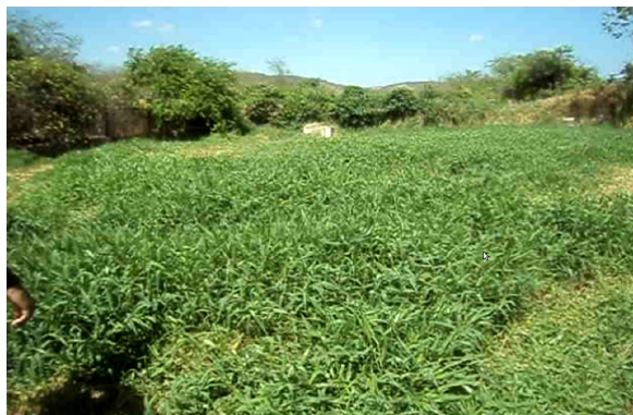
(b) Área e instalações da ETE tomada pela vegetação.
