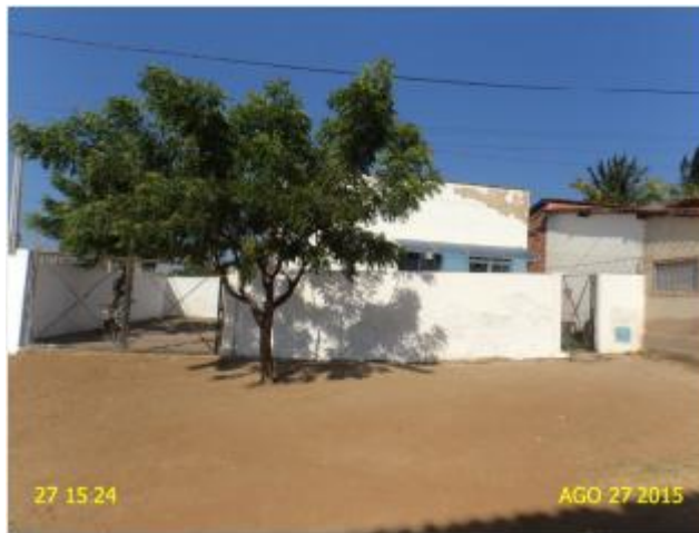
Foto 19 – Escritório: ausência de identificação.
