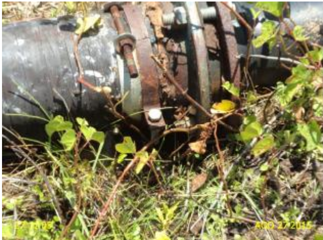
Foto 6 – AAB: vazamento na tubulação próxima à captação.
