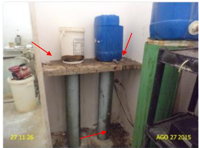
Foto 7 – Casa de química: condições inadequadas de limpeza.
