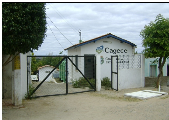
Fotos 61 – Vista externa do escritório da CAGECE.
