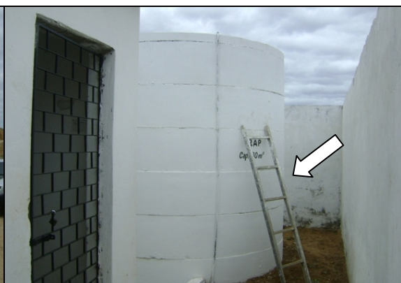
Foto 45 – Escada de acesso do RAP-03.
