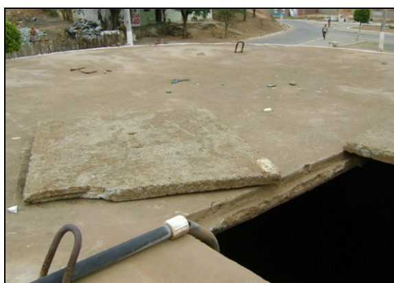
Fotos 46 – Inspeção do RAP-03.
