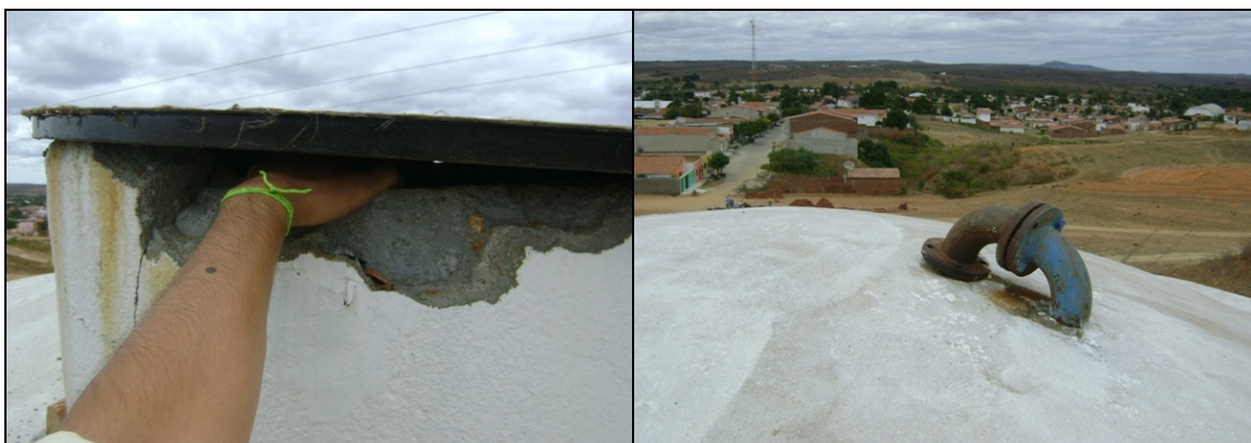
Foto 41 – Inspeção do RAP-02.
