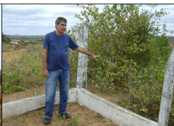
Foto 38 – Cerca do reservatório RAP-02.
