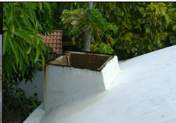
Foto 34 – Inspeção do RAP-01.
