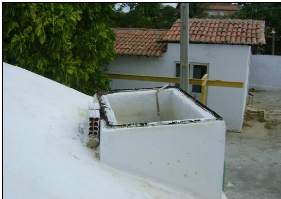
Foto 33 – Inspeção do RAP-01.
