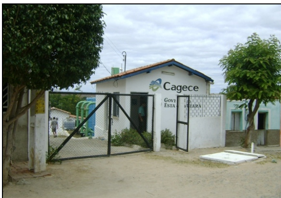
Foto 3 – Entrada da ETA.
