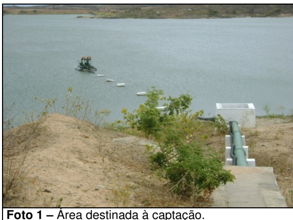
Foto 1 – Área destinada à captação.
