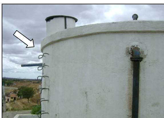
Foto 43 – Escada e inspeção do RAP-02.
