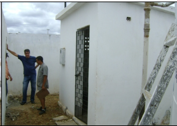
Foto 30 – Casa de comando da EEAT-03.
