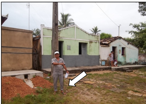
Foto 51 – Registro de descarga soterrado, localizado na Rua 11 de maio, Centro.
