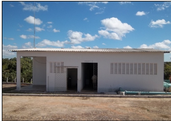
Foto 8 – Vista do prédio onde funciona a casa de química.
