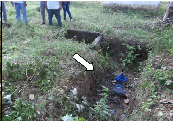
Foto 35 – Registro de descarga sem caixa de proteção.
