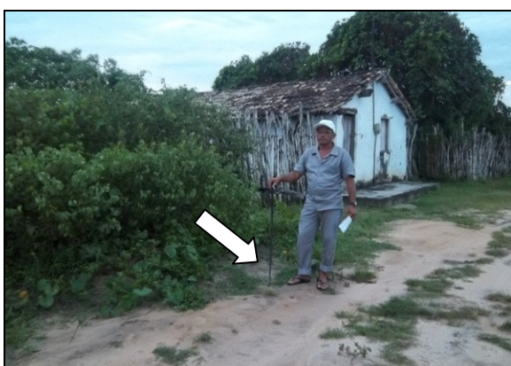
Foto 55 – Registro de descarga soterrado, localizado na Rua do Hospital, Centro.
