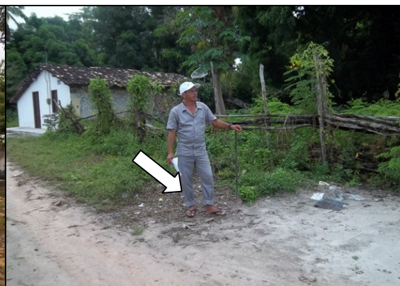
Foto 52 – Registro de descarga soterrado, localizado na Rua Francisco Benício Vasconcelos, Centro.
