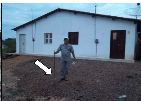
Foto 56 – Registro de descarga soterrado, localizado na Rua Pequena, Centro.
