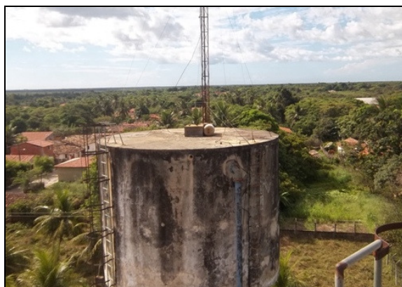
Foto 40 – Inspeção e ventilação do REL-04.
