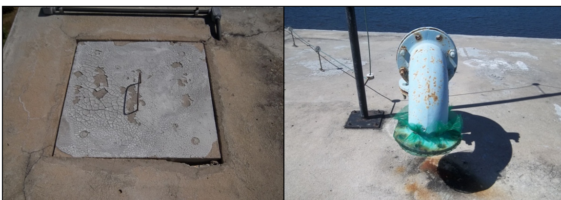
Foto 32 – Inspeção do REL-01.
