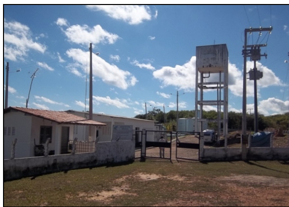
Foto 3 – Entrada da ETA.
