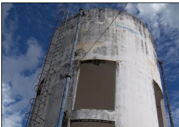
Foto 41 – Vista do REL-06.
