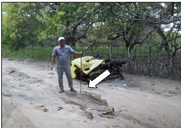
Foto 53 – Registro de descarga soterrado, localizado na Rua Estrada da Ilha, Centro.
