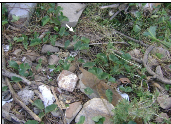
Foto 57 – Registro de descarga soterrado, localizado na Rua Matias de Rocha.
