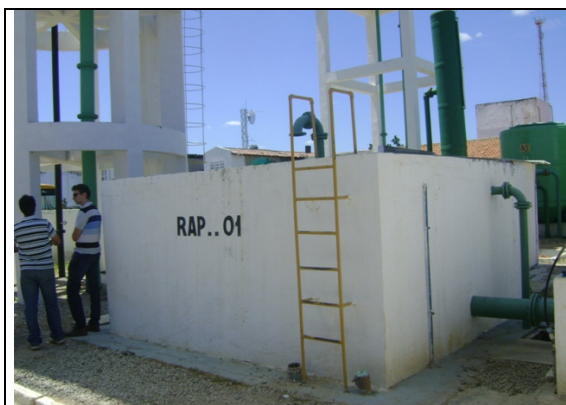
Foto 37 – RAP-01: Existência de identificação.
