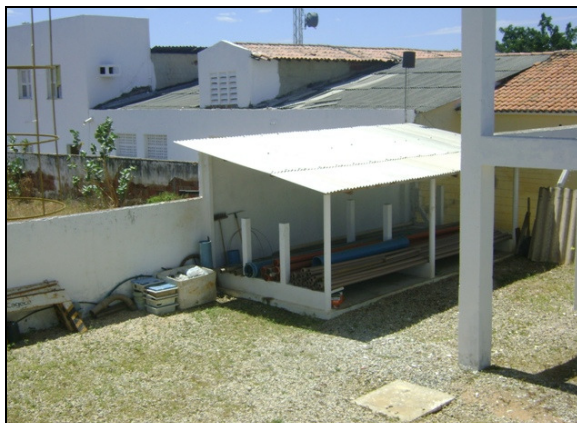
Foto 3 – Vista interna da ETA.
