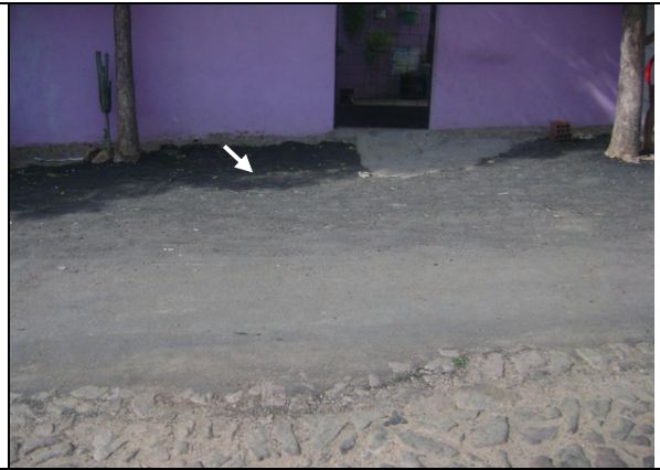
Foto 53 – Registro de descarga soterrado, localizado na Rua Moacir Gama.
