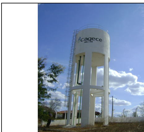
Foto 45 – REL-02: Existência de identificação.
