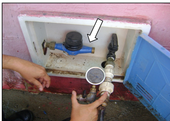
Foto 65 – Medição de pressão na Rua Santa Ana, n° 58, Centro.
