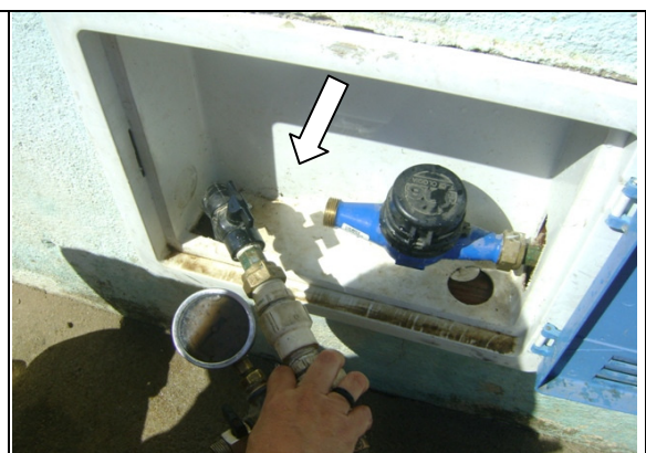
Foto 62 – Medição de pressão na Av. Perimetral Novo Tempo, s/n, Arruda
