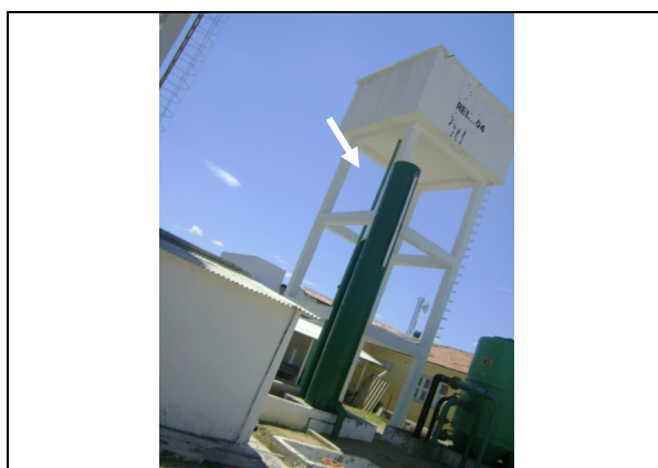
Foto 5 – Torre de equilíbrio.
