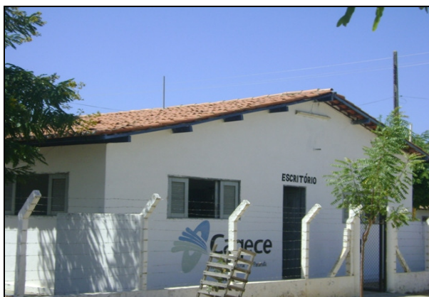
Foto 66 – Vista externa do escritório/loja de atendimento ao usuário.
