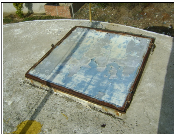
Foto 49 – REL-03: Tampa de inspeção adequada.
