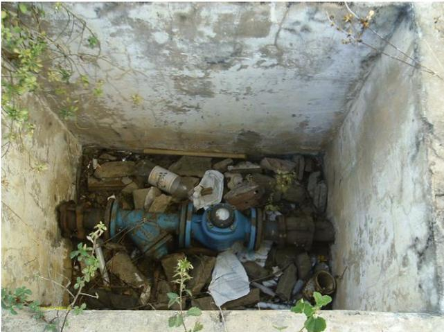
**Foto 13** - Medidor proporcional sem tampa ou grade de proteção na área do REL - 25 Sussuanha.
