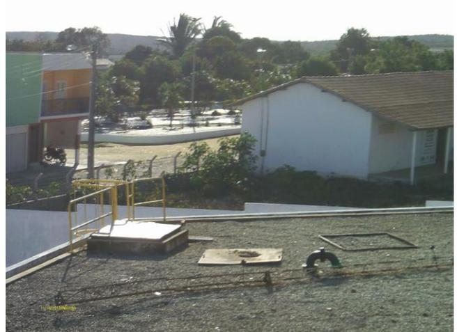
**Foto 31** - RAP-13: cobertura, tampa de inspeção e tubulação de ventilação sem tela de proteção.
