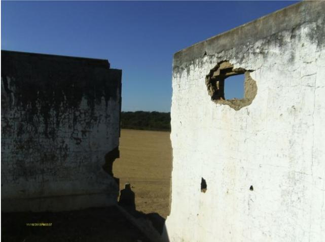
**Foto 36** - REL-25 Sussuanha: muro da área de delimitação do reservatório danificado.
