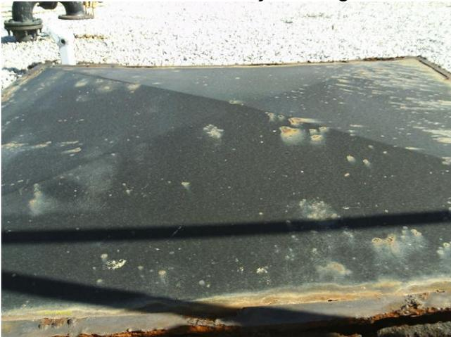
**Foto 26 - RAP-12: tampa de inspeção em processo de corrosão.**
