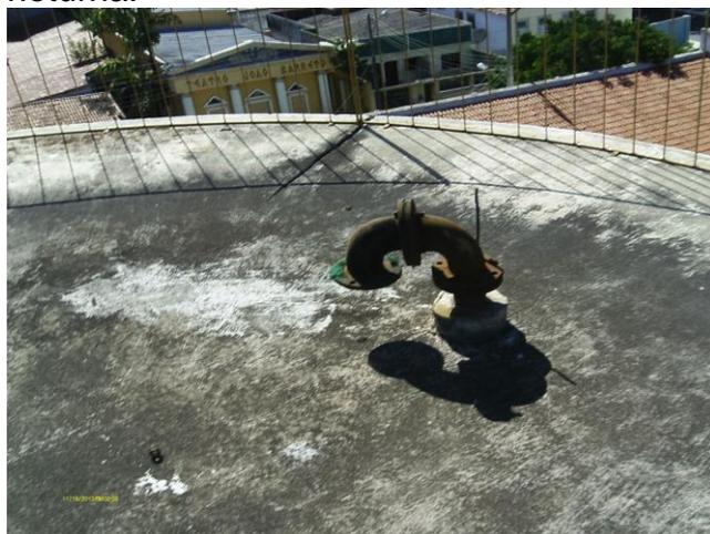
**Foto 45** - REL-27: tubulação de ventilação parcialmente sem tela de proteção.
