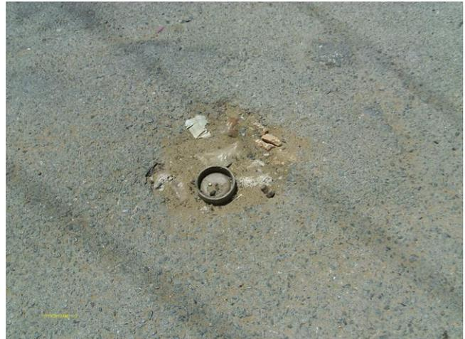
**Foto 58** - Registro de descarga na rede de distribuição na Rua Pe Antônio José de Lima (tampa coberta pelo asfalto).
