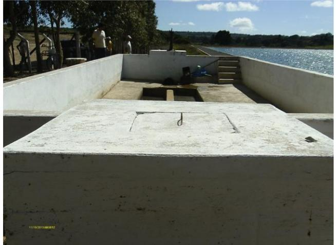
**Foto 78** - ETE: caixa de recepção do esgoto bruto e vista parcial do tratamento preliminar.
