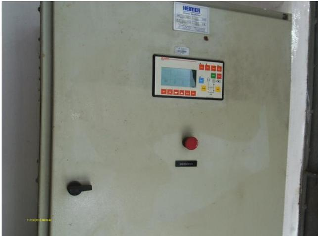
**Foto 71** - EEE-01: quadro de comando do grupo gerador de energia elétrica.
