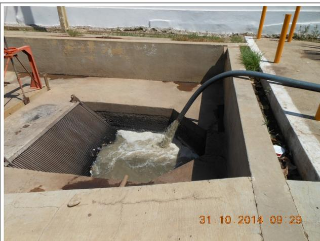
**Foto 4** – EEE Malvas: Gradeamento e descarga de caminhão limpa-fossa
