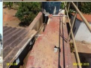
Foto 12 – Filtração: armadura exposta, sinais de vazamento, pintura e piso deteriorados.
