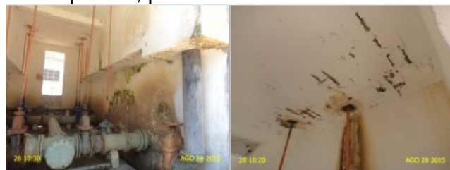
Foto 10 – Casa de química: área do cloro gasoso com instalações elétricas inadequadas, pintura e reboco deteriorados.
