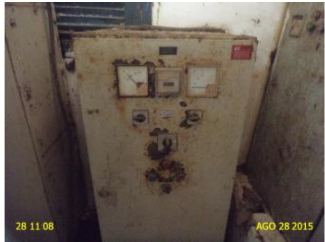
Foto 6 – EECS-01: quadro de comando deteriorado.
