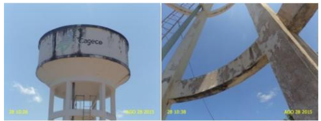
Foto 28 – RAP-01: excesso de vegetação, ausência de identificação e pintura deteriorada.
