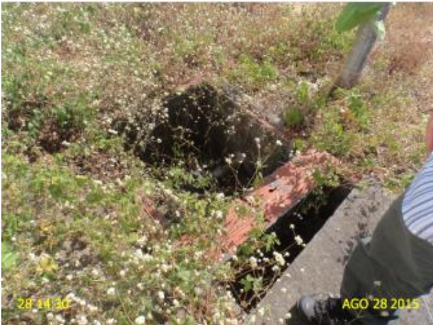
Foto 27 – REL-06: caixa sem tampa ou grade de inspeção e excesso de vegetação.
