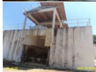
Foto 12 – Filtração: armadura exposta, sinais de vazamento, pintura e piso deteriorados.
