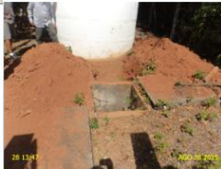
Foto 29 – REL-02 e REL-06: materiais de construção na área do reservatório.
