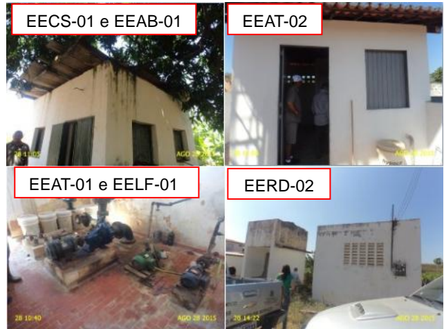
Foto 16 – EECS-01, EEAB-1, EEAT-01, EEAT-02, EELF-01 e EERD-02: ausência de identificação.
