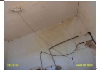
Foto 10 – Casa de química: área do cloro gasoso com instalações elétricas inadequadas, pintura e reboco deteriorados.
