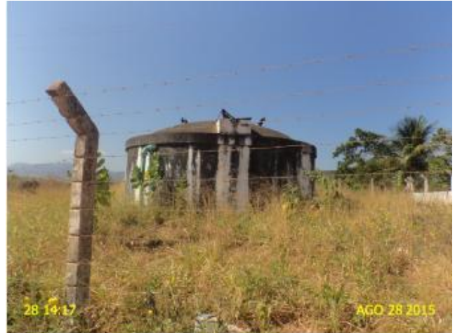
Foto 28 – RAP-01: excesso de vegetação, ausência de identificação e pintura deteriorada.
