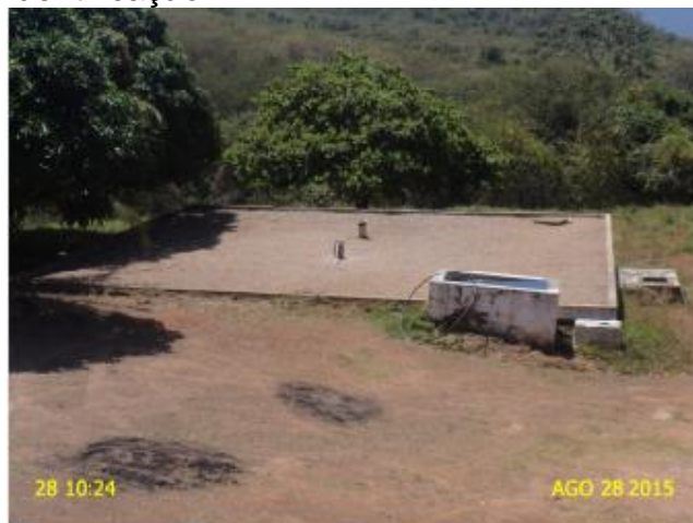
Foto 38 – RSE-03: ausência de identificação.
